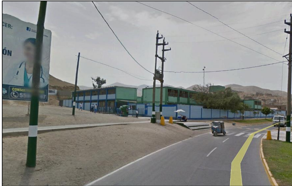
Figura 1: Vista Frontal izquierda de la infraestructura a demoler del I.E. Fuente: (A.B.C. Arquitectos Ingenieros S.R.L.,2020)
