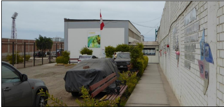
Figura 3: Vista desde el acceso principal, infraestructura a demoler- CONADIS Fuente: (A.B.C. Arquitectos Ingenieros S.R.L.,2019)
