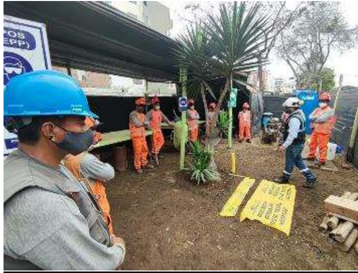
Figura 8. Ejecución de obra
