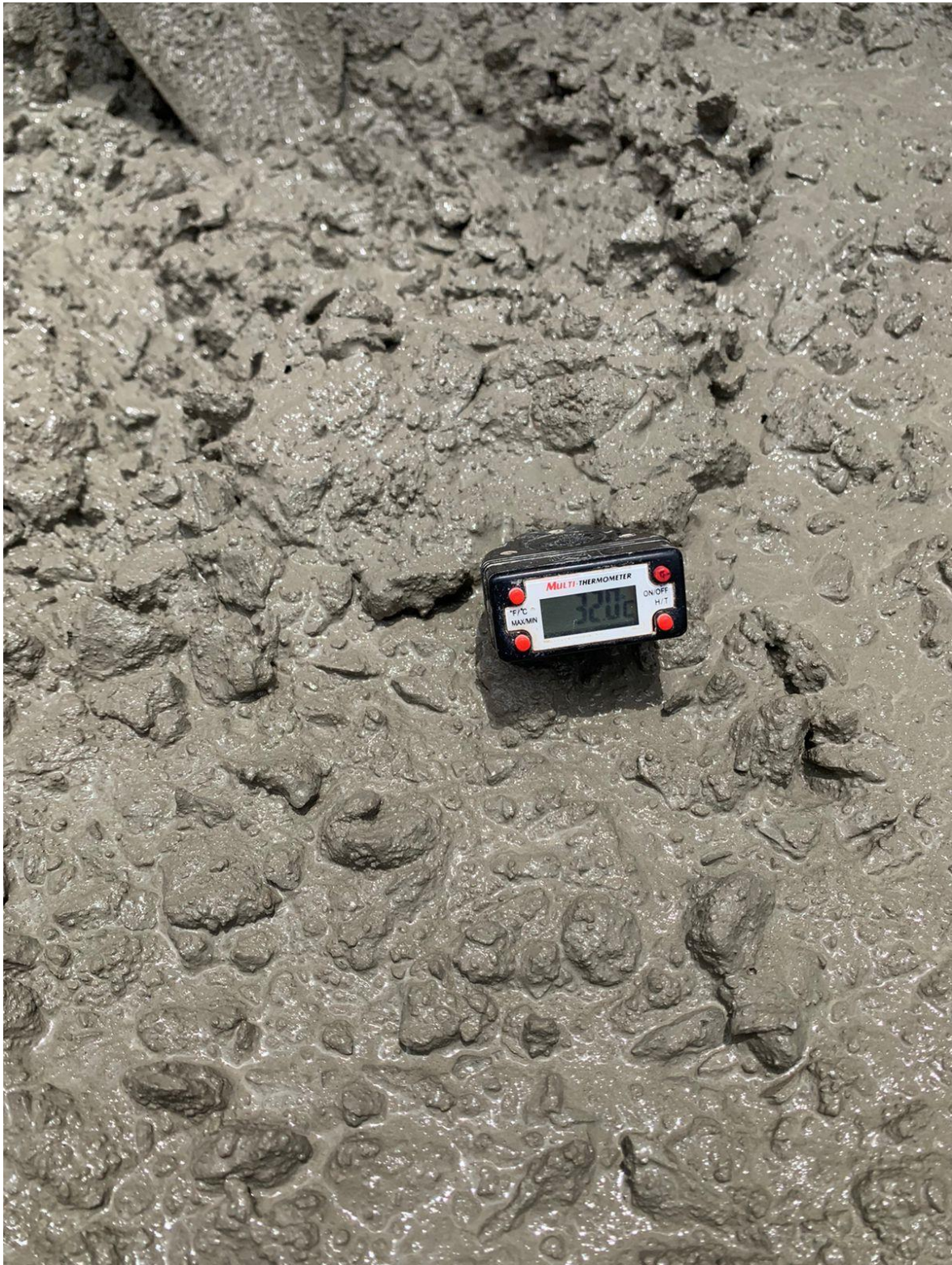
Figura 16. Lectura de temperatura de un tipo de concreto
