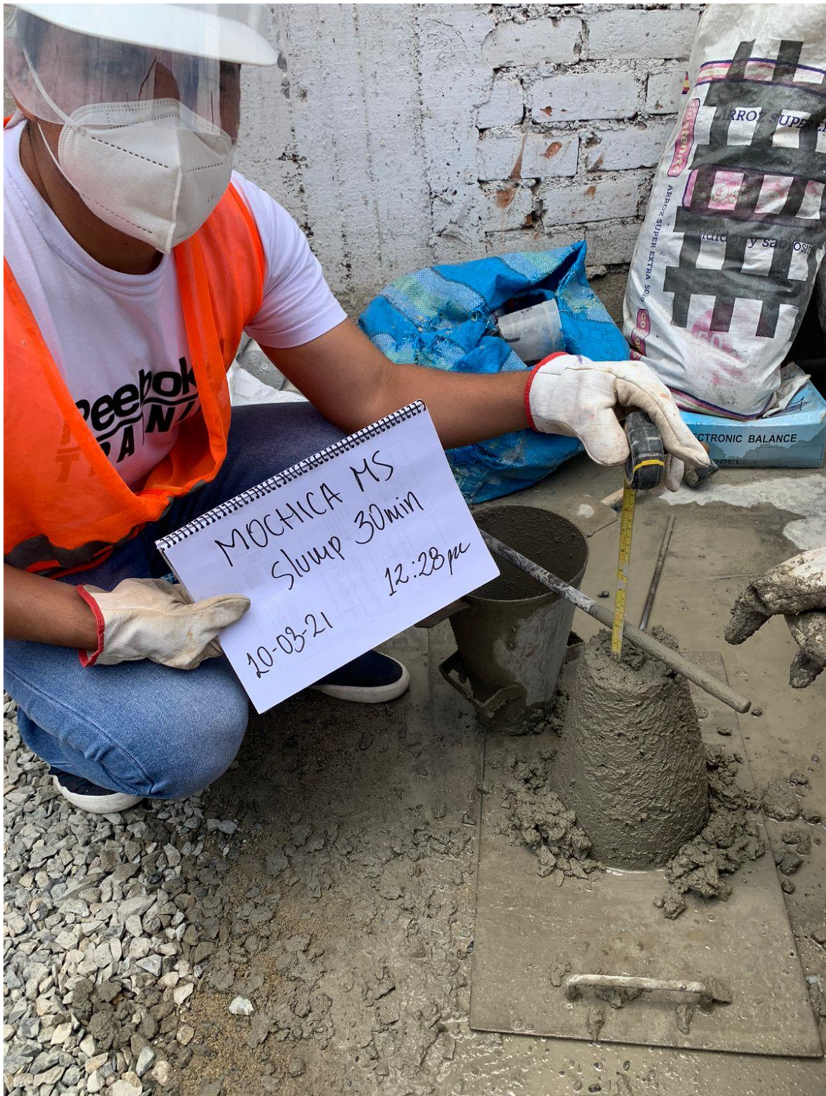
Figura 13. Verificación de Slump del concreto Elaborado con Cemento Mochica MS
