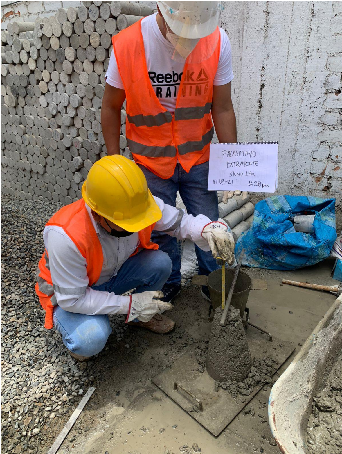
Figura 12. Slump después de 1 hora de preparado el concreto
