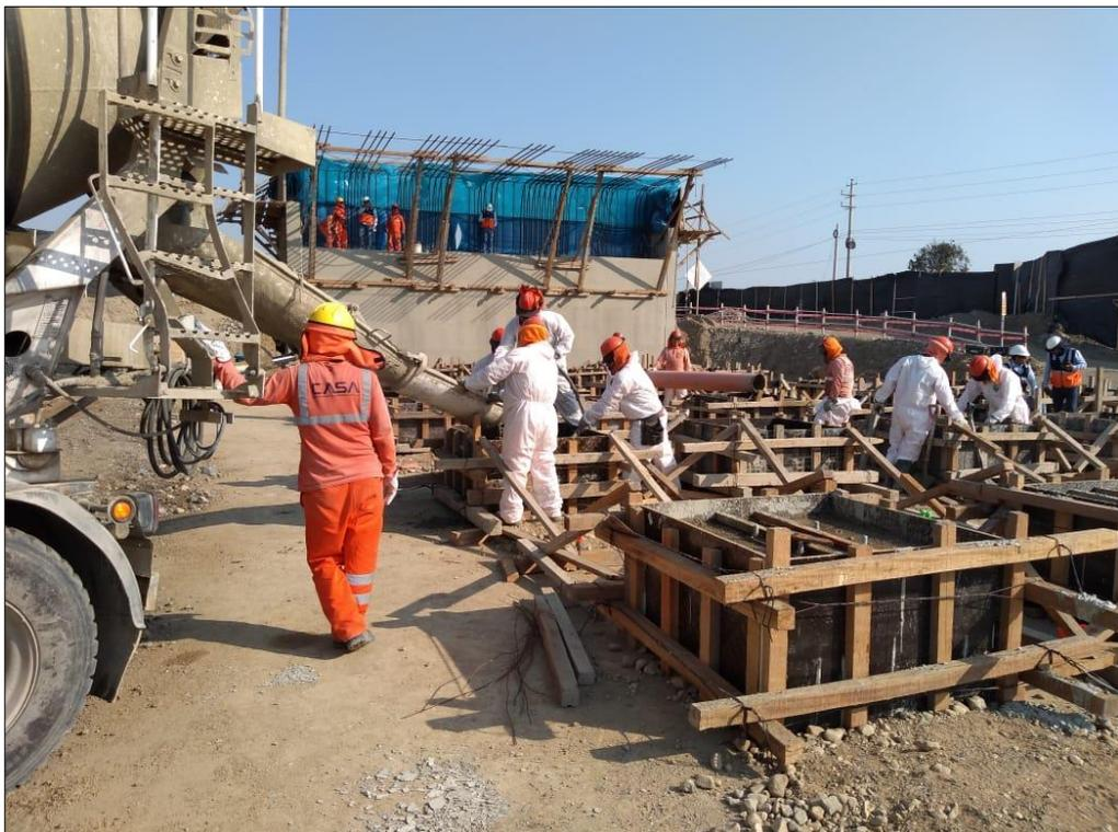
**FOTO N°04: VERTIDO DE CONCRETO EN DADOS PARA FALSO PUELTE.**
