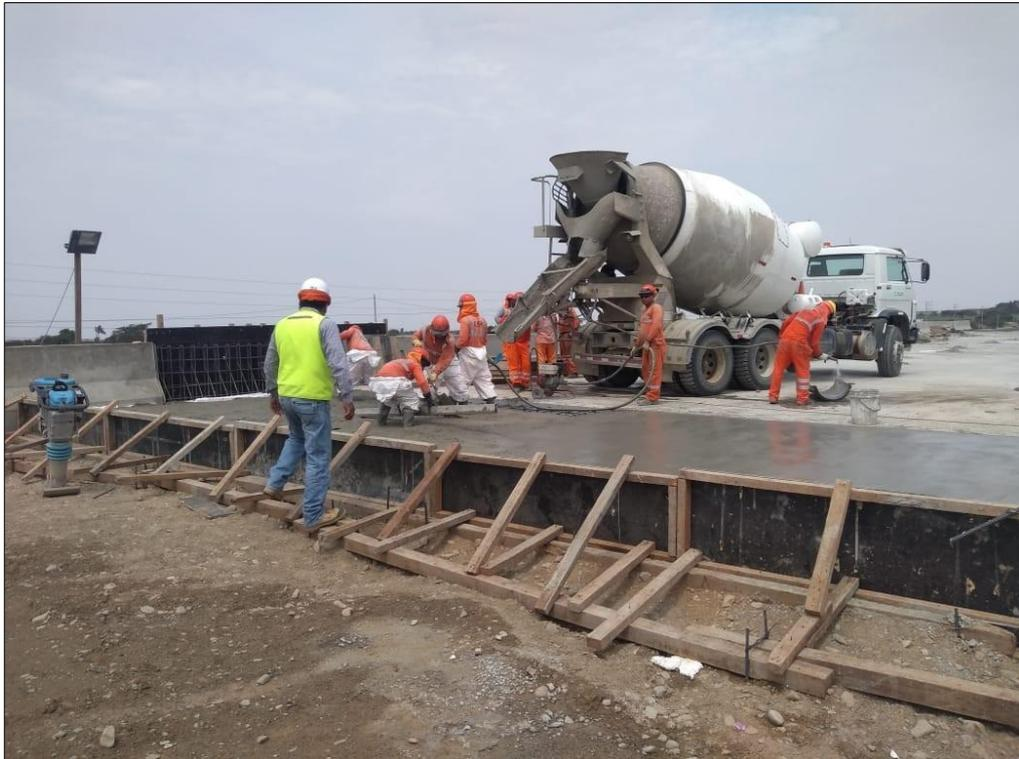
**FOTO N°07: VERTIDO DE CONCRETO EN LOSA DE APROXIMACIÓN.**
