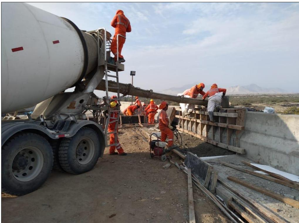
**FOTO N°08: VERTIDO DE CONCRETO EN MUROS NEW JERSEY.**
