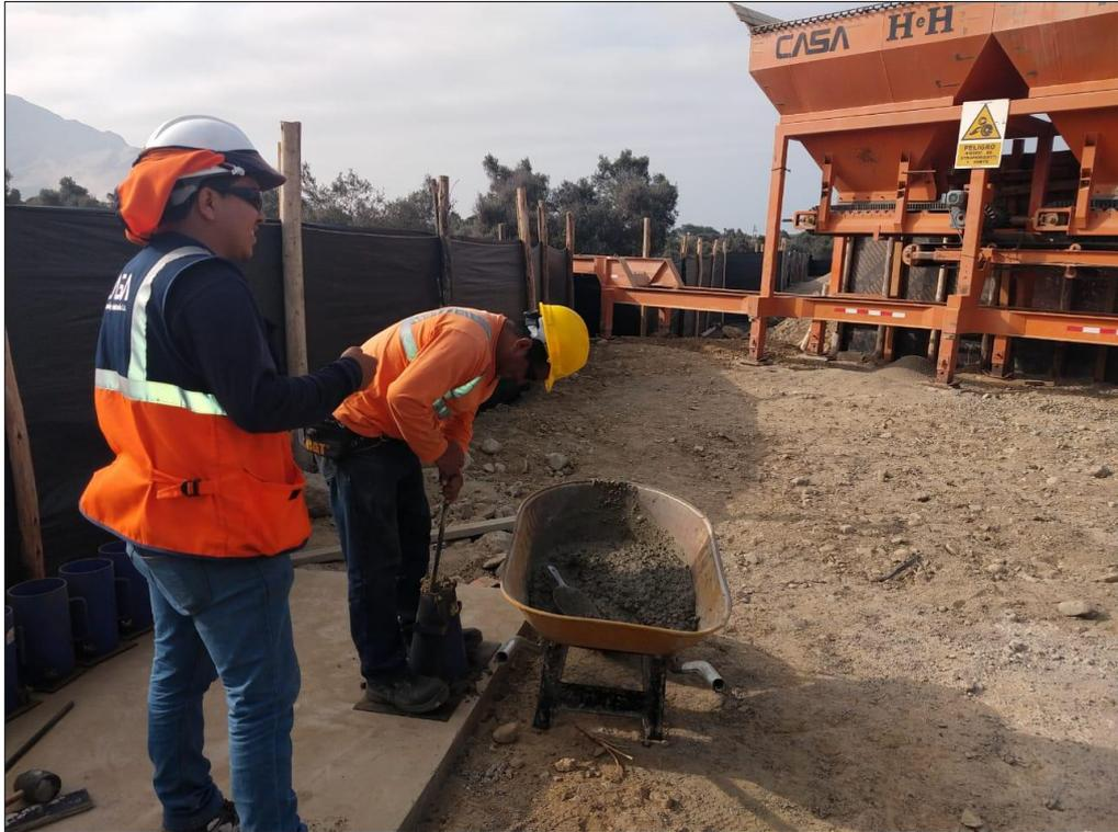
**FOTO N°09: PRUEBA DE SLUMP DEL CONCRETO.**
