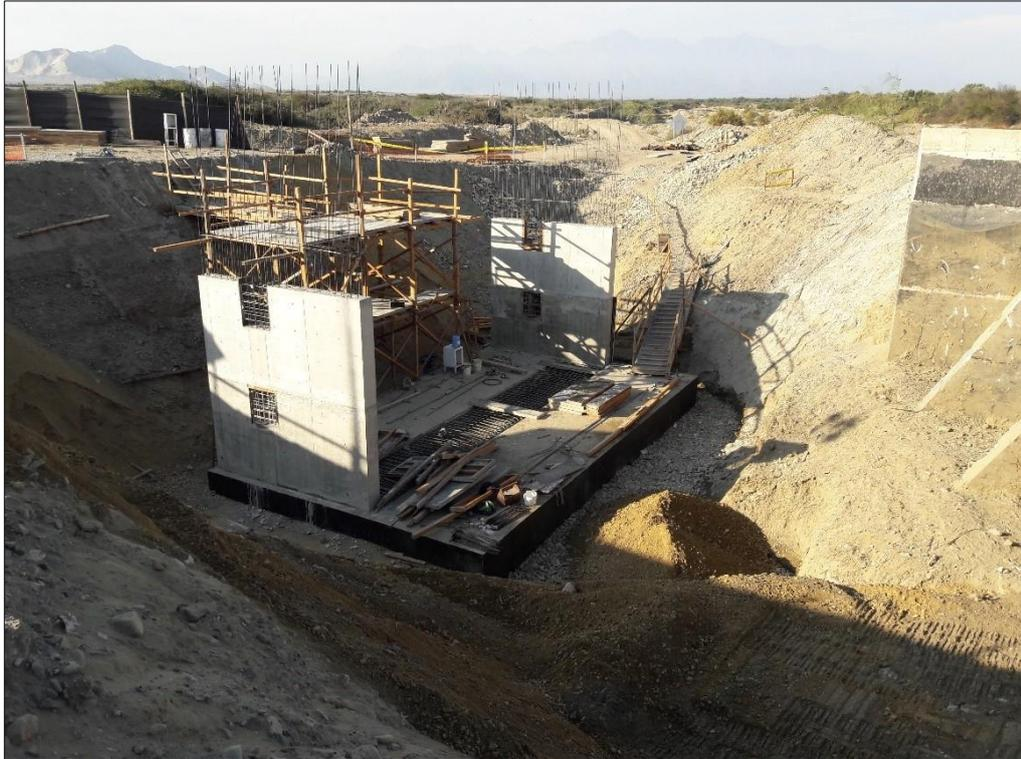
**FOTO N°03: DESENCOFRADO DE MUROS LATERALES – LADO SUR.**
