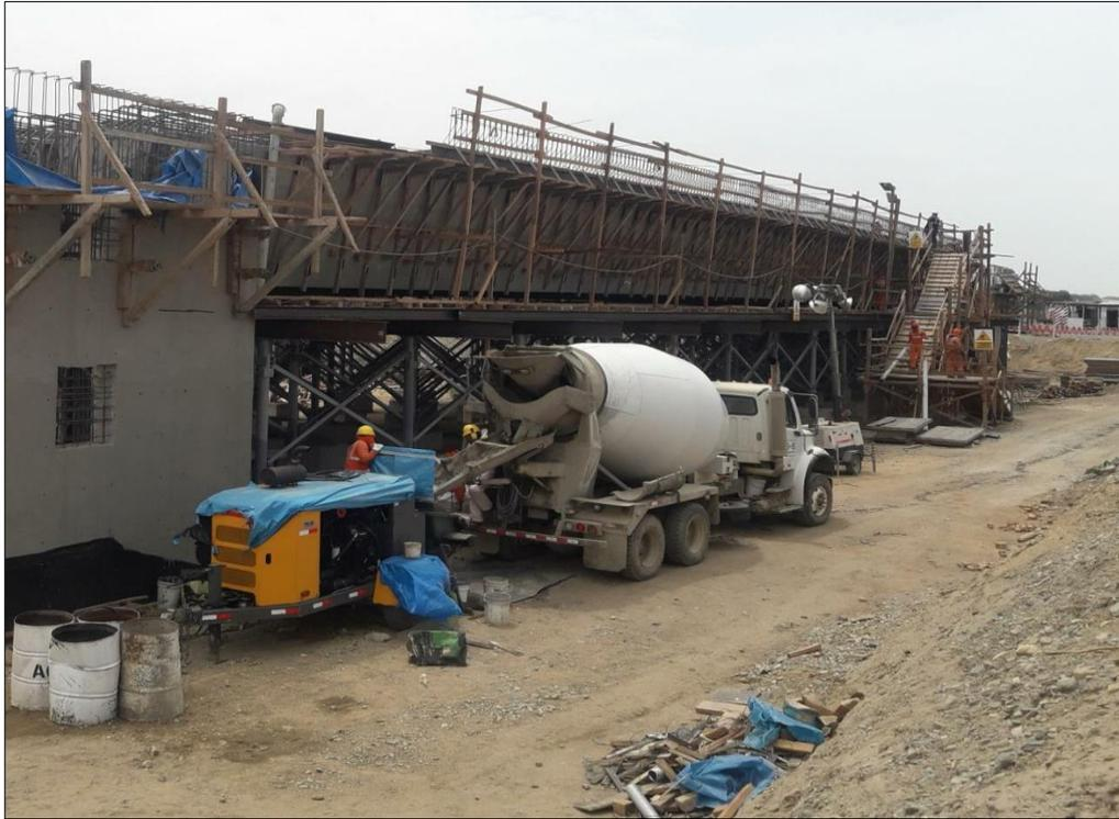
**FOTO N°05: VERTIDO DE CONCRETO EN VIGAS DE PUENTE.**
