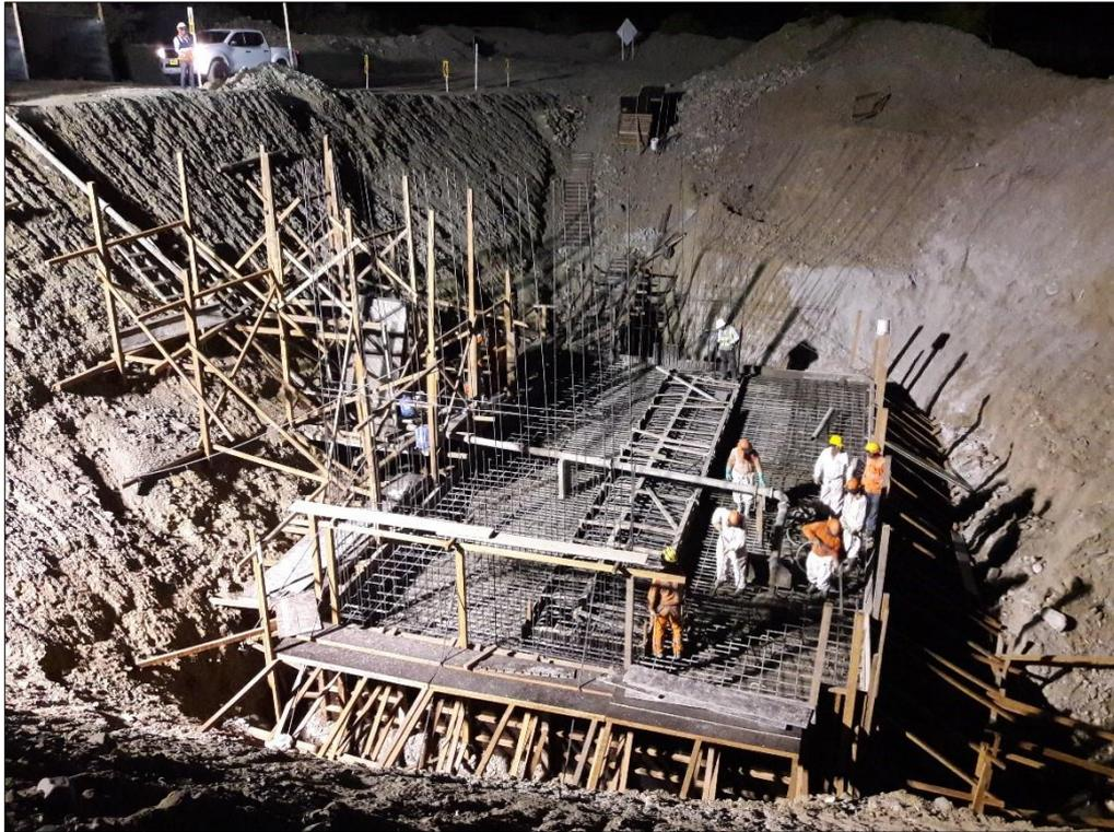
**FOTO N°01: VERTIDO DE CONCRETO EN ZAPATA – LADO NORTE.**
