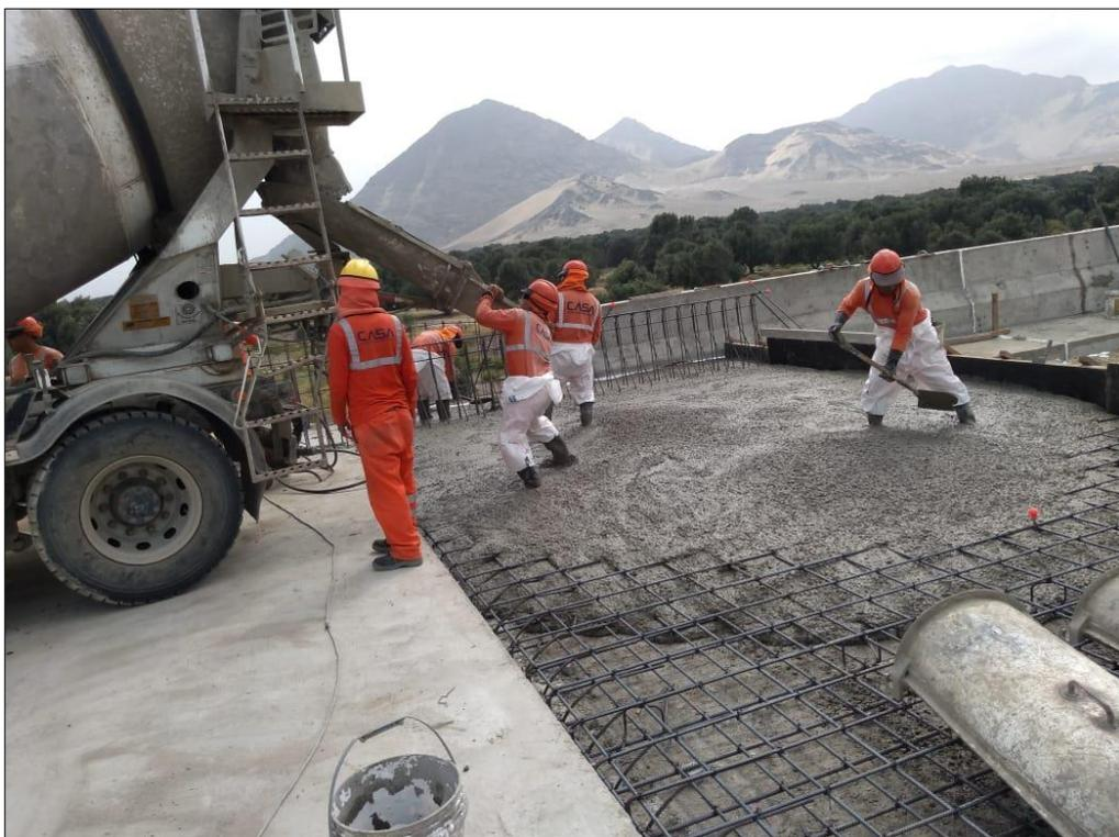
**FOTO N°06: VERTIDO DE CONCRETO EN LOSA DE PUENTE.**
