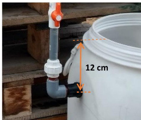
Figura 7. Instalación de accesorios entre el tanque de polietileno y el recipiente dosificador. Fuente: COSUDE, 2018. Tomado de la Memoria Descriptiva del hipoclorador de goteo de carga constante de doble recipiente.
