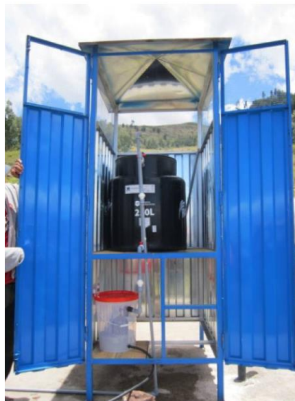
Figura 1. Hipoclorador de goteo de carga constante de doble recipiente.
