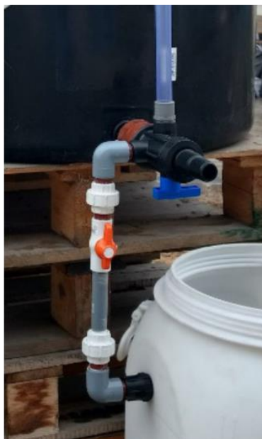
Figura 6. Instalación de accesorios entre el tanque de polietileno y el recipiente dosificador. Fuente: COSUDE, 2018. Tomado de la Memoria Descriptiva del hipoclorador de goteo de carga constante de doble recipiente.
