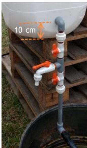
Figura 8. Perforación a 10 cm de la base del recipiente.
