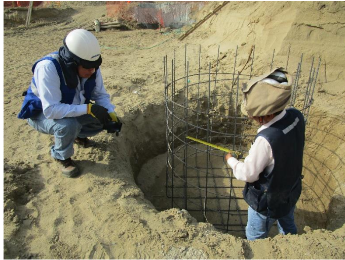
Figura 32: Armadura de buzones primer anillo
