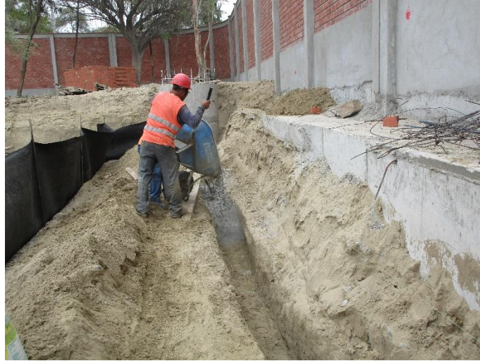
Figura 55: Colchón mínimo con piedra chancada de \frac{3}{4} " a 1"
