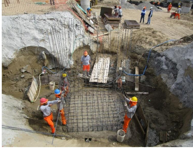
Figura 30: Vaciado de solado para cámara sumidero
