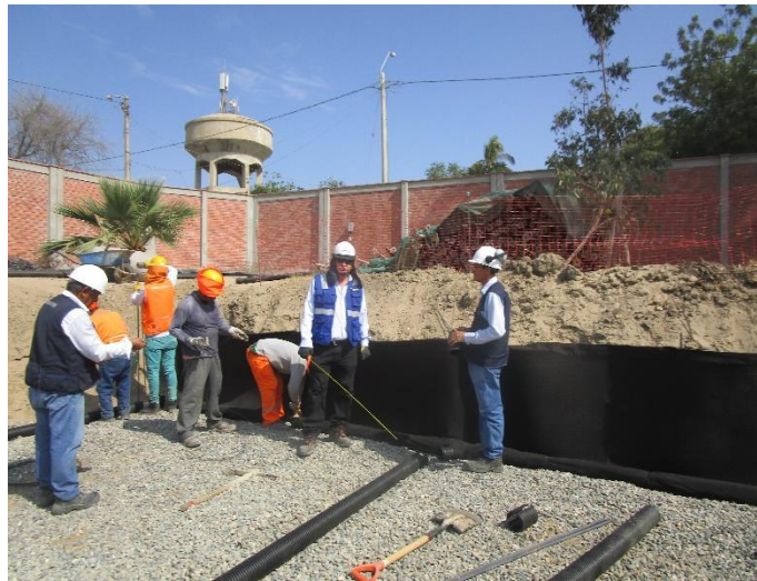
Figura 58: Instalación de Geodrén vial
