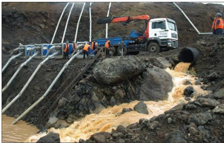
Figura 9: Sistemas de Drenaje Superficial.
