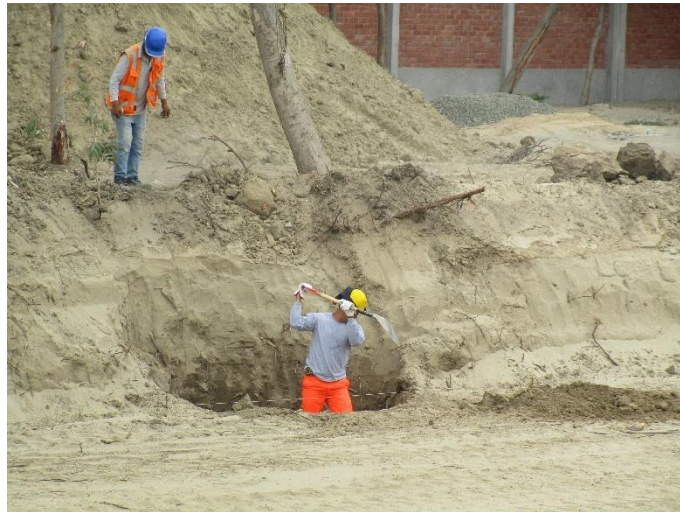
Figura 27: Excavación para buzón de concreto
