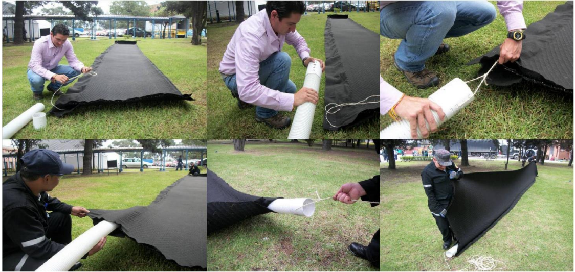
Figura 57: Ensamblaje de Geodrén vial
