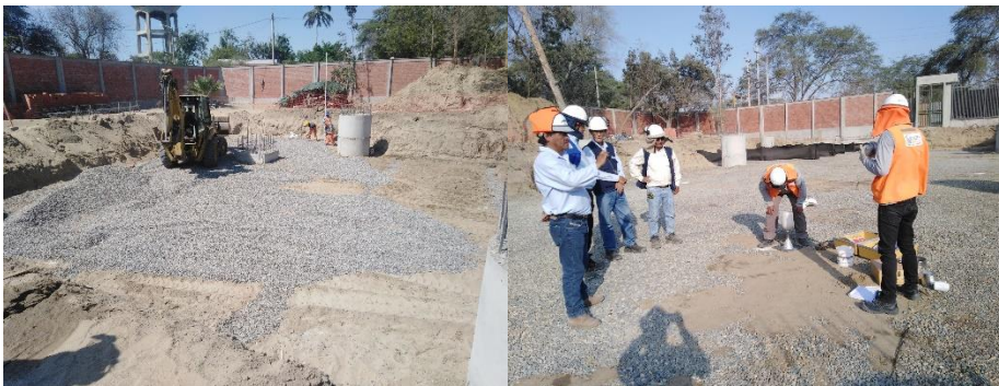
Figura 23: Estabilización de sub rasante
