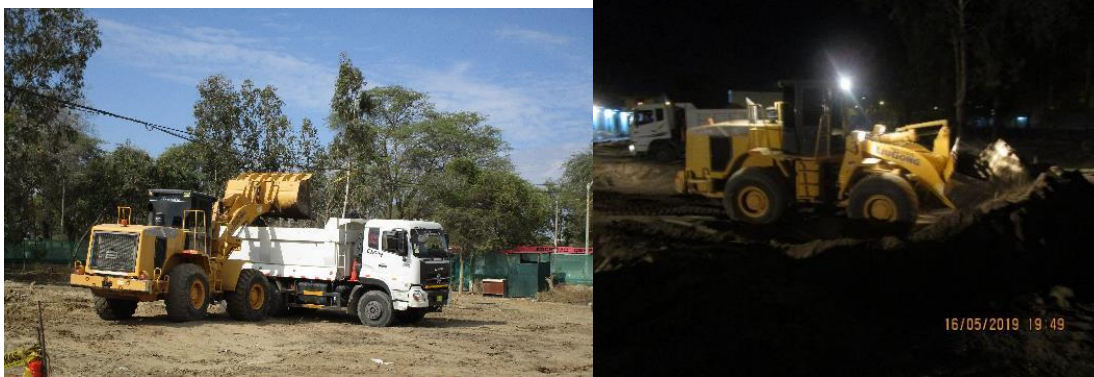
Figura 20: Control de corte masivo de terreno natural
