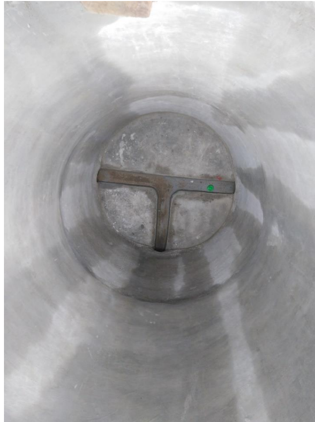
Figura 38: Acabado interior de buzones de concreto
