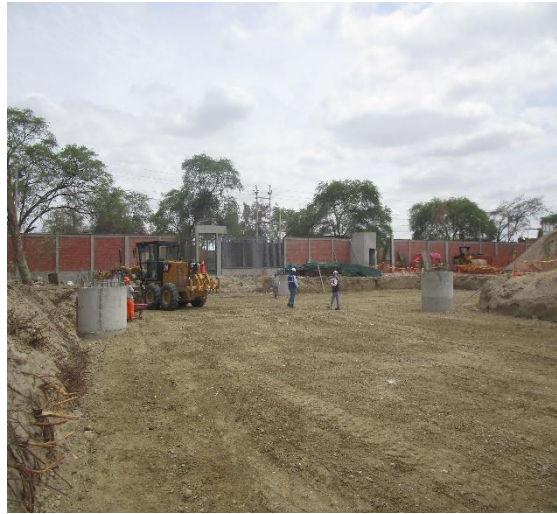
Figura 64: Esparcir el material de relleno de préstamo compactado al 95%
