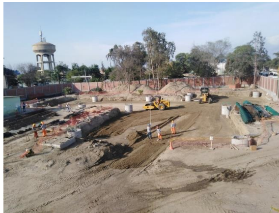
Figura 65: Inicio de nivelación y compactado de relleno con material de préstamo y control de nivel topográfico
