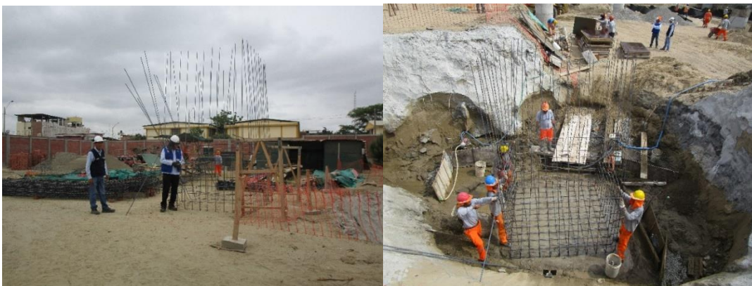
Figura 40: Habilitación y colocación de armadura en cámara sumidero
