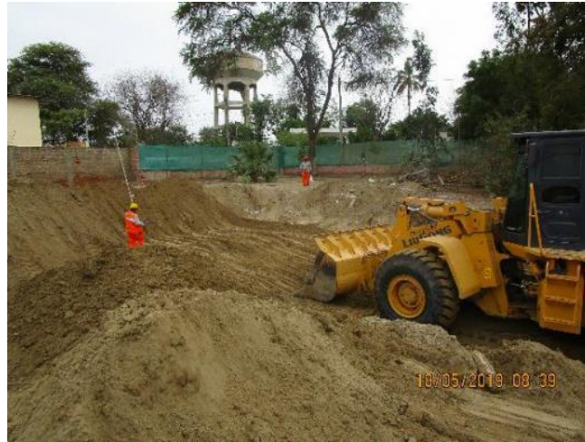
Figura 21: Control permanente de nivel de corte masivo
