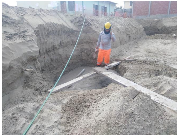
Figura 29: Vaciado de solado para buzones de concreto
