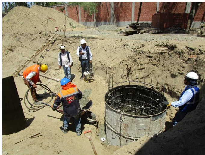
Figura 35: Vaciado de concreto en buzones primer anillo
