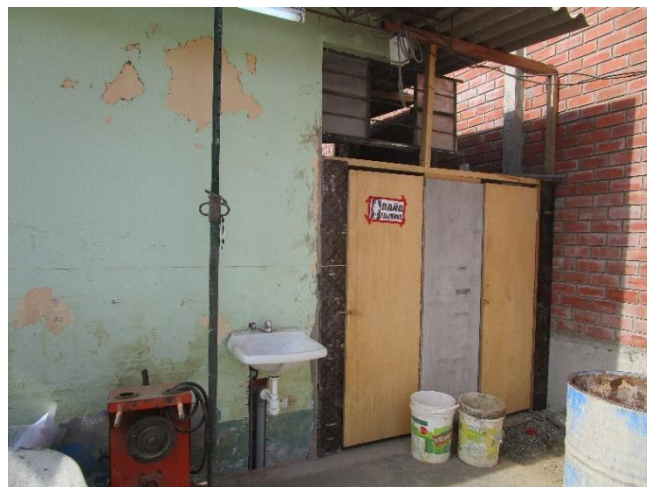
Figura 17: Implementación de obra provisional y preliminar
