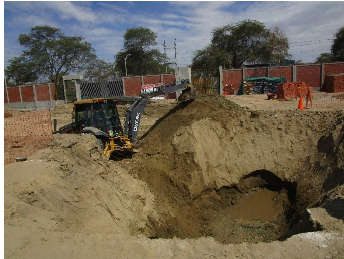
Figura 28: Excavación para cámara sumidero
