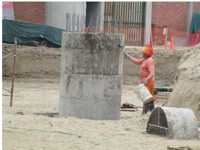
Figura 37: Curado de concreto con aditivo
