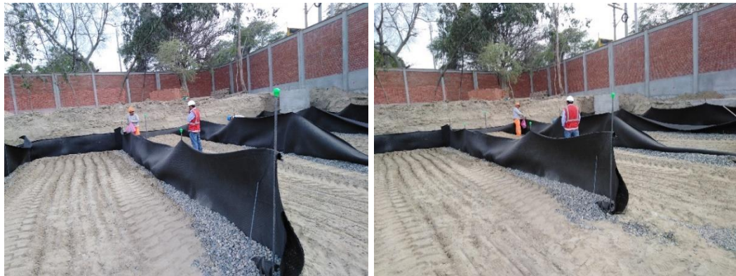
Figura 59: Relleno con zanja con piedra chancada de 3/4" a 1"
