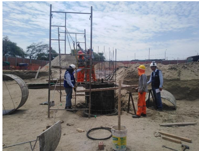
Figura 33: Armadura de buzones segundo anillo
