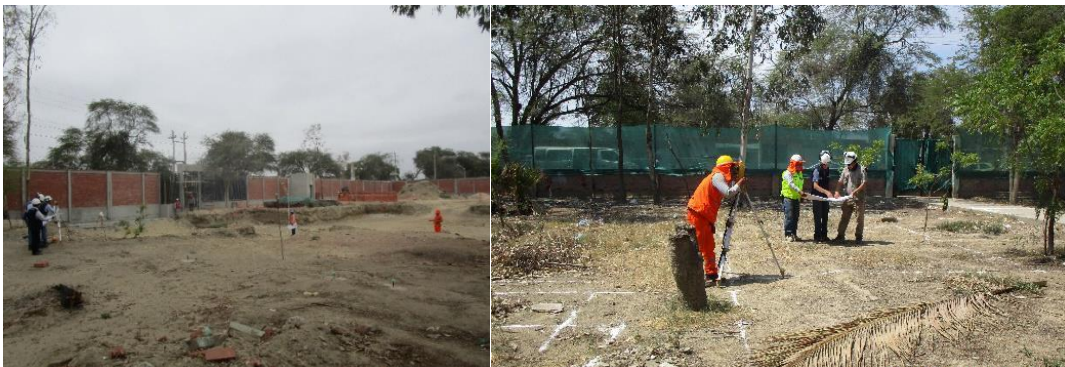
Figura 19: Control del trazo y replanteo de la red de agua durante la ejecución
