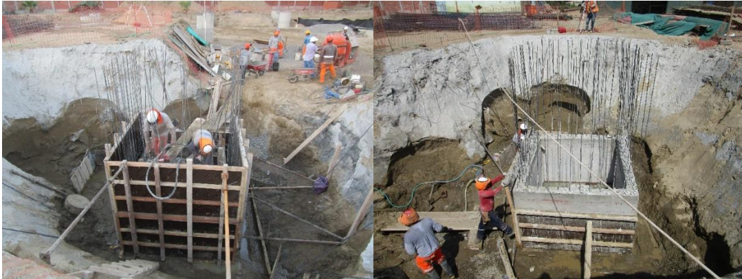
Figura 41: Encofrado, vaciado y desencofrado de cámara sumidero
