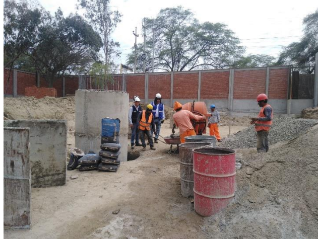
Figura 36: Desencofrado de buzones segundo anillo
