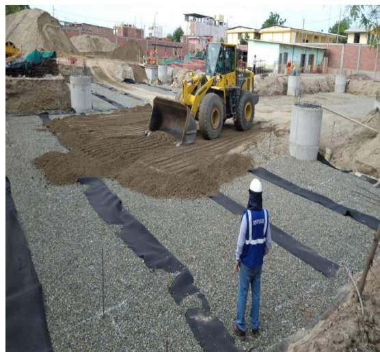
Figura 63: Inicio de relleno con material de préstamo compactado al 95%
