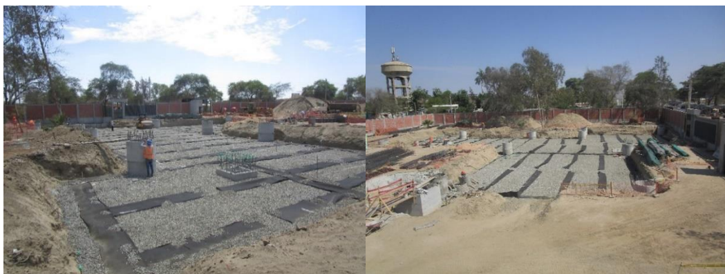
Figura 62: Vista panorámica del relleno con piedra chancada de \frac{1}{2} " a \frac{3}{4} "
