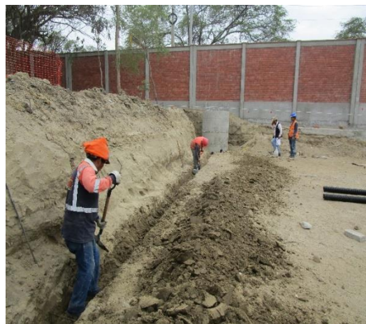
Figura 45: Excavación de redes colectoras
