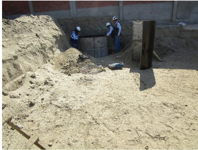
Figura 34: Encofrado de buzones primer anillo
