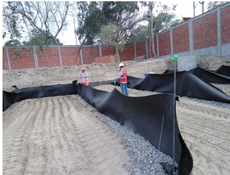
Figura 3: Sistema de drenaje.
