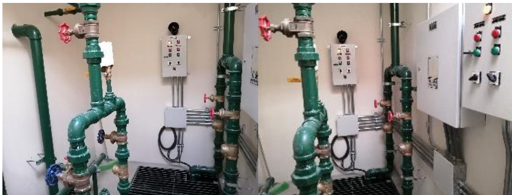
Figura 70: Instalación de electrobomba sumergible
