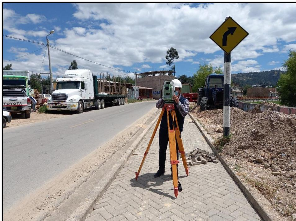
ANEXO n° 7. Toma de punto topográfico (límite de calzada – borde derecho).
