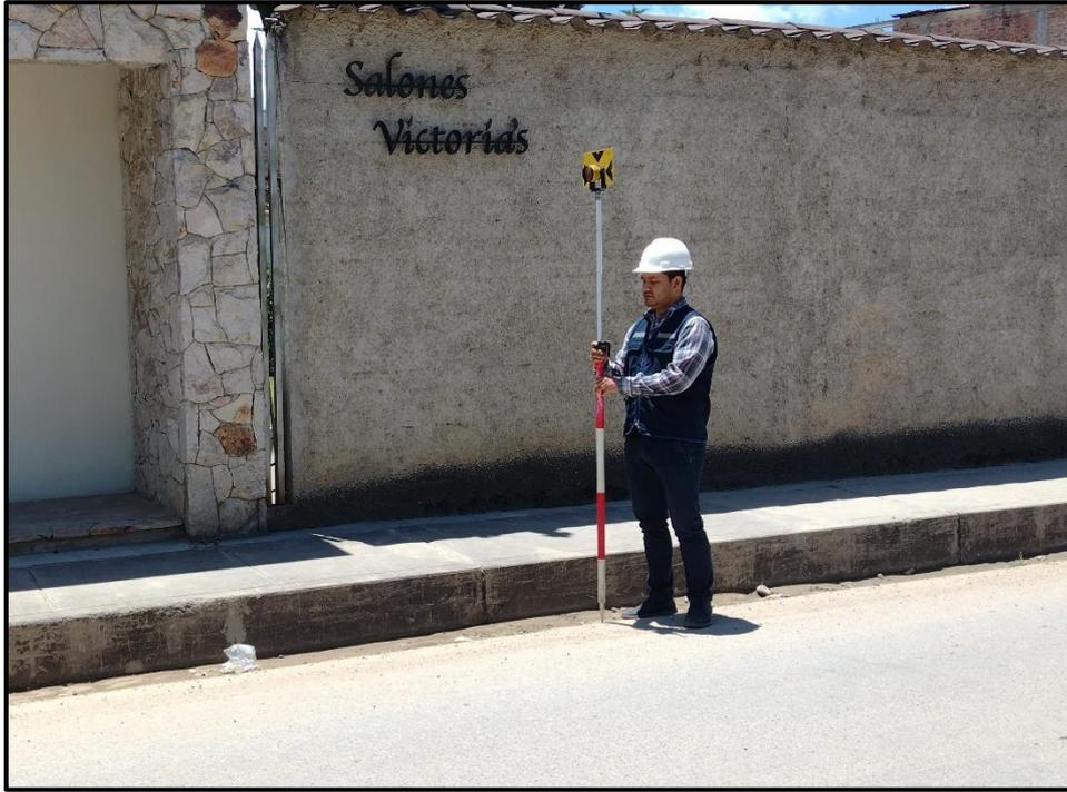
ANEXO n° 14. Toma de punto topográfico (límite de calzada – borde derecho).
