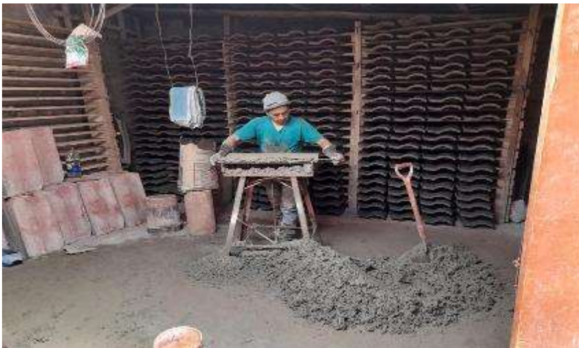
Moldeado de tejas de concreto
