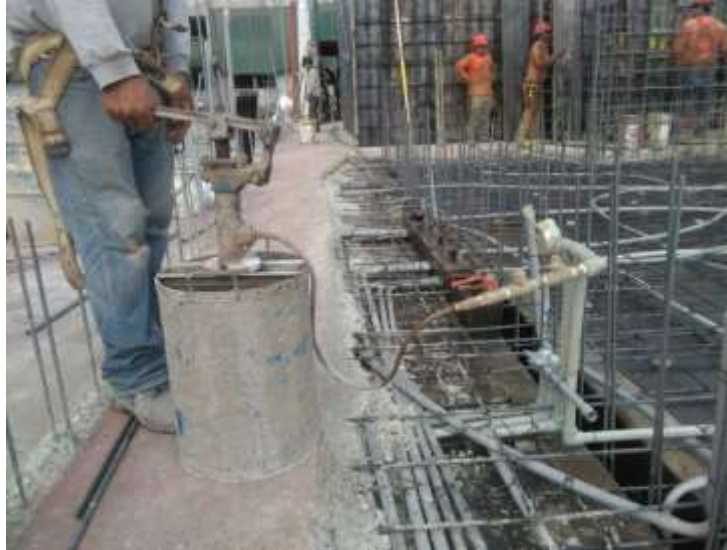
Figura 50: Prueba Hidráulica
