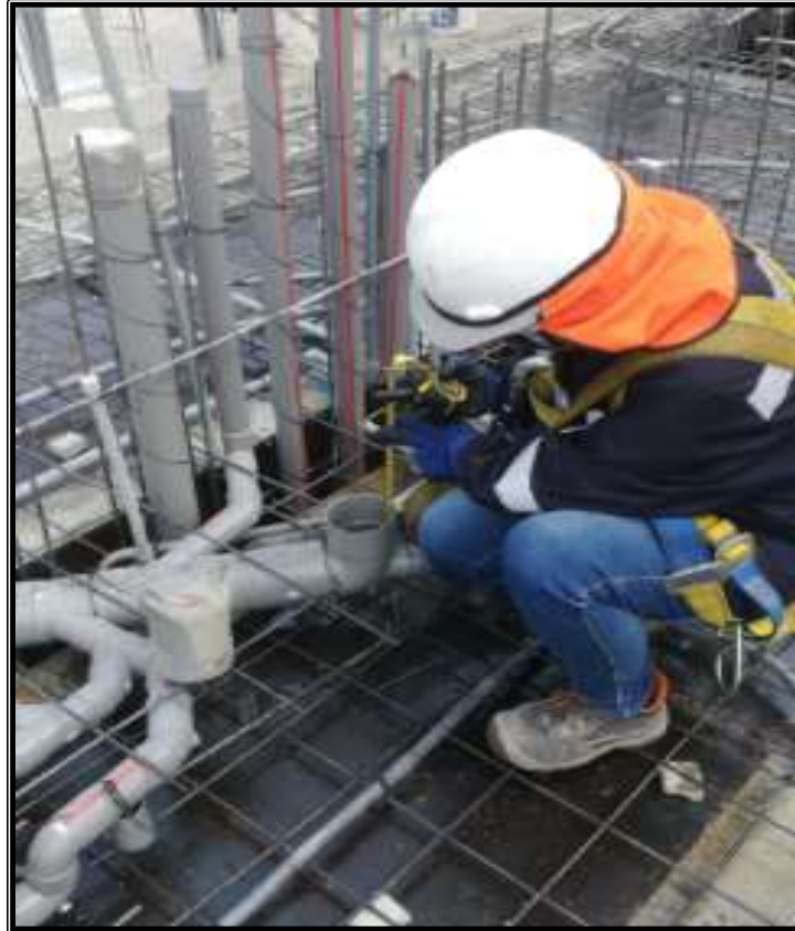
Figura 77. Toma de Muestra de Prueba de Estanqueidad. Tiempo: 24 hrs Variación: Max 1 cm.
