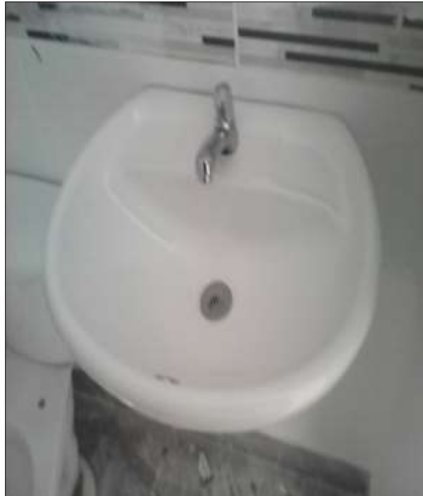
Figura 53: Colocación de Grifería.
