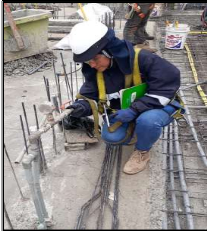
Figura 76 . Revisión, Presión, Tiempo, Variación Revisión: Prueba Hidráulica. Presión: 150 PSI Tiempo: 1h Variación: + - 5 PSI
