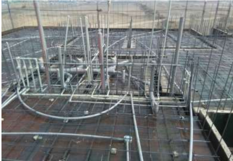
Figura 49: Colocación de Baterías.
