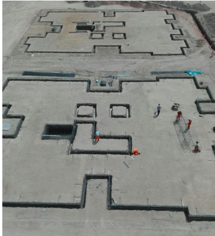
Figura 167. Trabajos de armado del acero para la losa de cimentación
