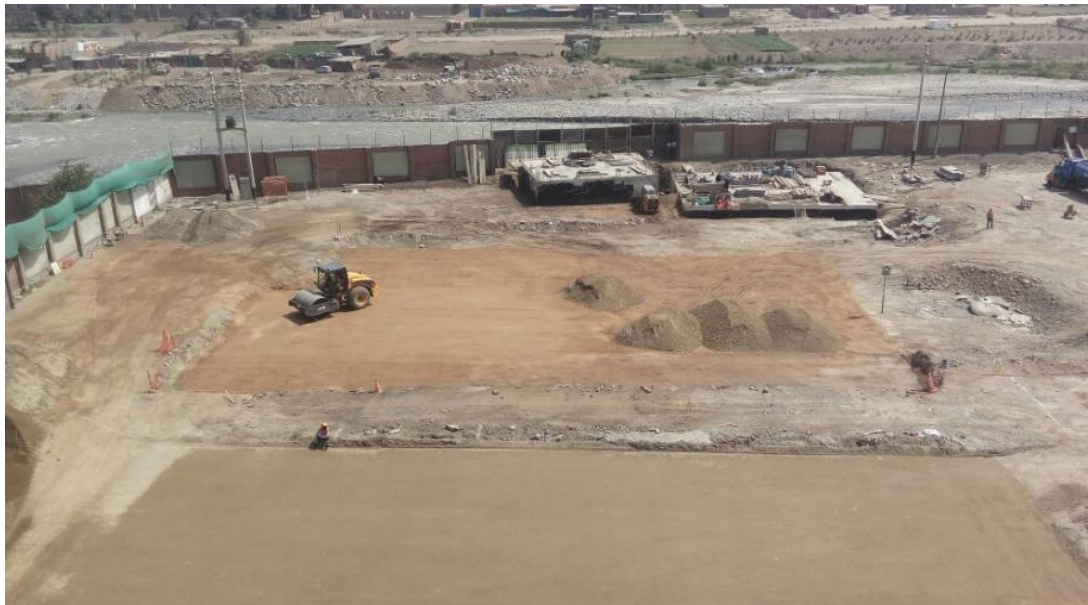
Figura 166. Trabajo de compactación para la losa de cimentación
