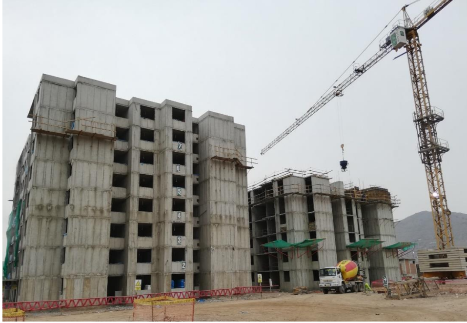
Figura 175. Avance del casco de la torre 9 Fin de casco, Torre 8 Piso 6
