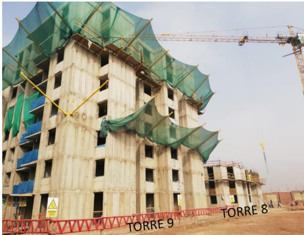
Figura 174. Avance del casco de la torre 9 – Piso 8 , Torre 8 Piso 3
