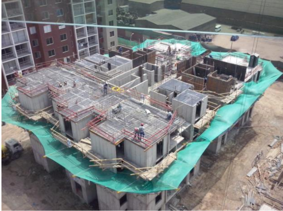
Figura 171. Avances de los trabajos de la torre 8
