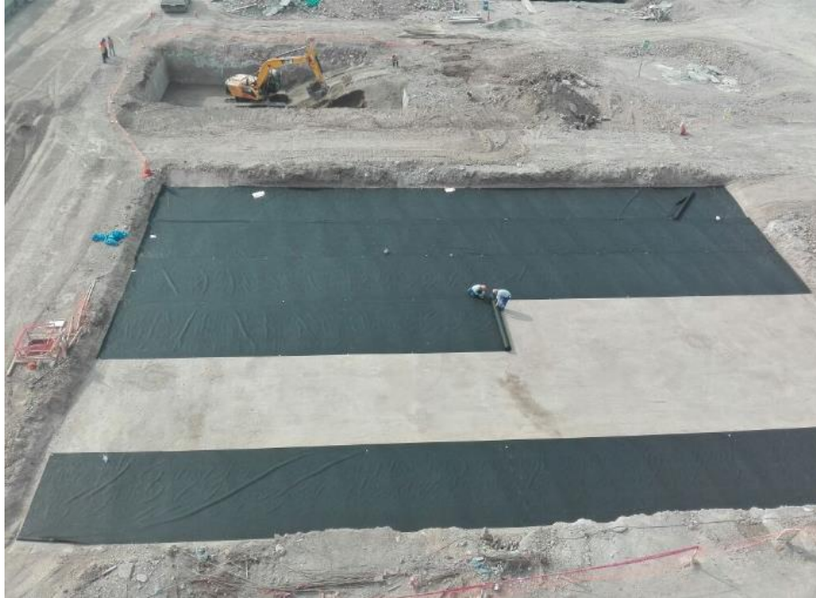
Figura 165. Subcimentado para la losa de cimentación armada
