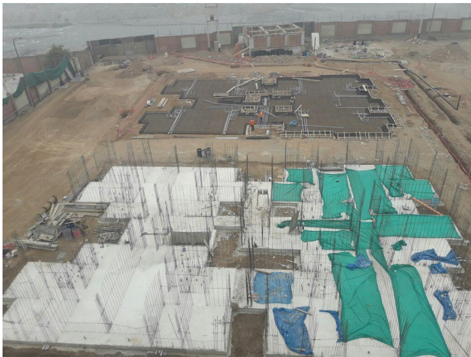
Figura 168. Vaciado de losas de cimentación de la torre 9
