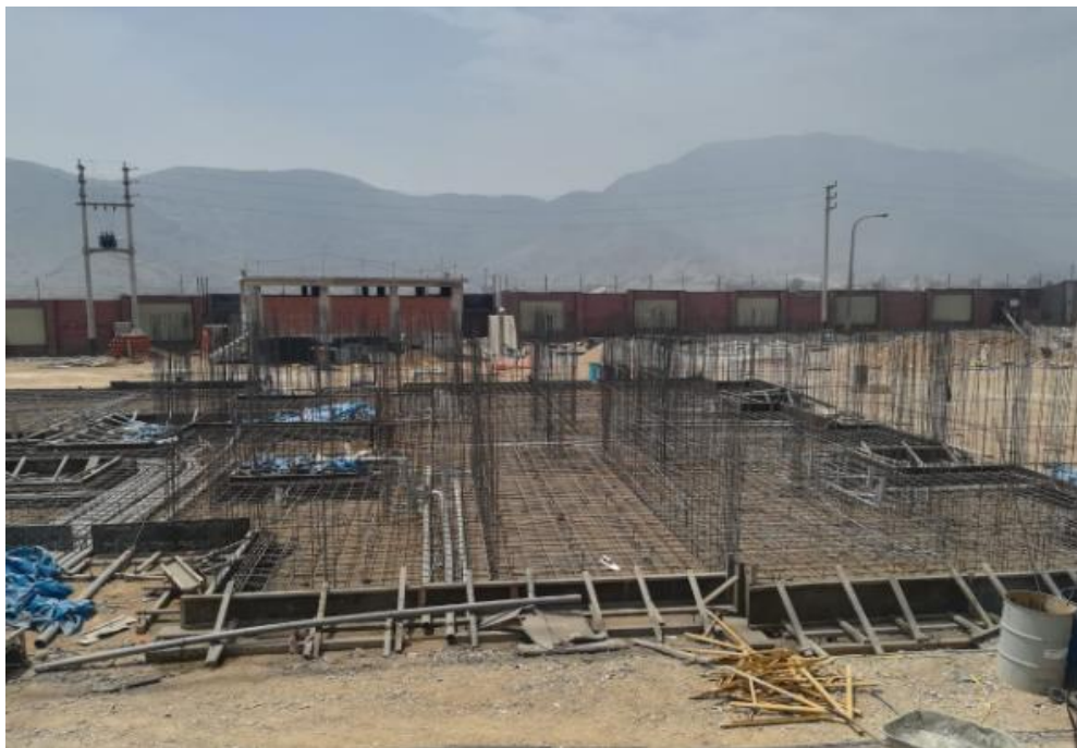
Figura 170. Trabajos de acero en la losa de cimentación – Torre 9
