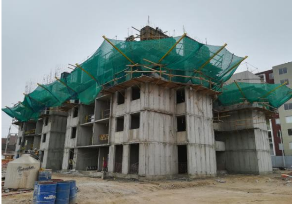
Figura 173. Avance de los trabajos del casco piso 5 – torre 8
