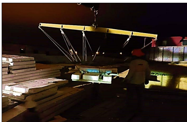
Figura 63. Enganche de prelosa de menor dimensión. Fuente: Elaboración propia.
