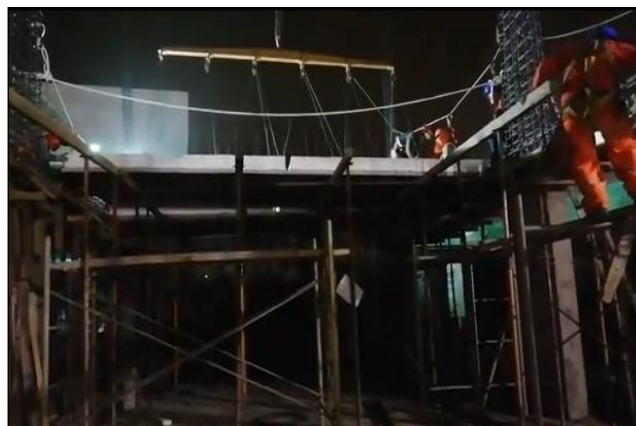
Figura 60. Desenganche de prelosa. Fuente: Elaboración propia.
