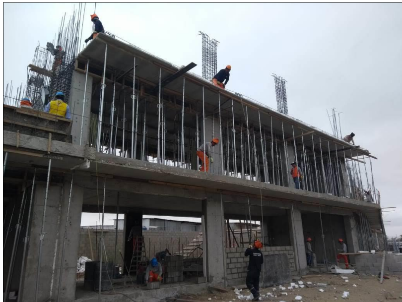
Figura 89. Encofrado de prelosa. Fuente: Elaboración propia.
