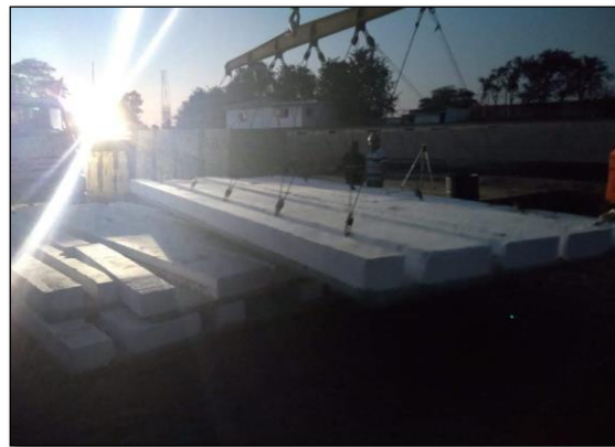
Figura 57. Enganche de prelosa. Fuente: Elaboración propia.
