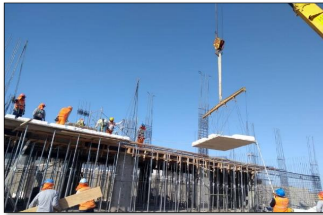
Figura 58. Transporte de prelosa. Fuente: Elaboración propia.
