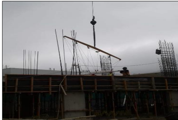
Figura 59. Colocación de prelosa. Fuente: Elaboración propia.
