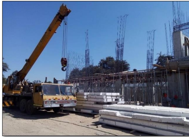
Figura 61. Retorno de pluma de grúa. Fuente: Elaboración propia.
