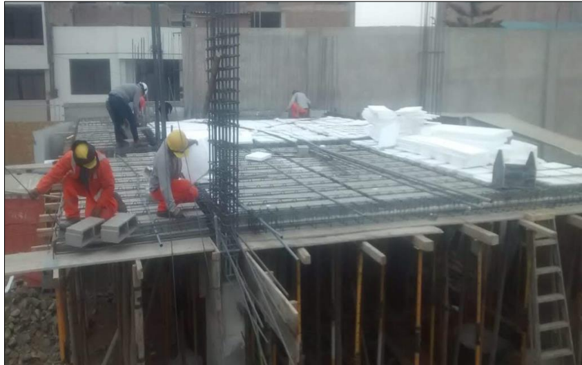
Figura 88. Encofrado tradicional de techo. Fuente: Elaboración propia.
