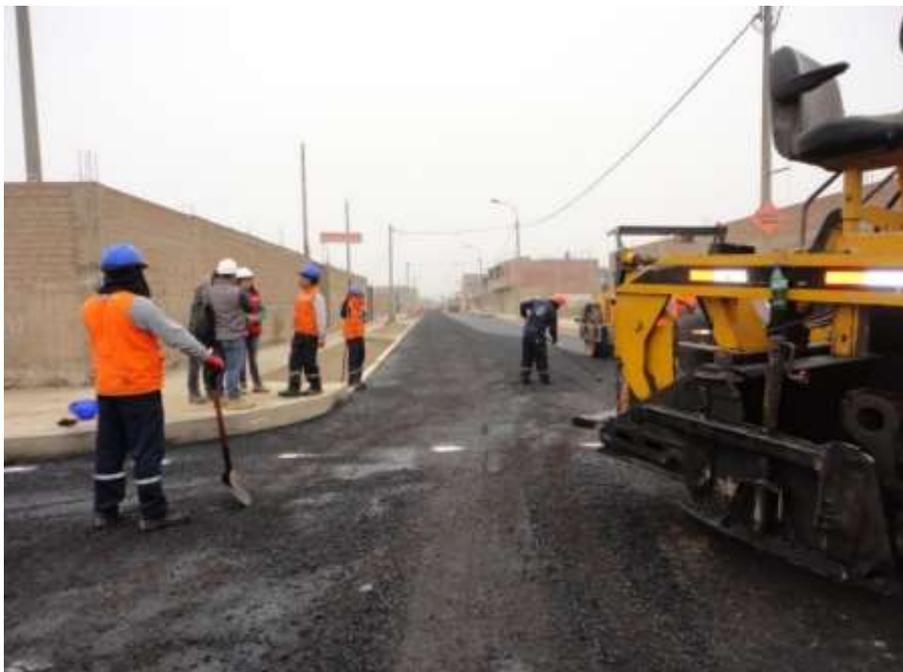
*Figura 36 Se verificó la colocación y compactación de la mezcla asfáltica en caliente con rodillo liso y rodillo neumático (CALLE 06).*
