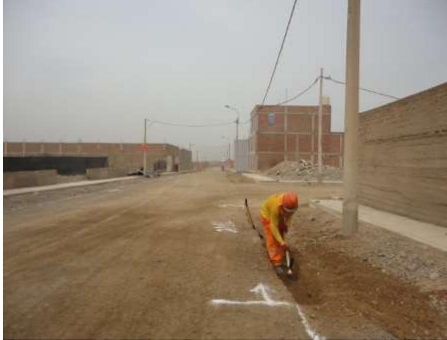
*Figura 11 Se verifica la excavación del sardinel sumergido 175 kg/cm<sup>2</sup> en la calle 02.*
