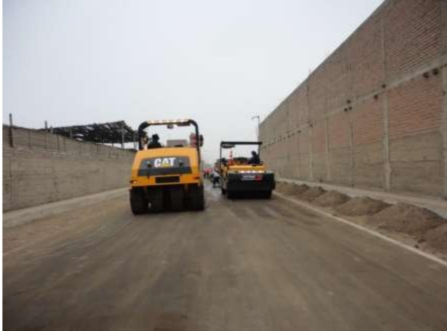
*Figura 35 Se verificó la colocación y compactación de la mezcla asfáltica en caliente con rodillo liso y rodillo neumático (CALLE 03).*
