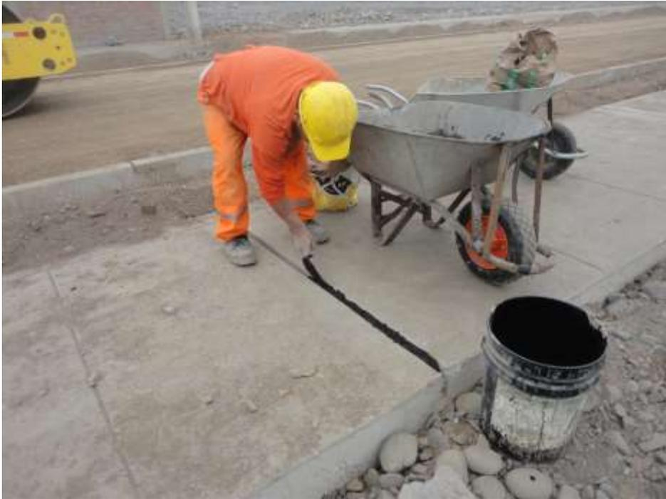
*Figura 29 Se verifico la instalación de la junta de dilatación asfalto-arena en la calle 06.*
