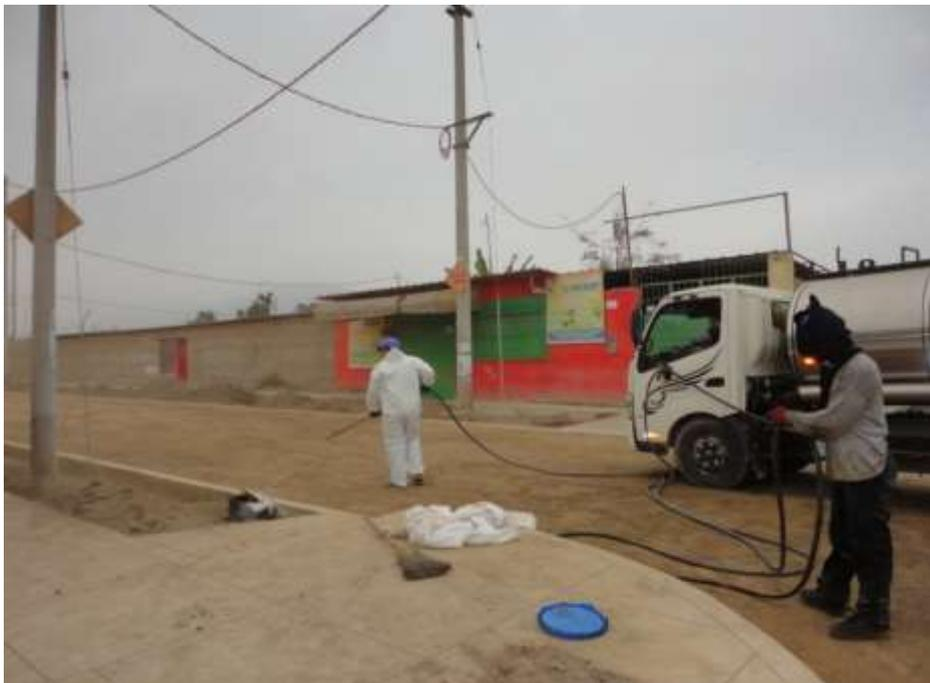
*Figura 30 Se verificó la limpieza de la base de pista con compresora previo a la imprimación asfáltica.*
