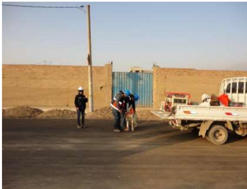
*Figura 38 Se verificó la extracción de diamantinas (CALLE 05 Y 06).*
