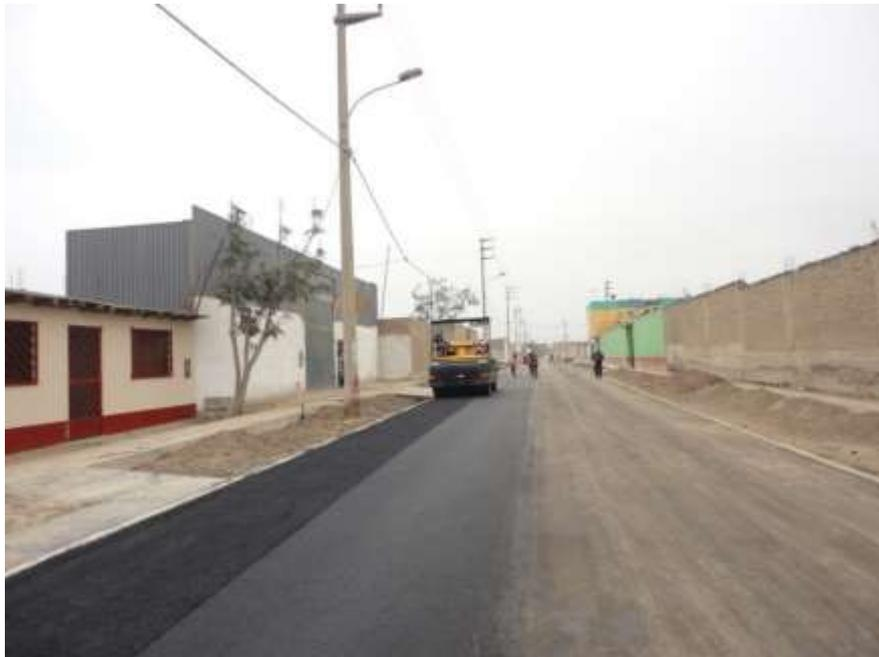
*Figura 34 Se verificó la compactación de la mezcla asfáltica con rodillo liso en la calle5.*
