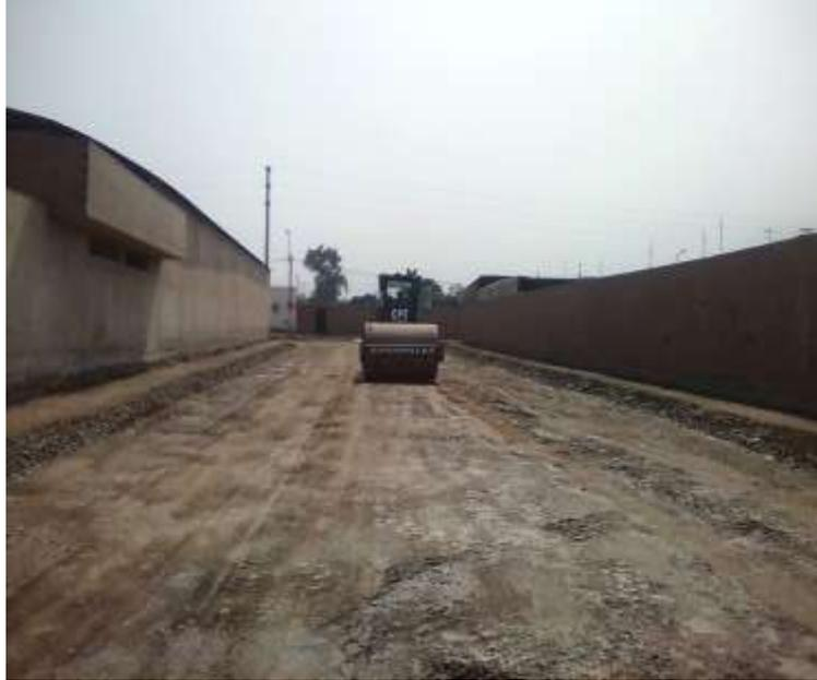
*Figura 21 Se verificó la conformación y compactación con rodillo liso de base en pista.*
