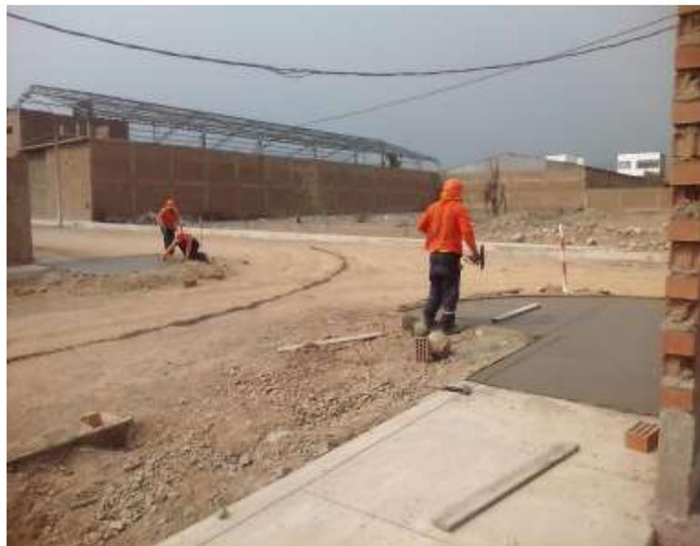
*Figura 18 Se verificó el vaceado de los martillos de 175kg/cm<sup>2</sup>.*
