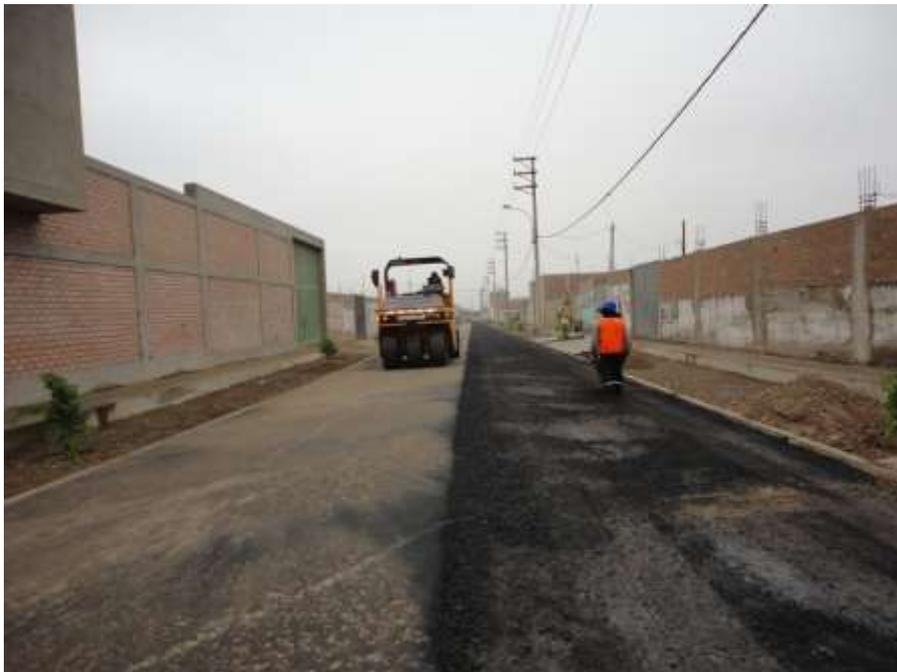
*Figura 40 Se verificó la colocación y compactación de la mezcla asfáltica en caliente con rodillo liso y rodillo neumático (CALLE 08).*
