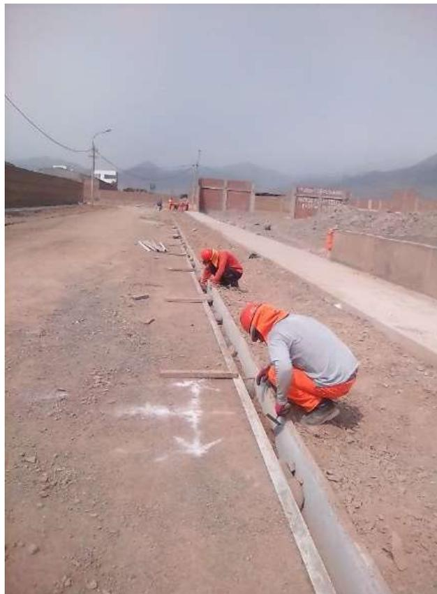
*Figura 16 Se verifico el encofrado para sardineles sumergidos de 175kg/cm<sup>2</sup>*
