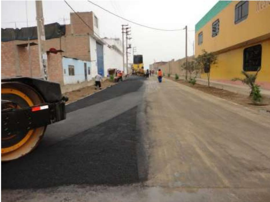
*Figura 41 Se verificó la colocación y compactación de la mezcla asfáltica en caliente con rodillo liso y rodillo neumático (CALLE 08).*
