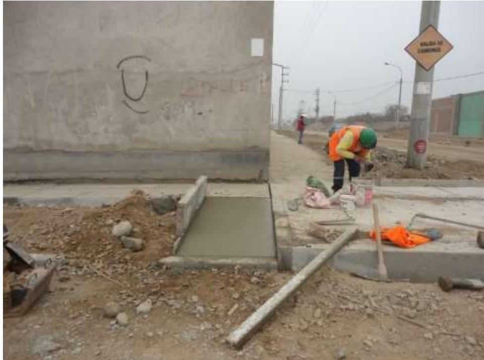
*Figura 19 Se verifico el vaceado de rampas de 175 kg/cm2.*
