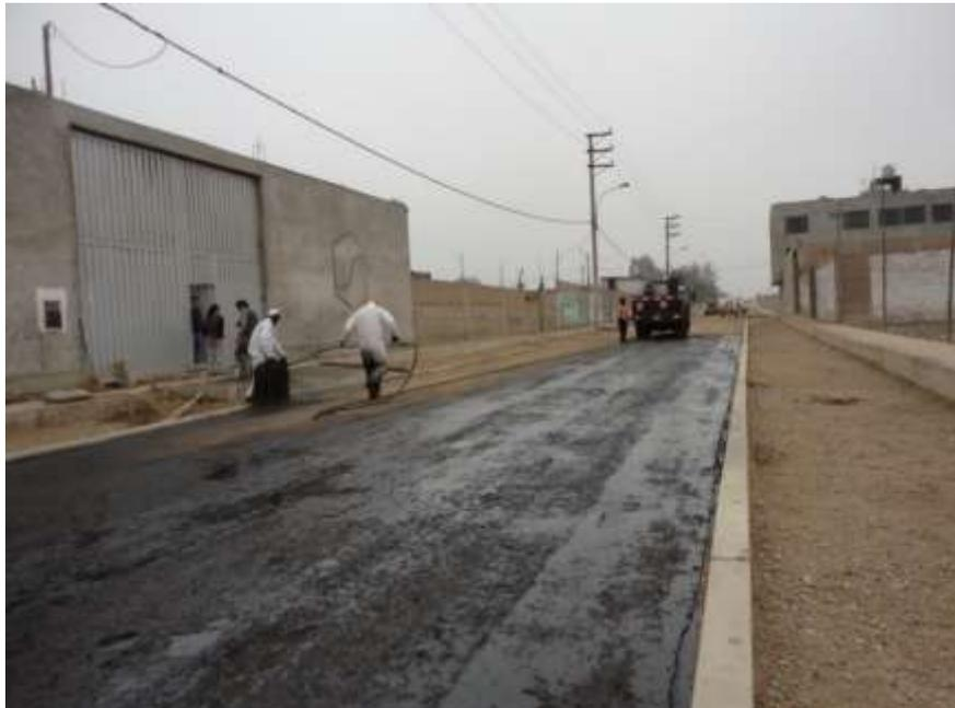
*Figura 32 Se verificó la imprimación asfáltica (Asfalto Cut-back MC-30).*
