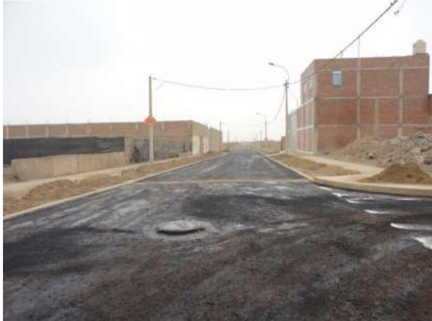
*Figura 31 Se verificó la imprimación asfáltica (Asfalto Cut-back MC-30)..*
