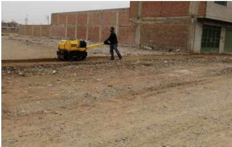
*Figura 12 Se verifica la compactación mediante el uso de rodillo tipo combi.*
