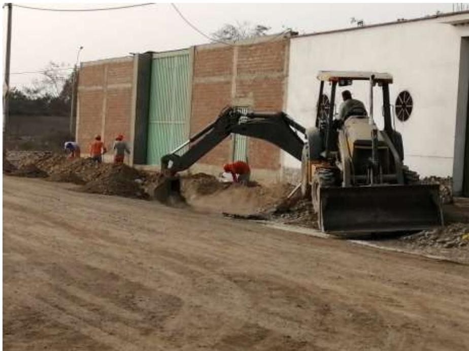
*Figura 14 Se verifica la eliminación de material excedente con maquinaria pesada.*
