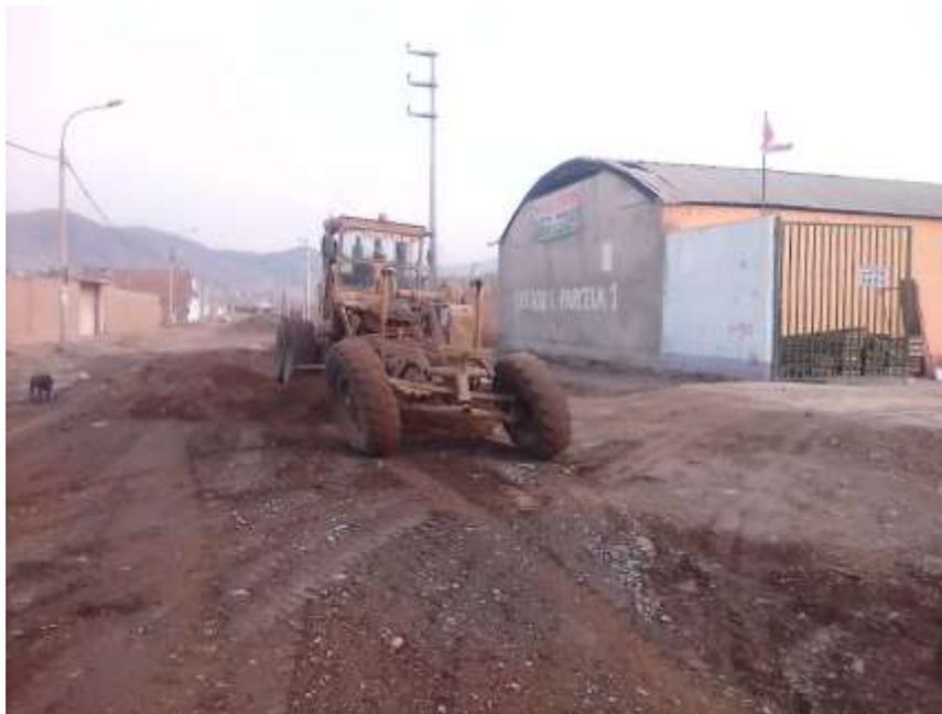
*Figura 20 Se verificó la conformación de base en pista con motoniveladora.*
