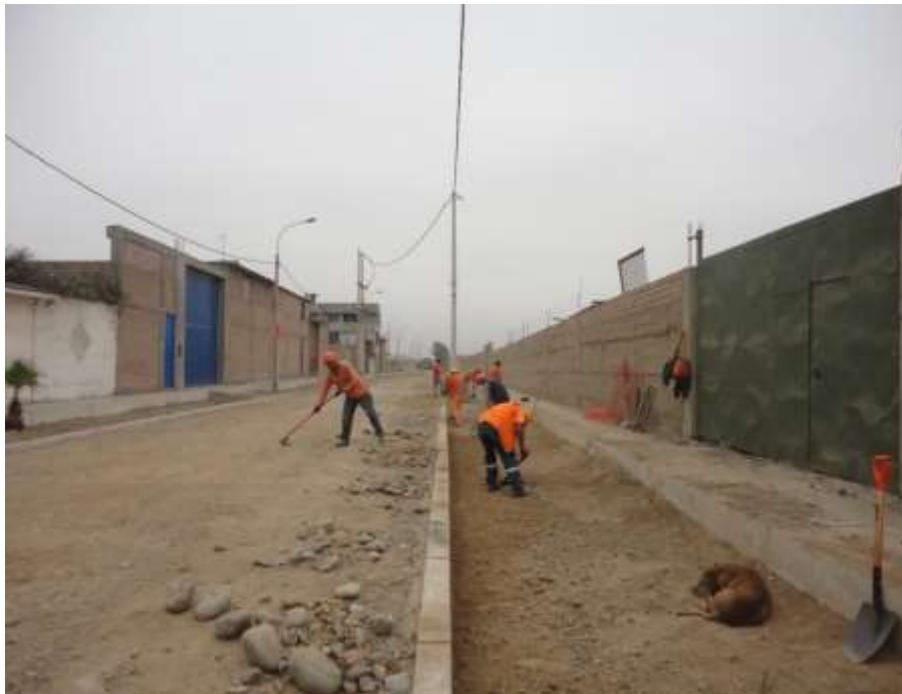
*Figura 26 Se verificó la excavación manual para áreas verdes y limpieza.*
