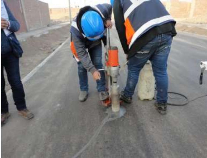
*Figura 39 Se verificó la extracción de diamantinas (CALLE 05 Y 06).*
