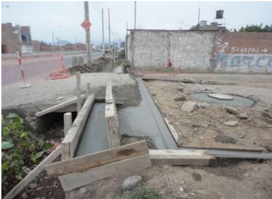
Figura 27 Se verifica el reforzamiento con estructura de concreto para protección con el encuentro del canal de riego existente en la calle 05.
