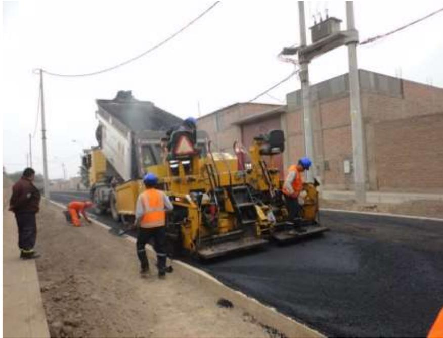
*Figura 37 Se verificó la colocación y compactación de la mezcla asfáltica en caliente con rodillo liso y rodillo neumático (CALLE 04 Y 07).*
