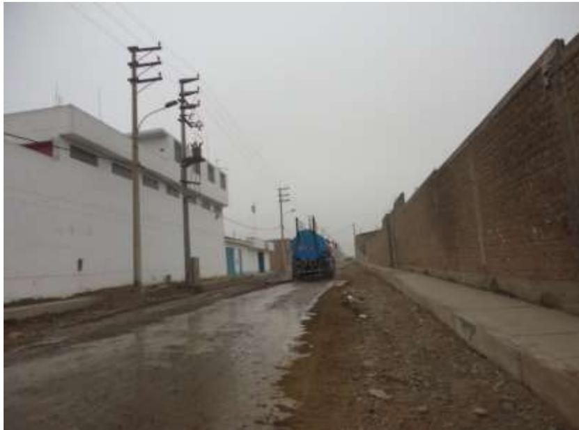
*Figura 24 Se verifica el riego de base granular colocada en vía.*
