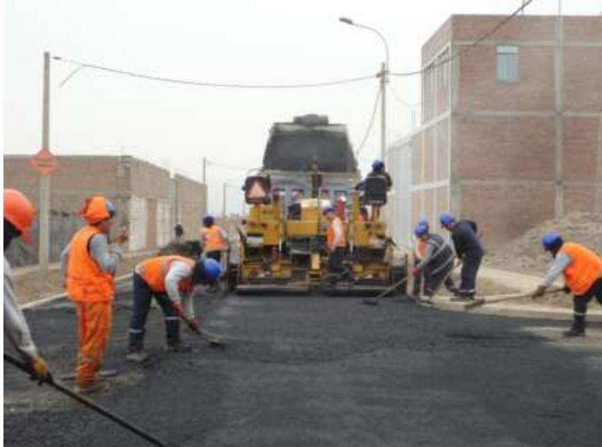
*Figura 33 Se verificó la colocación de la mezcla asfáltica en caliente con pavimentadora en la calle 06.*
