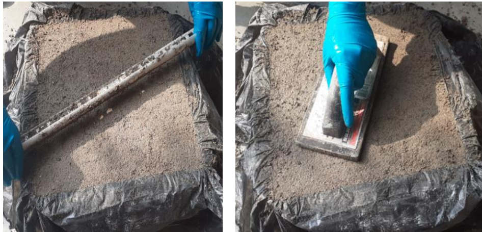
Figura 245. Nivelado y alisado de bloque. Fuente: Elaboración propia.
