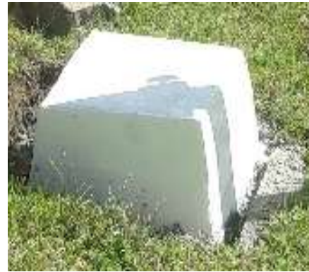
Figura 18: Monumentación para puntos geodésicos
