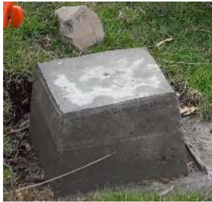
Figura 18: Monumentación para puntos geodésicos
