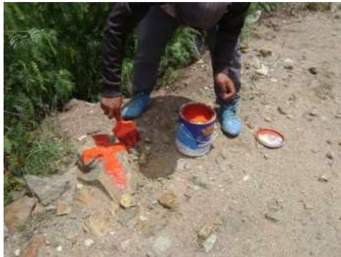
Figura 39: Pintado de puntos foto control
