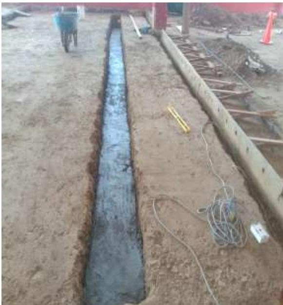
*Figura 63: Vaciado de solado, en el canal de evacuación de agua.*
