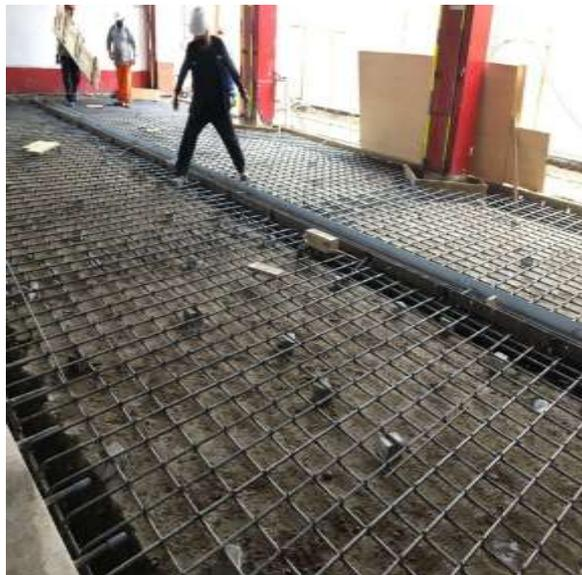
*Figura 60:* Colocación de dados de concreto para evitar el contacto del acero con el
