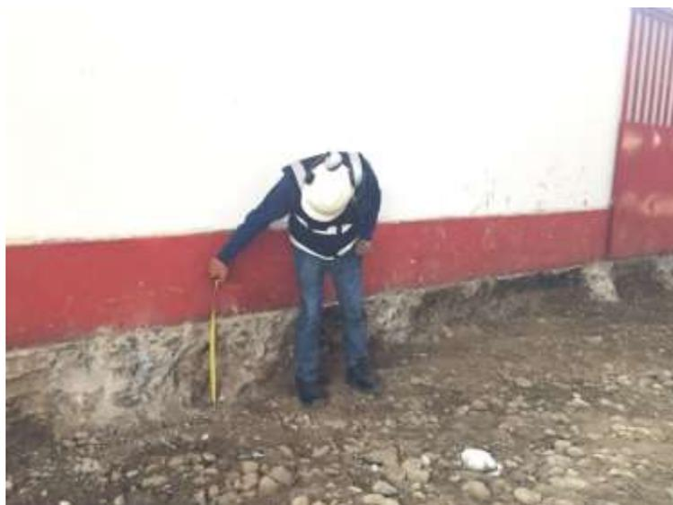
*Figura 46:* Medidas en distintos puntos del área a intervenir, a fin de verificar la profundidad de excavación y cumpla de acuerdo a los planos.
