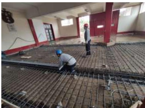
*Figura 56:* Refuerzo con acero Ø ½ @ 0.15m en ambos sentidos.
