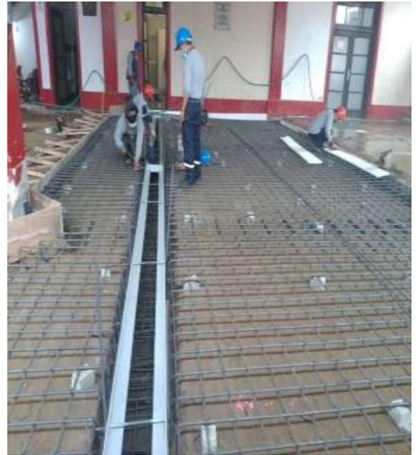
*Figura 59:* Instalación de marco de acero L 3"x3"x5/16"
