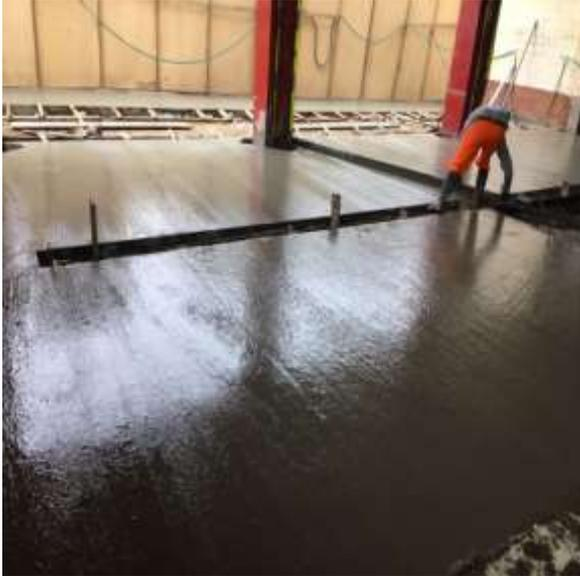
*Figura 69:* Vaciado de concreto  $f'c$  280 kg/cm<sup>2</sup> y pulido del tercer y cuarto paño.
