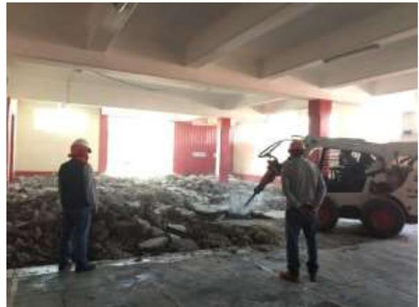
*Figura 42: Demolición de piso, Área "B"*
