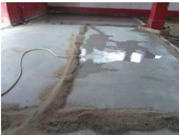
*Figura 73:* Se realizó el curado del concreto por siete días, mediante arroceras.
