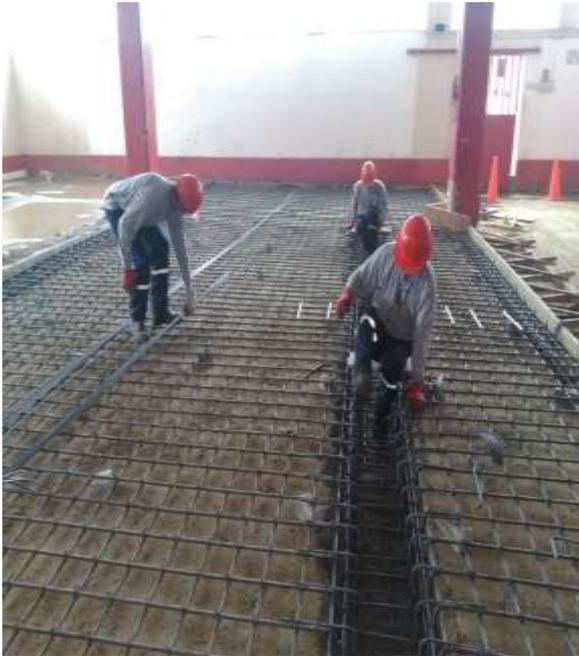
*Figura 58:* Armadura para canal de evacuación de agua.
