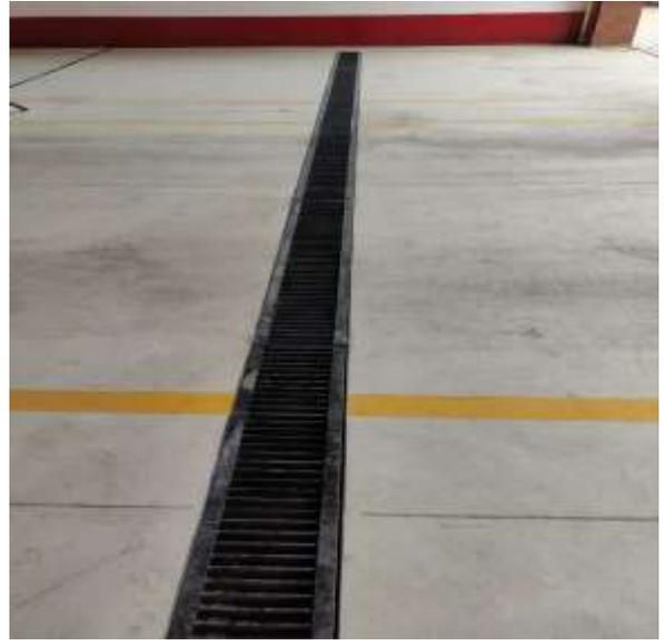
*Figura 76:* Instalación de rejilla metálica de PL 2''x1/4'' @ 1''
