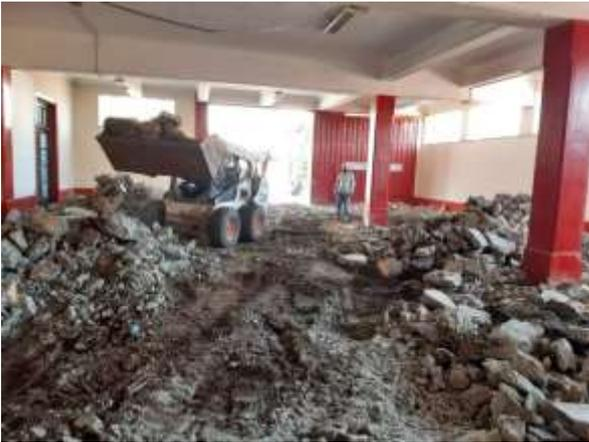
*Figura 44:* Eliminación de desmonte con mini cargador frontal.
