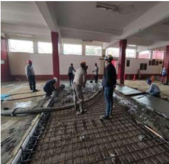
*Figura 67:* Vaciado de concreto  $f'c$  280 kg/cm<sup>2</sup>, del segundo paño.
