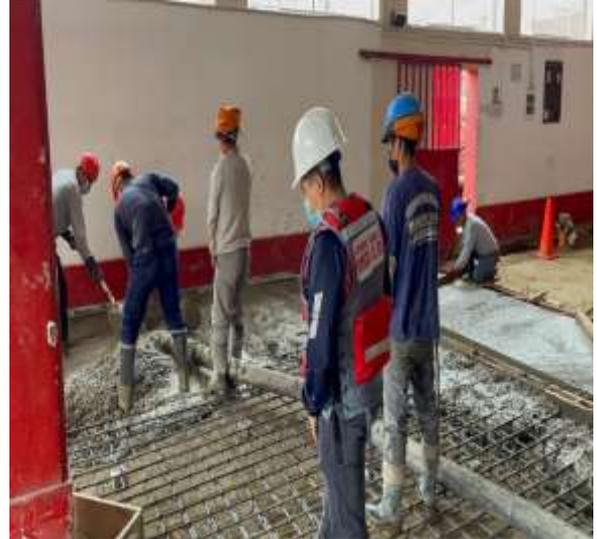
*Figura 66:* Supervisión del vaciado de concreto  $f'c$  280 kg/cm<sup>2</sup>, del segundo paño.
