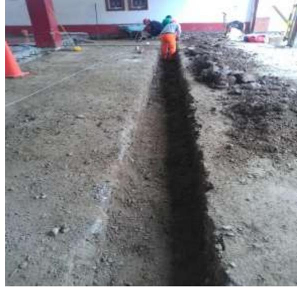
*Figura 62: Excavación, para canal de evacuación de agua.*
