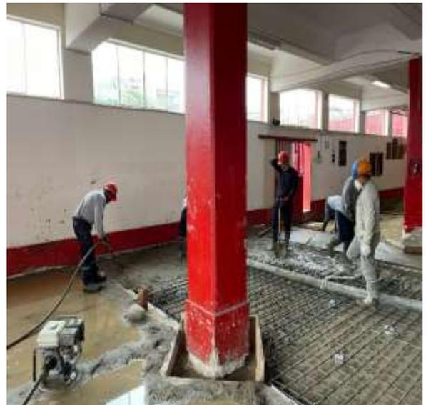
*Figura 68:* Se empleó una vibradora para una mejor compactación del concreto.
