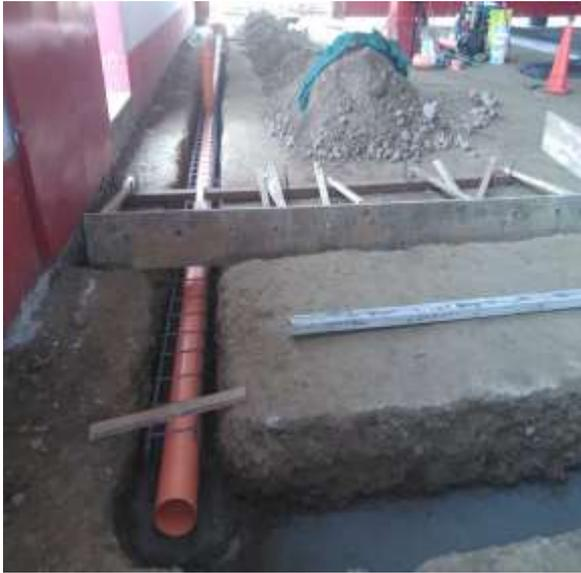
*Figura 61: Excavación, armadura e instalación de tubería de 8", para la evacuación de agua.*
