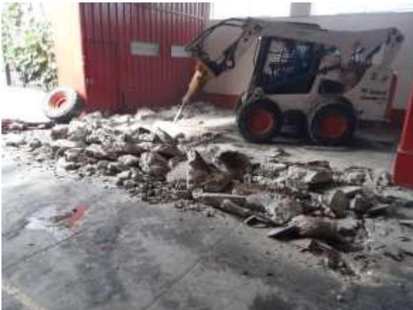
*Figura 41: Demolición de piso, Área "A"*
