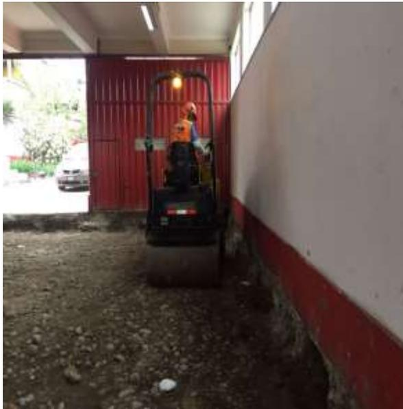
*Figura 47:* Aplanado del material propio del terreno (subrasante).
