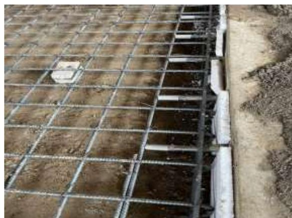
*Figura 57:* Colocación de dowels Ø 1” @ 0.30m.
