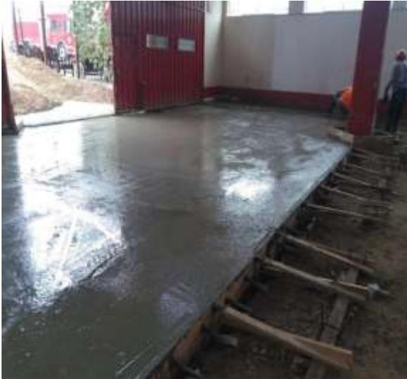
*Figura 65:* vaciado de concreto  $f'c$  280 kg/cm<sup>2</sup>, del primer paño.
