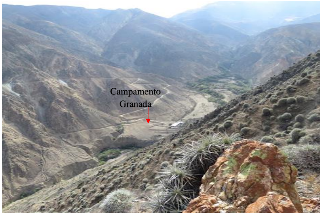
Figura N° 28: Vista NW-SE panorámica tomada desde el frente del Cerro Santa Rosa.
