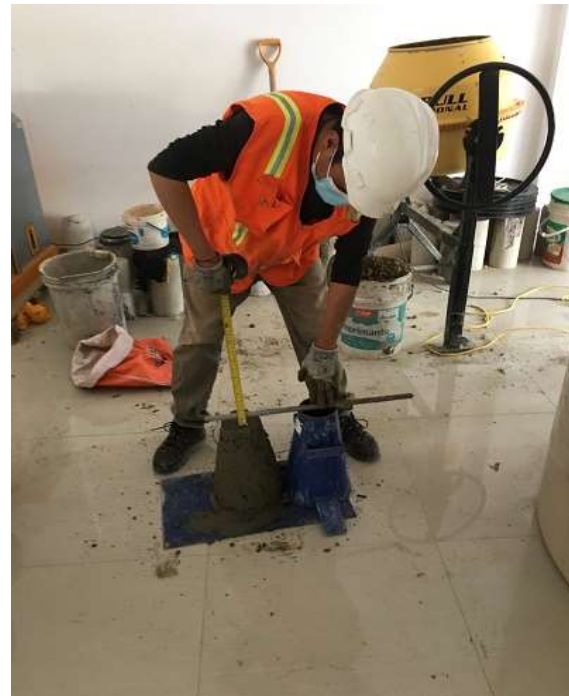
Fotografía N° 8. Asentamiento del concreto fresco.
