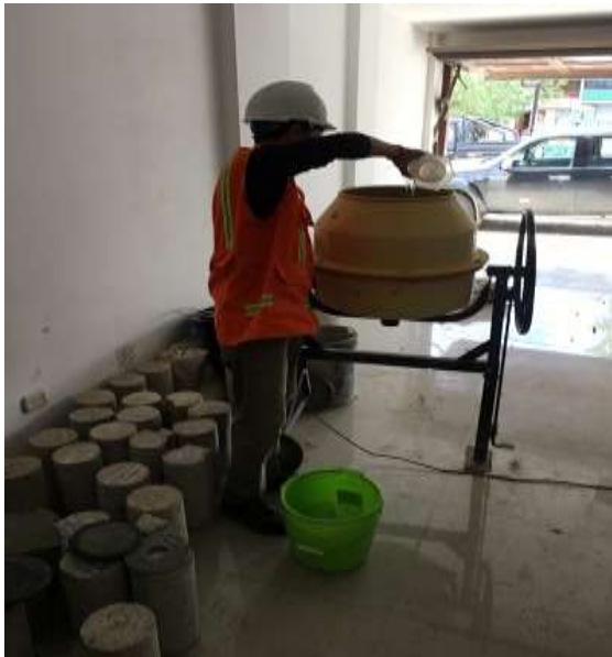
Fotografía N° 9. Mezclado de concreto.
