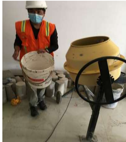
Fotografía N° 10. Mezclado de concreto.
