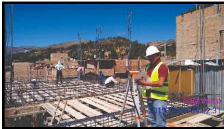
*Fotografía 8: Acero en losa aligerada*
