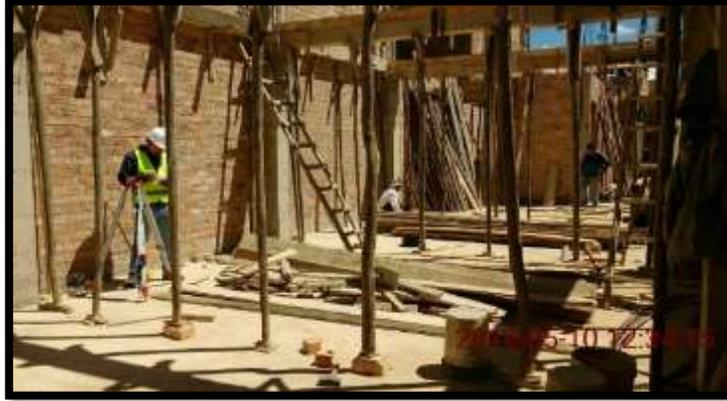
*Fotografía 1: Encofrado de losa aligerada*
