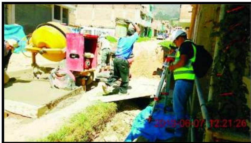
*Fotografía 15: Concreto en losa aligerada*
