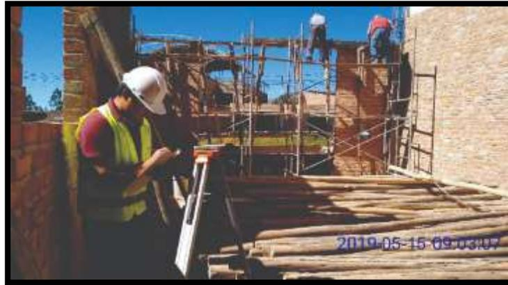
*Fotografía 7: Encofrado de losa aligerada*
