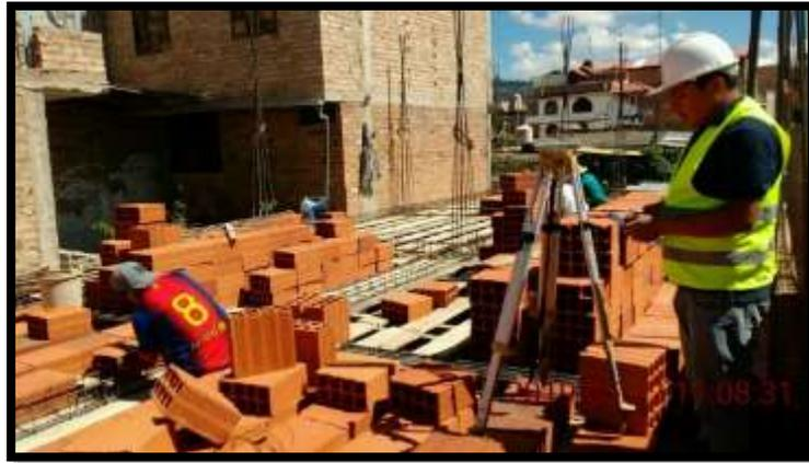
*Fotografía 2: Acero en losa aligerada*
