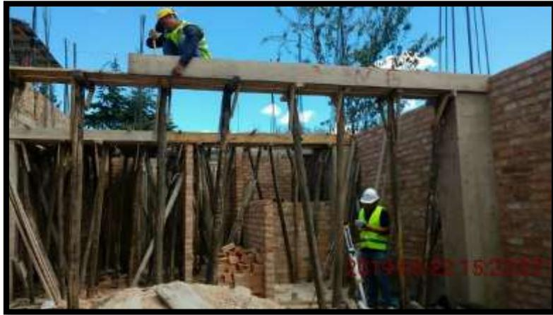
*Fotografía 10: Encofrado de losa aligerada*
