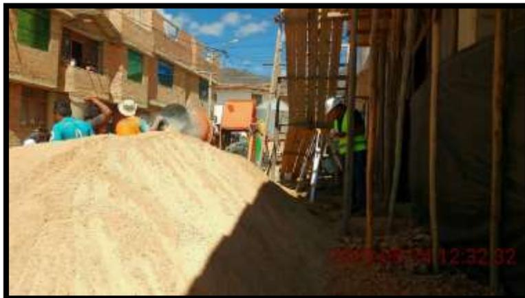
*Fotografía 3: Concreto en losa aligerada*
