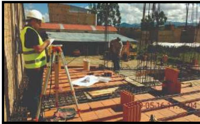
*Fotografía 5: Acero en losa aligerada*
