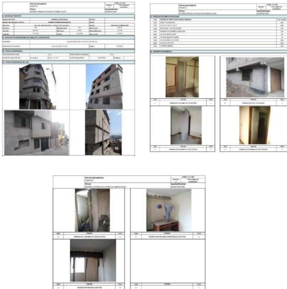
Cuarto Informe semanal (11/11/19 al 15/11/19) Reforzamiento a la Edificación.
