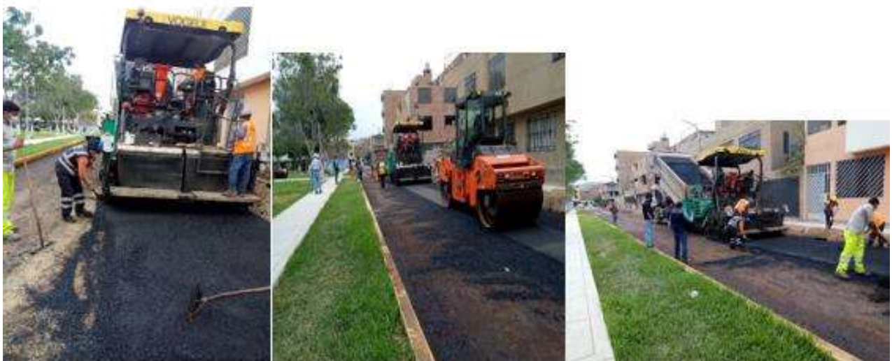
Figura 8. Construcción de Pistas en JR. Velasco San Martin de Porras
