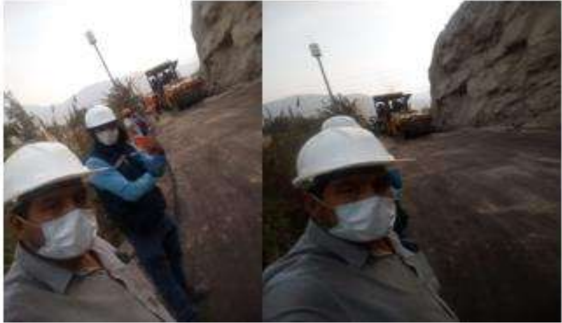
Figura 7. Construcción de Pavimento de la Av. Malecón Lurín en el distrito de Cieneguilla
