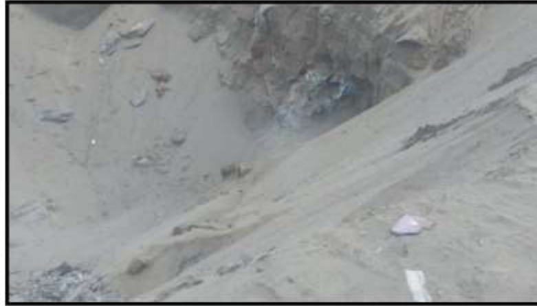
VISTA INTERIOR DE CALICATA II PROYECTO VENTANILLA DEPORTES
