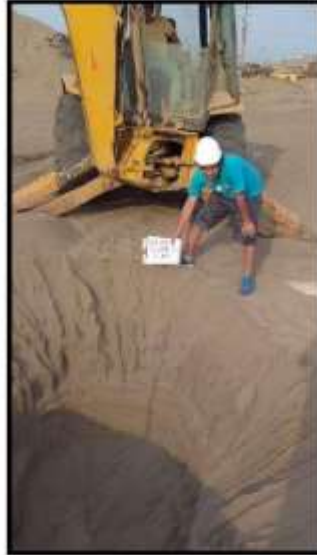
VISTA INTERIOR DE CALICATA XVII PROYECTO VENTANILLA DEPORTES
