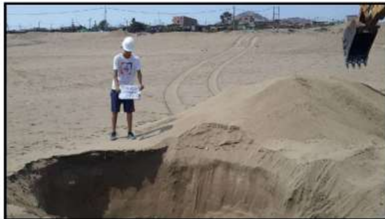
VISTA EXTERIOR DE CALICATA VIII PROYECTO VENTANILLA DEPORTES
