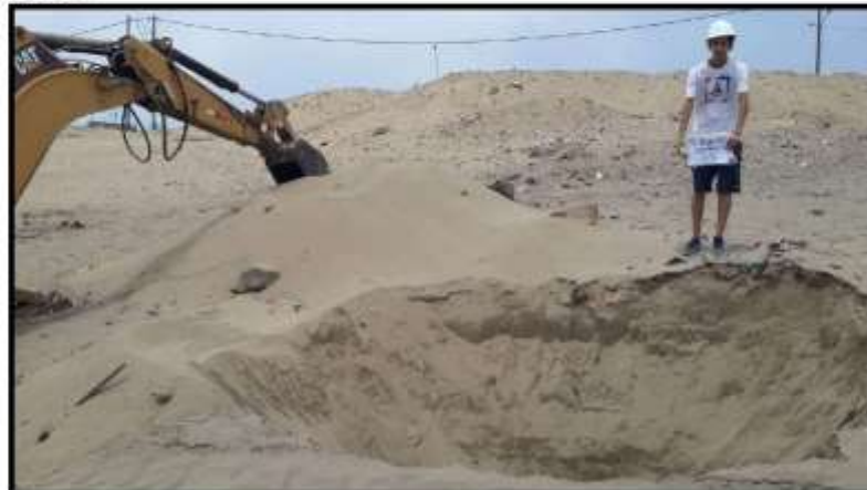
VISTA EXTERIOR DE CALICATA IV PROYECTO VENTANILLA DEPORTES
