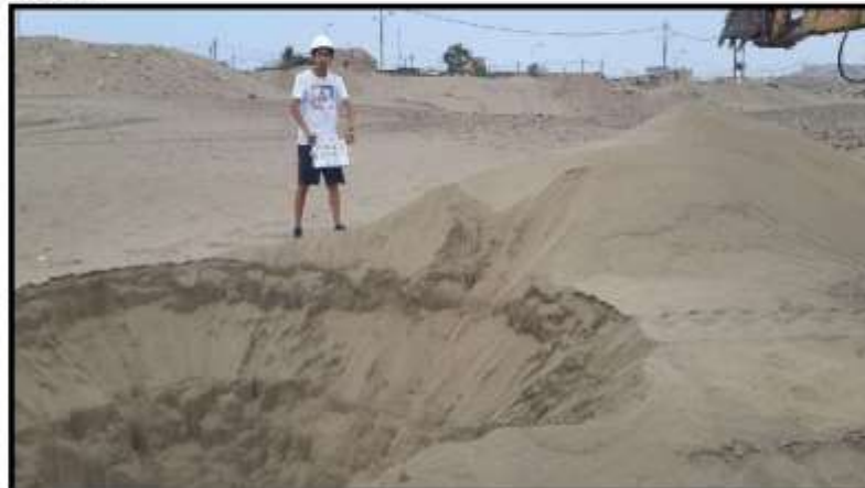
VISTA EXTERIOR DE CALICATA VI PROYECTO VENTANILLA DEPORTES
