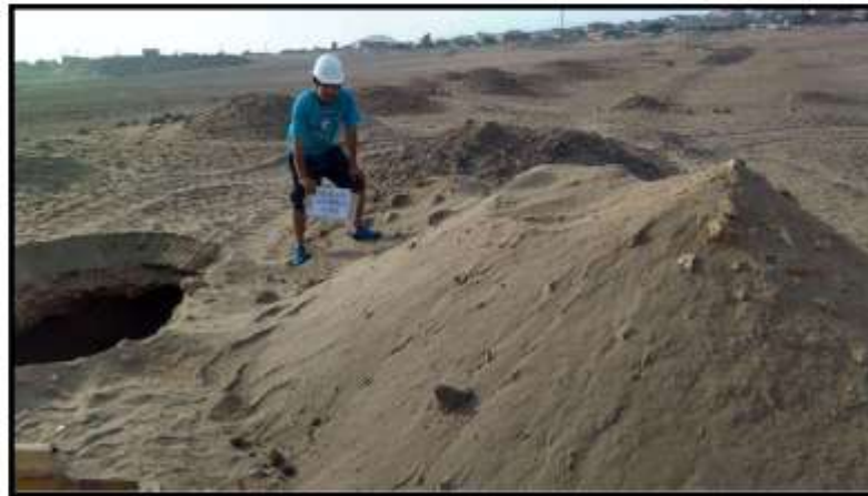
VISTA EXTERIOR DE CALICATA XVI PROYECTO VENTANILLA DEPORTES
