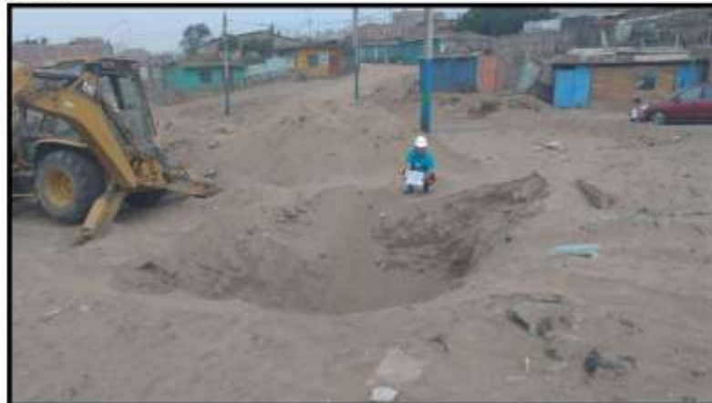
VISTA EXTERIOR DE CALICATA II PROYECTO VENTANILLA DEPORTES
