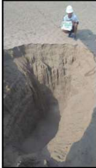
VISTA INTERIOR DE CALICATA XIV PROYECTO VENTANILLA DEPORTES
