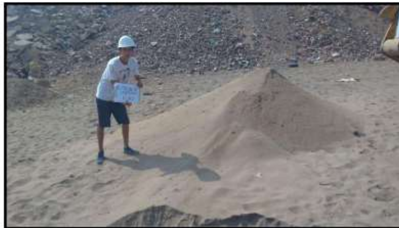
VISTA EXTERIOR DE CALICATA XII PROYECTO VENTANILLA DEPORTES
