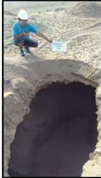
VISTA INTERIOR DE CALICATA XVI PROYECTO VENTANILLA DEPORTES
