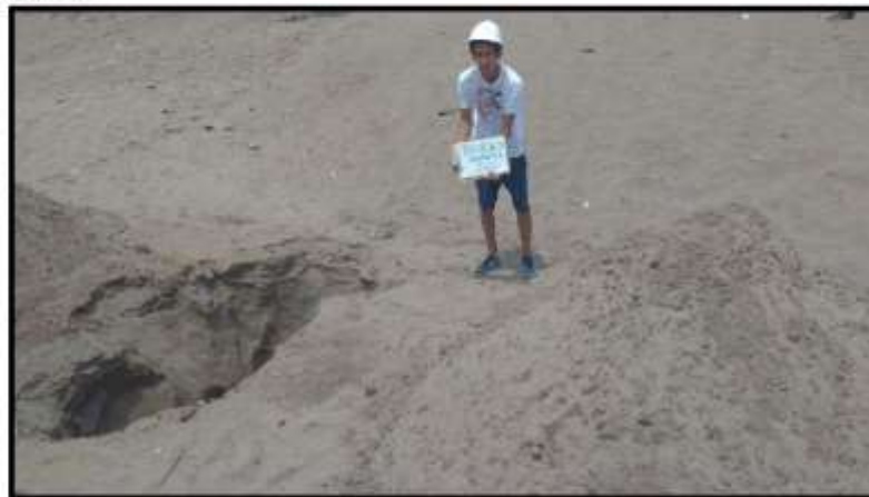
VISTA EXTERIOR DE CALICATA I PROYECTO VENTANILLA DEPORTES
