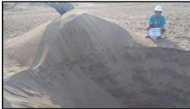
VISTA EXTERIOR DE CALICATA XV PROYECTO VENTANILLA DEPORTES
