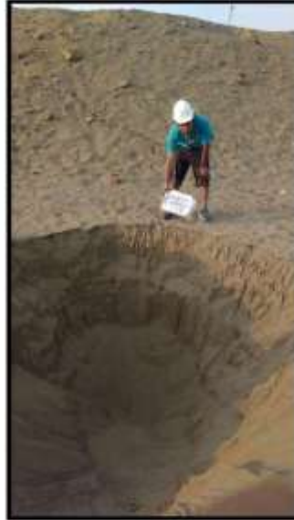
VISTA INTERIOR DE CALICATA XX PROYECTO VENTANILLA DEPORTES
