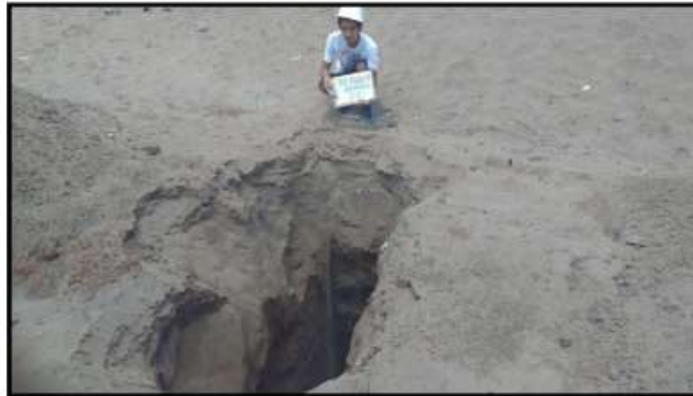
VISTA INTERIOR DE CALICATA I PROYECTO VENTANILLA DEPORTES
