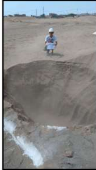
VISTA INTERIOR DE CALICATA IX PROYECTO VENTANILLA DEPORTES
