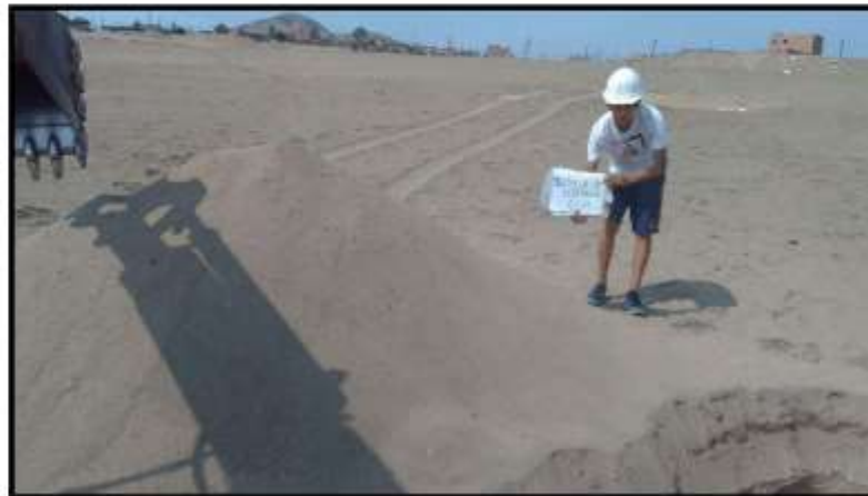
VISTA EXTERIOR DE CALICATA XI PROYECTO VENTANILLA DEPORTES
