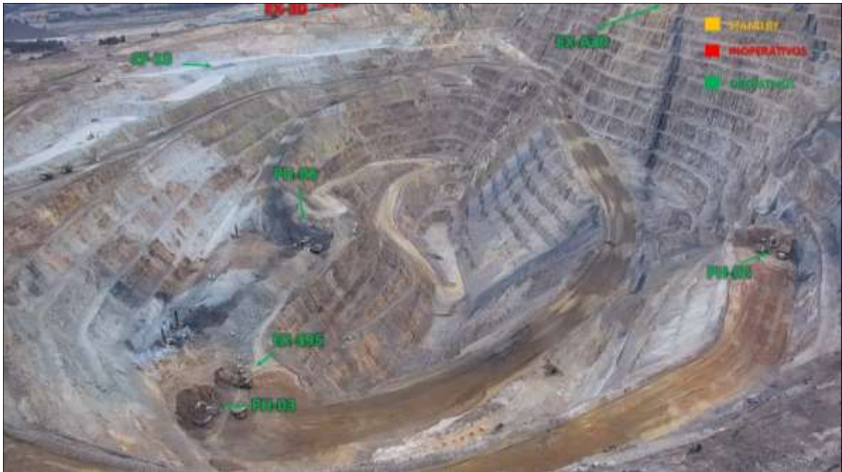
Figura 01. Zona de partida del carguío de material minero.
