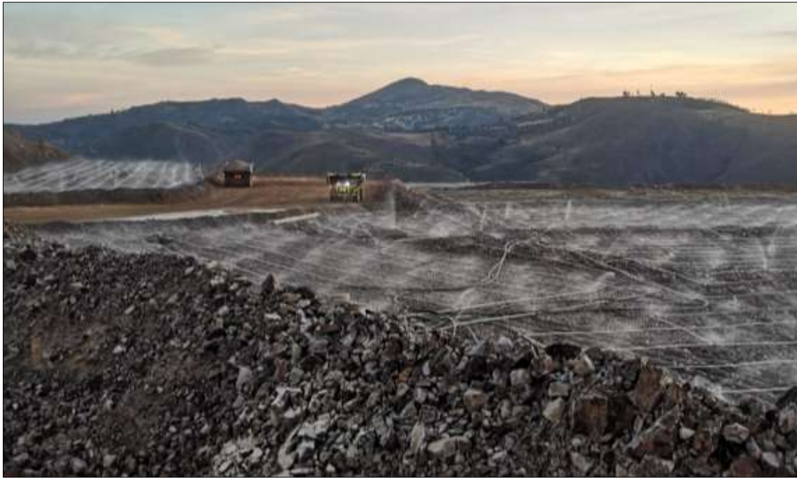
Figura 05. Ingreso a la zona de descarga de mineral.
