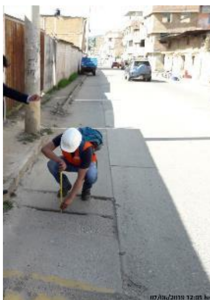
Imagen 6: Medición de canal, el tirante nominal del elemento estructural.
