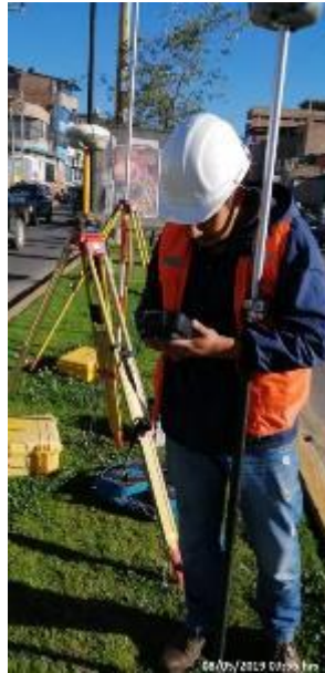
Imagen 1: Estacionamiento de base de GPS diferencial, como primer paso para el levantamiento topográfico.
