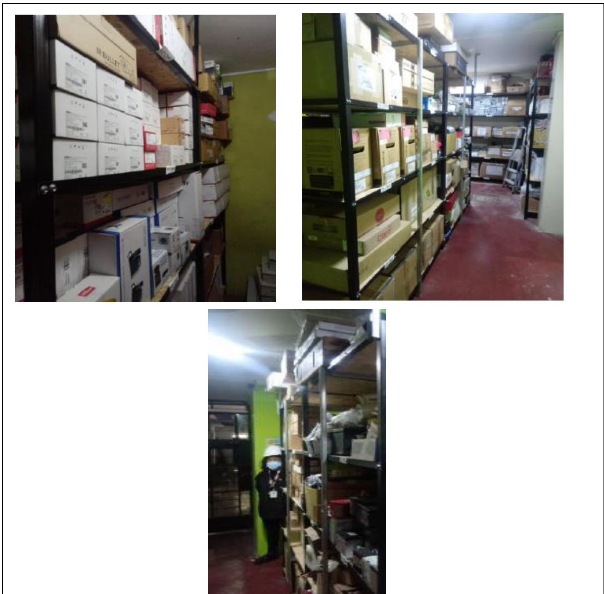
Figura 13: Equipos en buen estado
