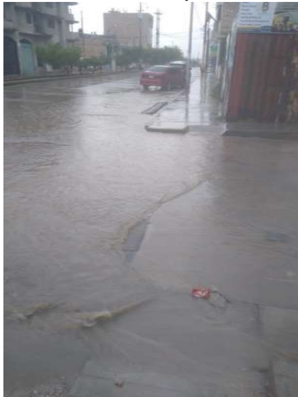
Foto N° 12: El sistema de se abastece para la evacuación de las aguas.
