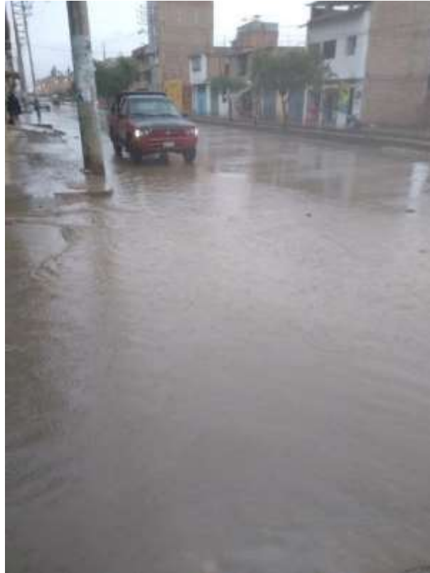
Foto N° 14: Se muestra que la cuneta ya no abastece el caudal
