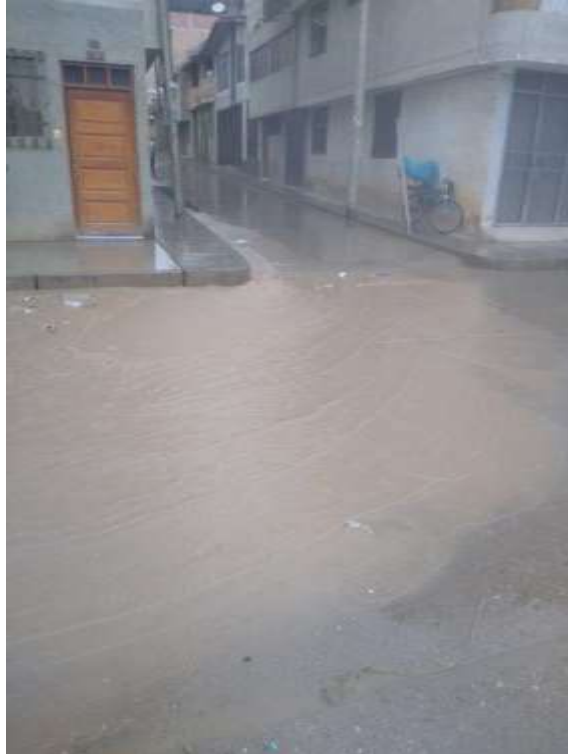
Foto N° 12: No tiene donde evacuar las aguas de lluvia.
