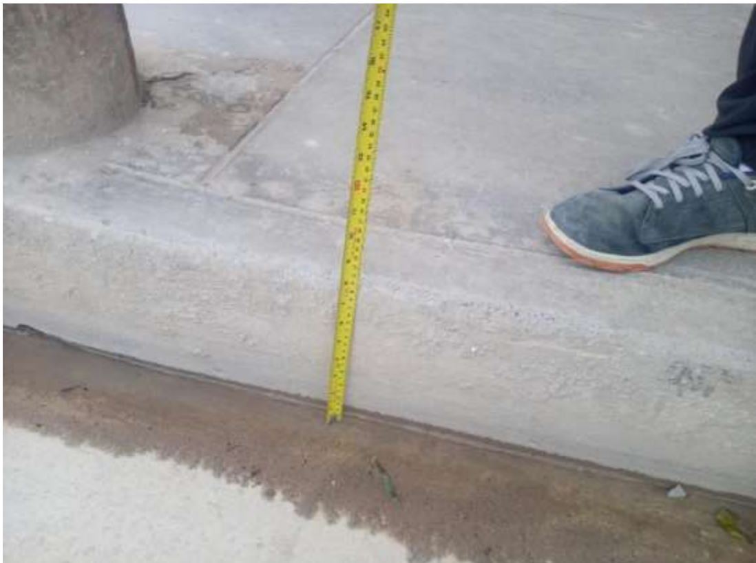
Foto N° 09: Medida de la cuneta existente.
