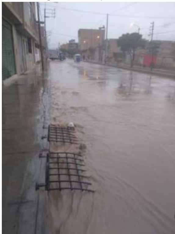
Foto N° 14: Se muestra que la cuneta ya no abastece el caudal
