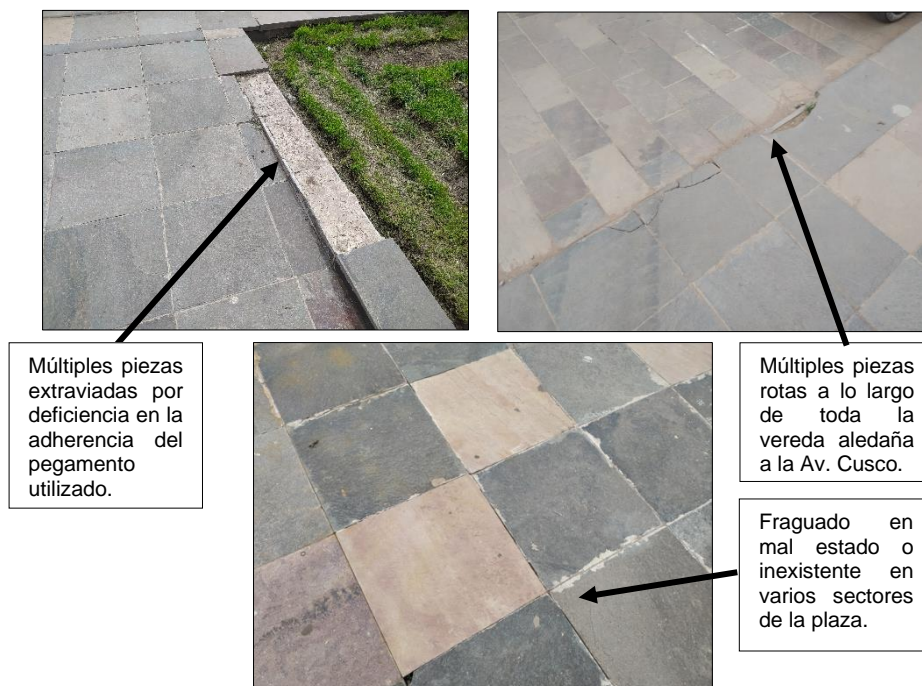
Figura 20 - Observaciones a piso de laja de piedra
