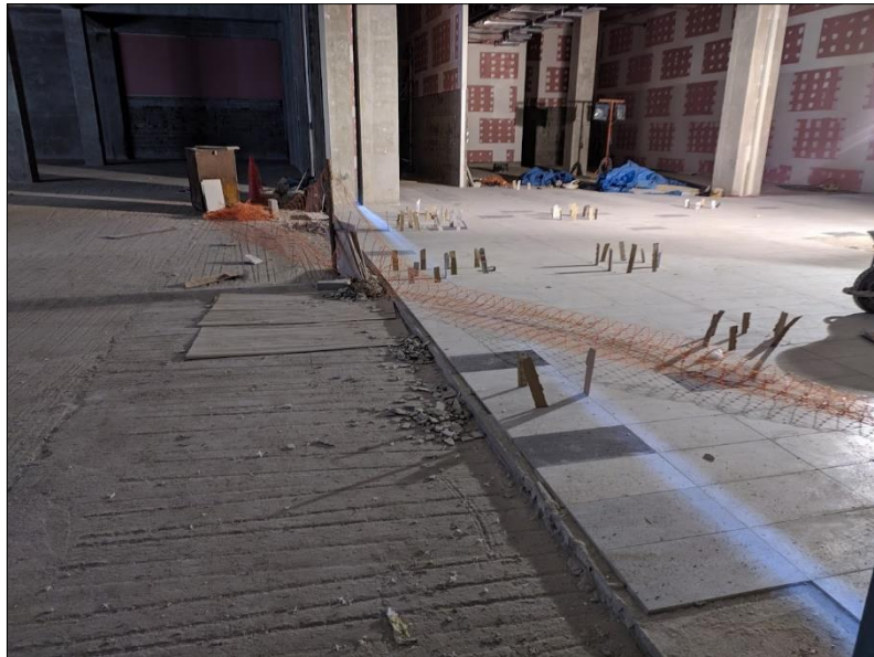
Figura 33 - Encuentro de piso terminado del Centro Comercial con el límite del casco Ripley
