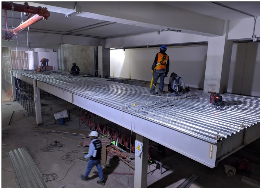
Figura 12 - Montaje de las EEMM de mezzanine para SSHH 2do piso
