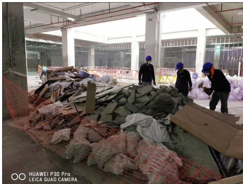
Figura 37 - Desmante derivado de la demolición de contrapiso
