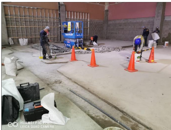
Figura 35 - Demolición y reposición del contrapiso cajoneado
