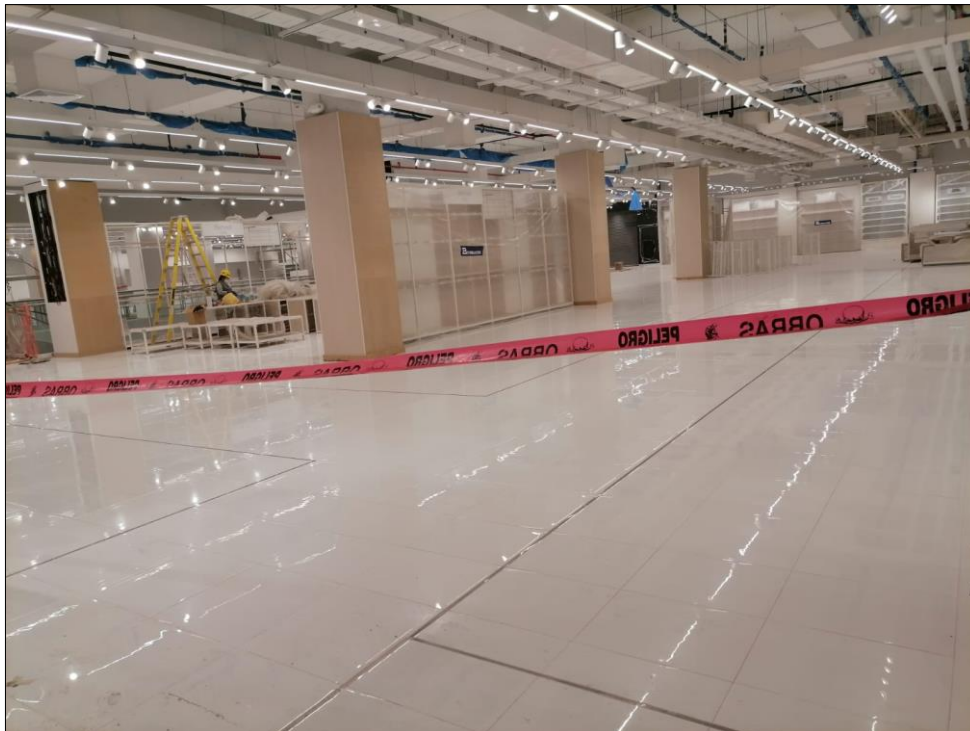
Figura 38 - Resultado del enchape en pasillos del área de ventas
