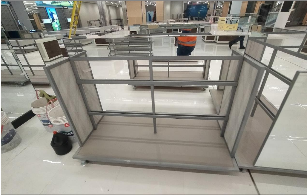
Figura 16 - Implementación de muebles de parte de los mueblistas del cliente
