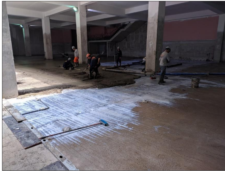
Figura 34 - Aplicación de la adherente químico según proceso constructivo del contratista
