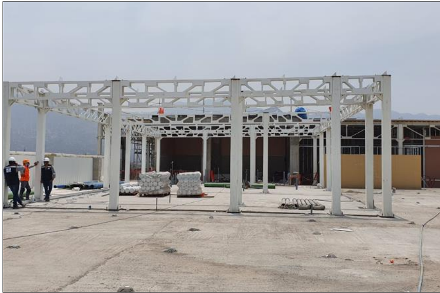
Figura 12 - Montaje de las EEMM de mezzanine para SSHH 2do piso
