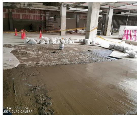
Figura 35 - Demolición y reposición del contrapiso cajoneado
