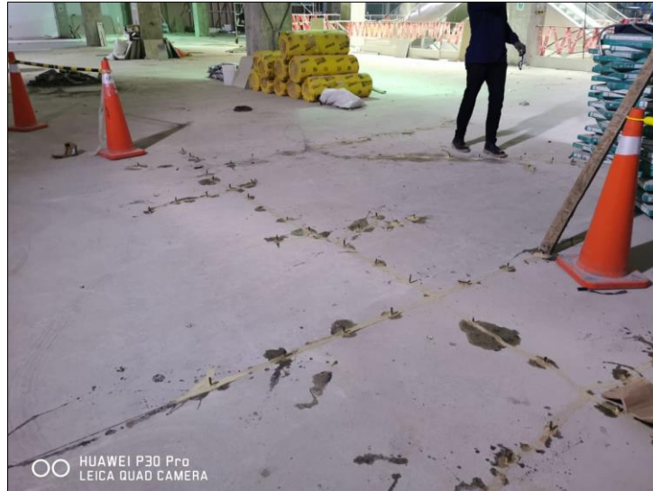
Figura 36 - Reparación de cajoneo mediante método de inyección de resina epoxi
