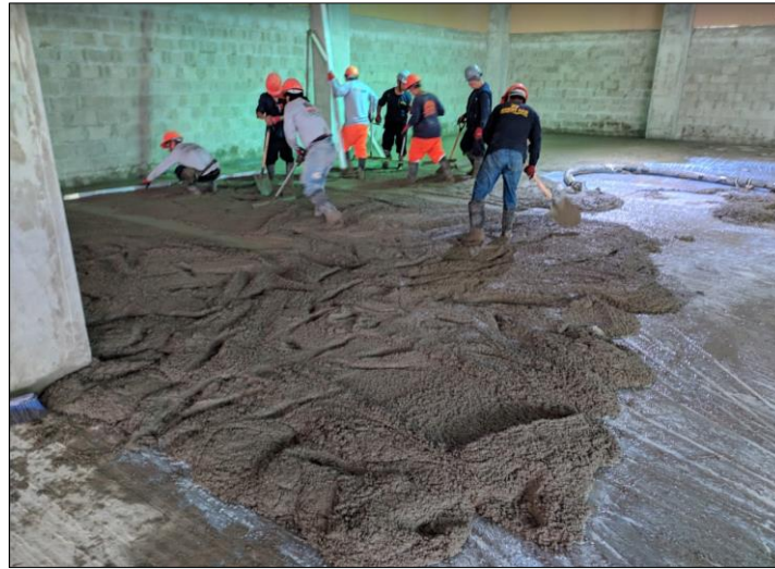
Figura 7 - Cuadrillas de regleado de concreto
