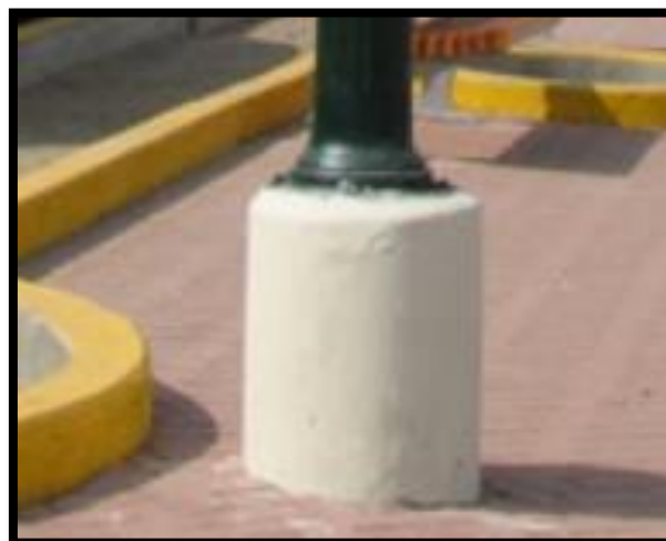
Figura 180. Pedestal de concreto armado para montaje de farolas
