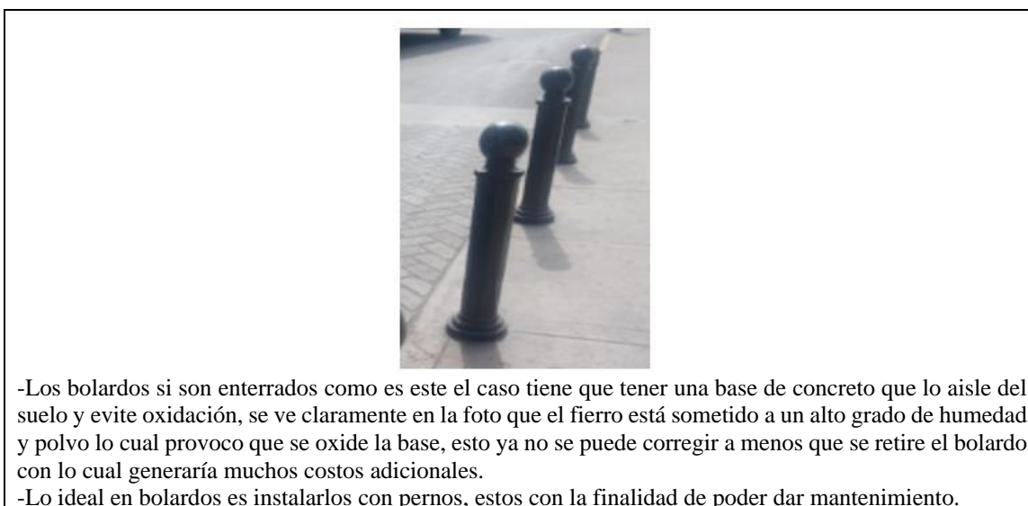
Figura 75. Evaluación de mobiliario urbano (bolardos) en Alameda de los Descalzos.
