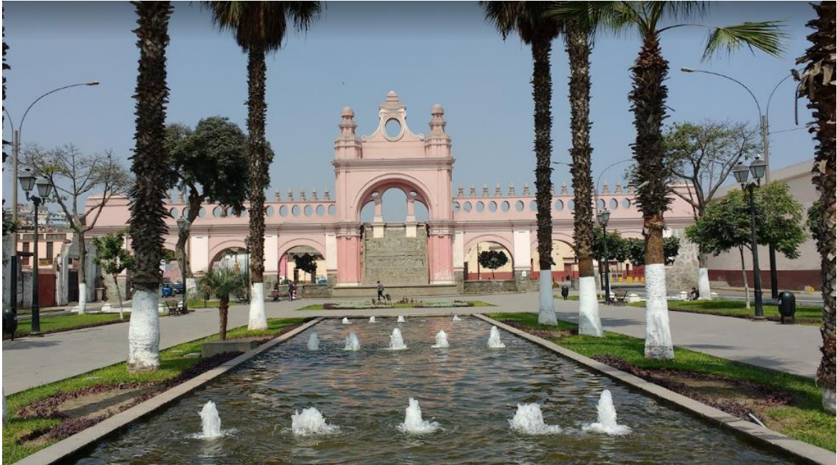
Figura 134. Vista diurna de los sistemas de electrificación en el Paseo de Aguas.
