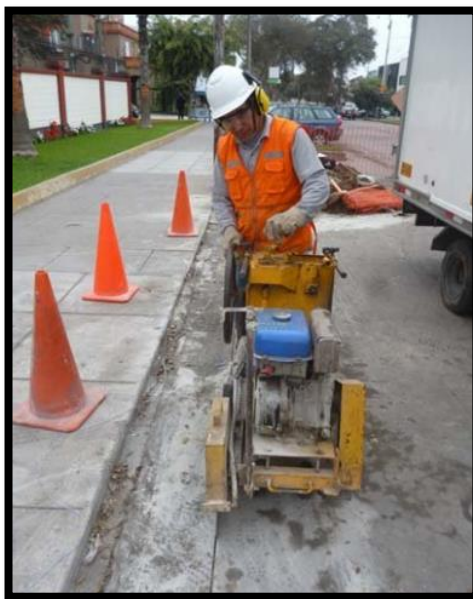
Figura 176. Procedimiento de corte de concreto.
