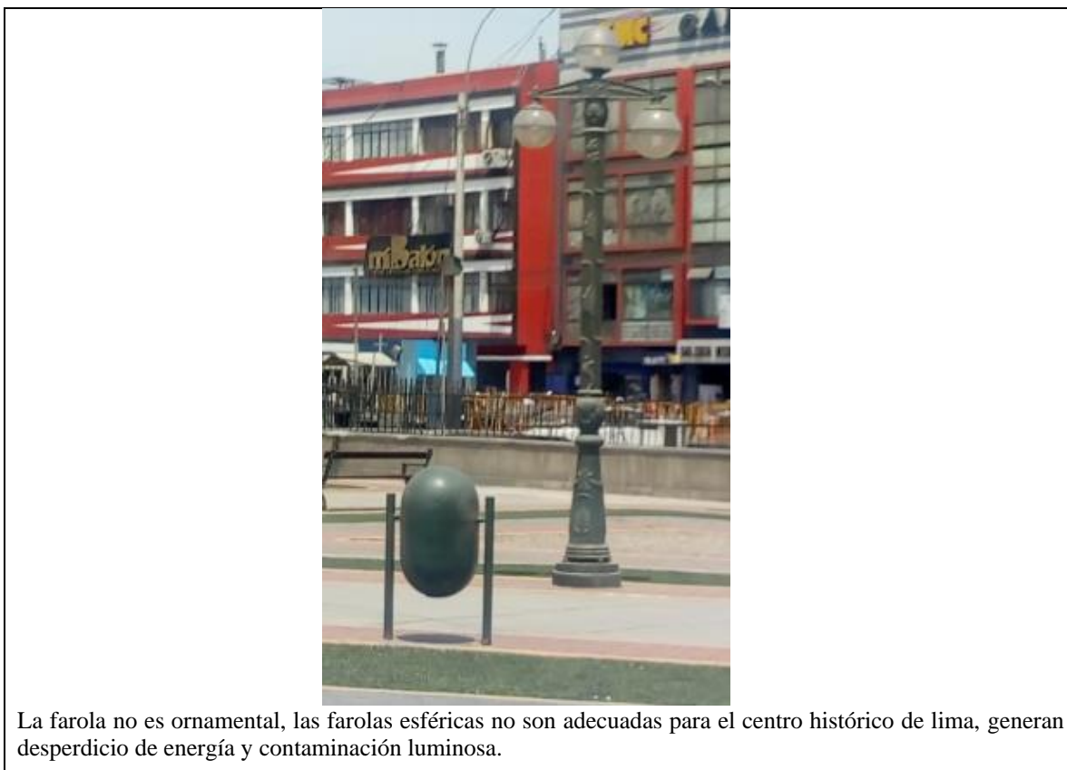
Figura 123. Vista diurna de los sistemas de electrificación en la Plaza Castañeda.
