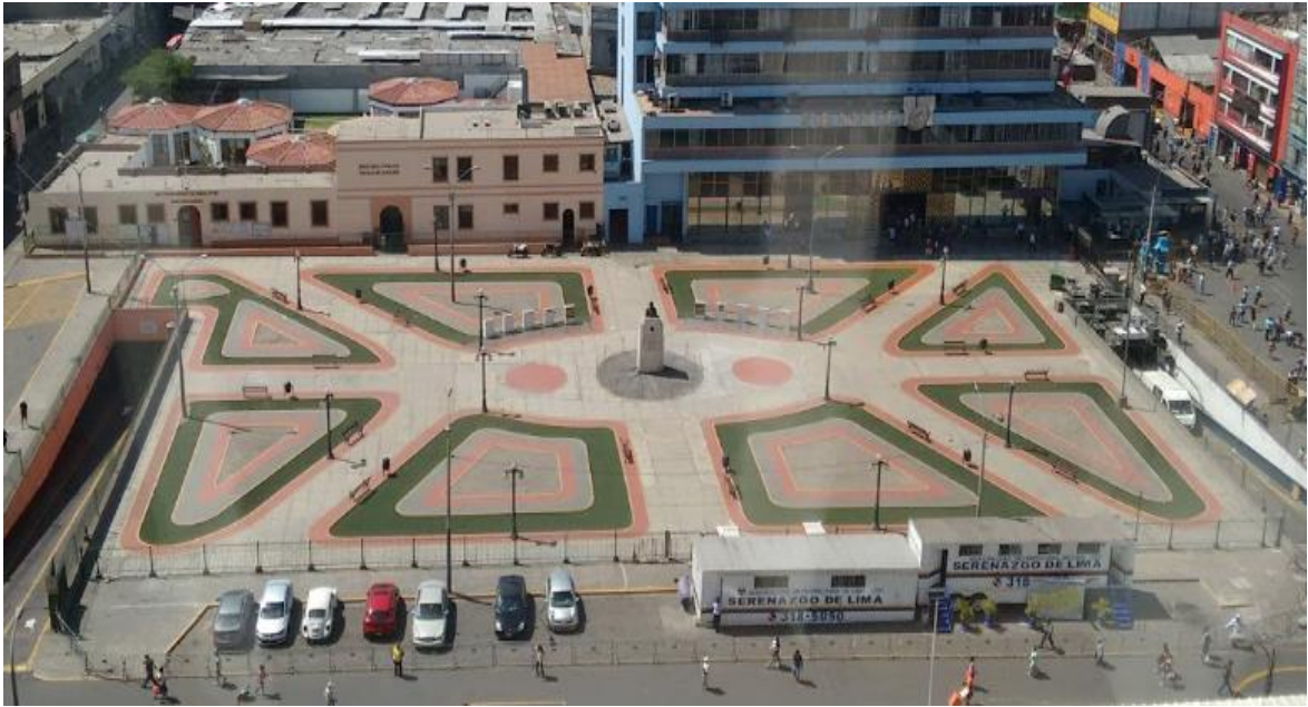
Figura 121. Vista diurna de los sistemas de electrificación en la Plaza Castañeda.
