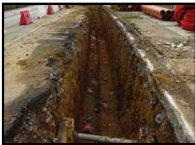
Figura 178. Zanja para cableado eléctrico subterráneo
