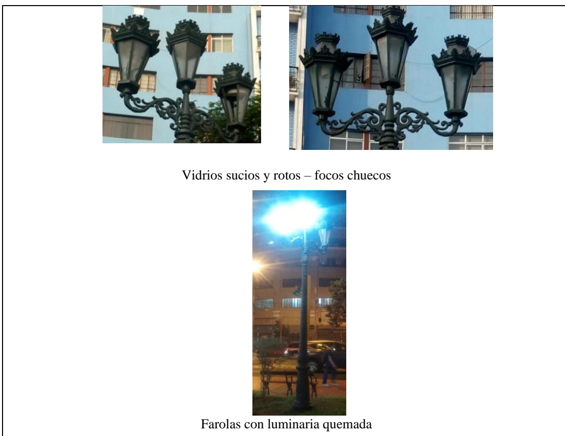
Figura 98. Vista diurna y nocturna de los sistemas de electrificación en la Plaza Elguera.
