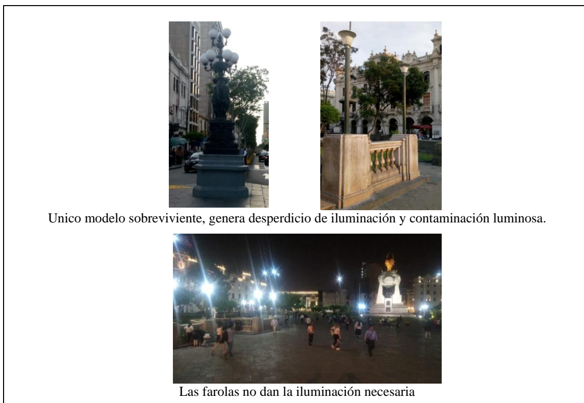
Figura 101. Vista diurna y nocturna de los sistemas de electrificación en la Plaza San Martín
