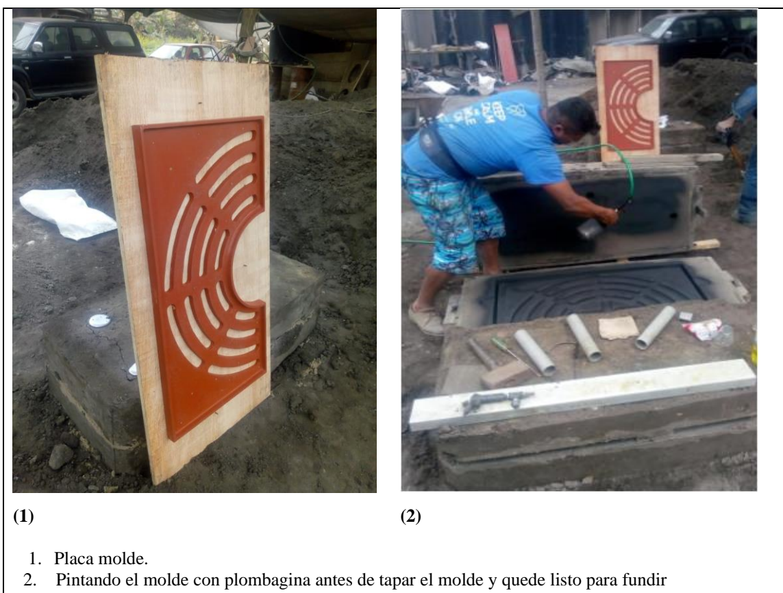
Figura 170. Proceso de fabricación alcorque de fierro fundido 1.
