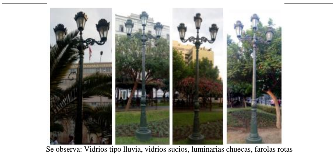
Figura 104. Vista diurna de los sistemas de electrificación en la Plaza la Democracia.
