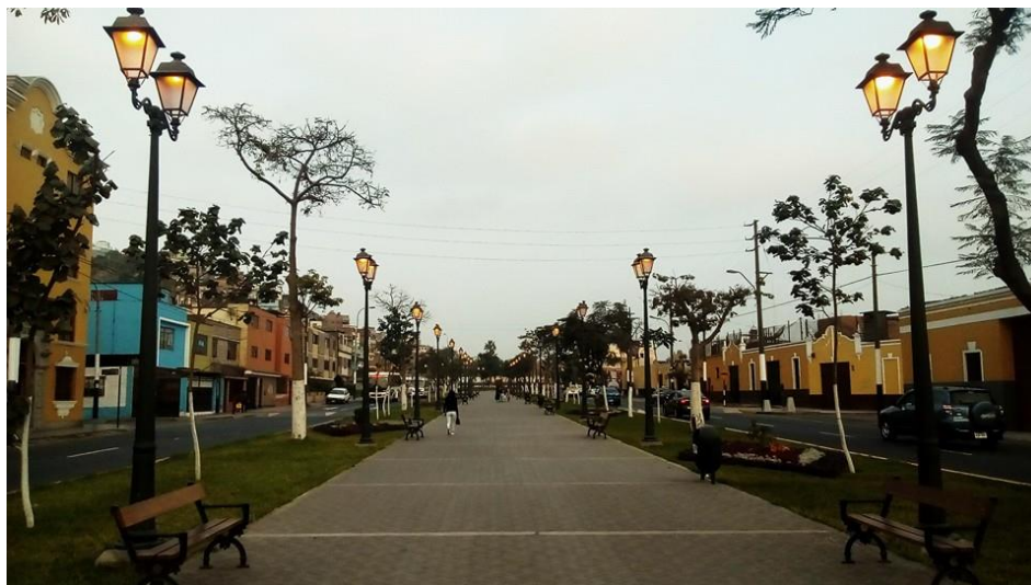
Figura 128. Vista diurna de los sistemas de electrificación en la alameda Los Bobos.
