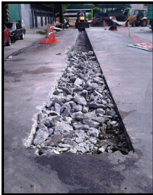
Figura 177. Picado y demolición de superficies de concreto.
