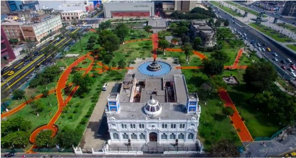
Figura 114. Vista diurna de los sistemas de electrificación en la Parque Juana Alarco de Dammert.
