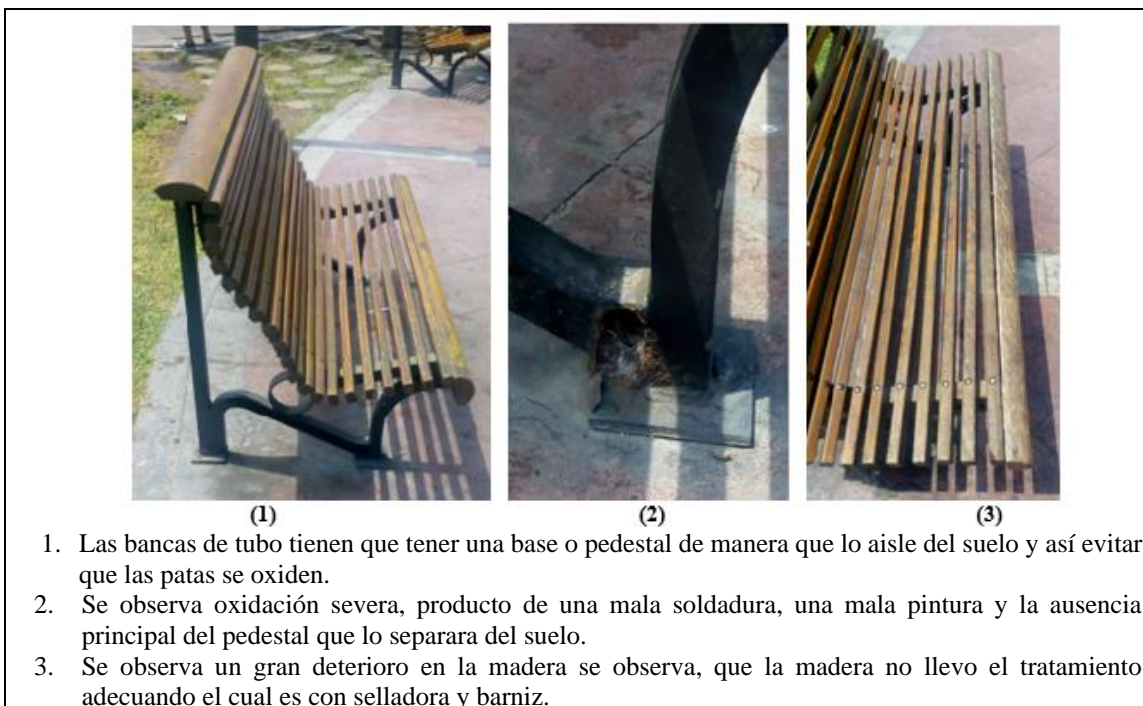
Figura 38. Evaluación de mobiliario urbano (bancas de tubo) en Plaza Italia.
