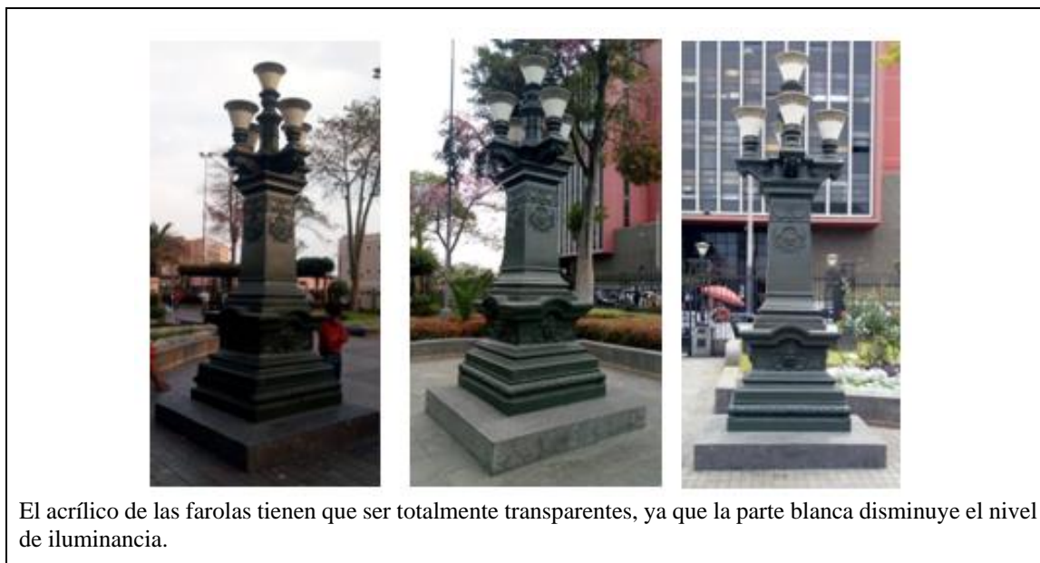
Figura 111. Vista diurna de los sistemas de electrificación del sector 1 del Parque Universitario.
