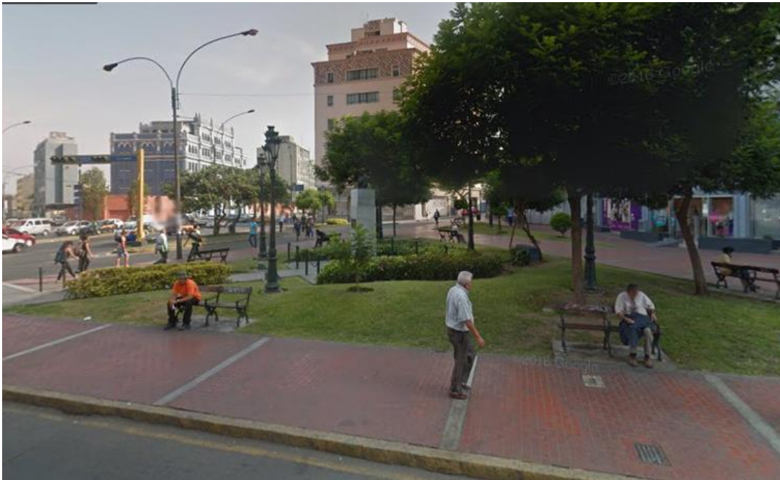
Figura 96. Vista diurna de los sistemas de electrificación en la Plaza Elguera.
