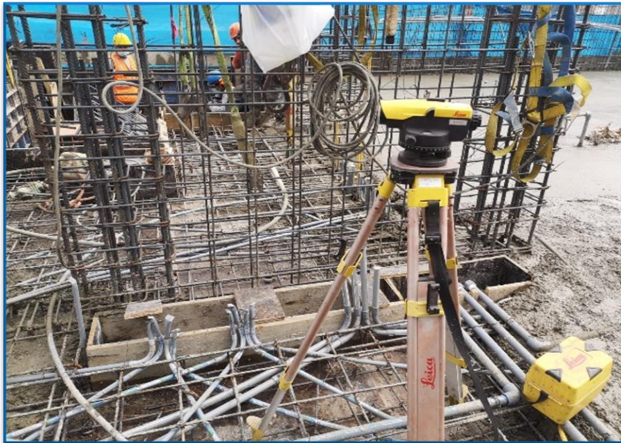
Figura 137. Verificación de niveles en vaciado de concreto en losas macizas y/o aligeradas.
