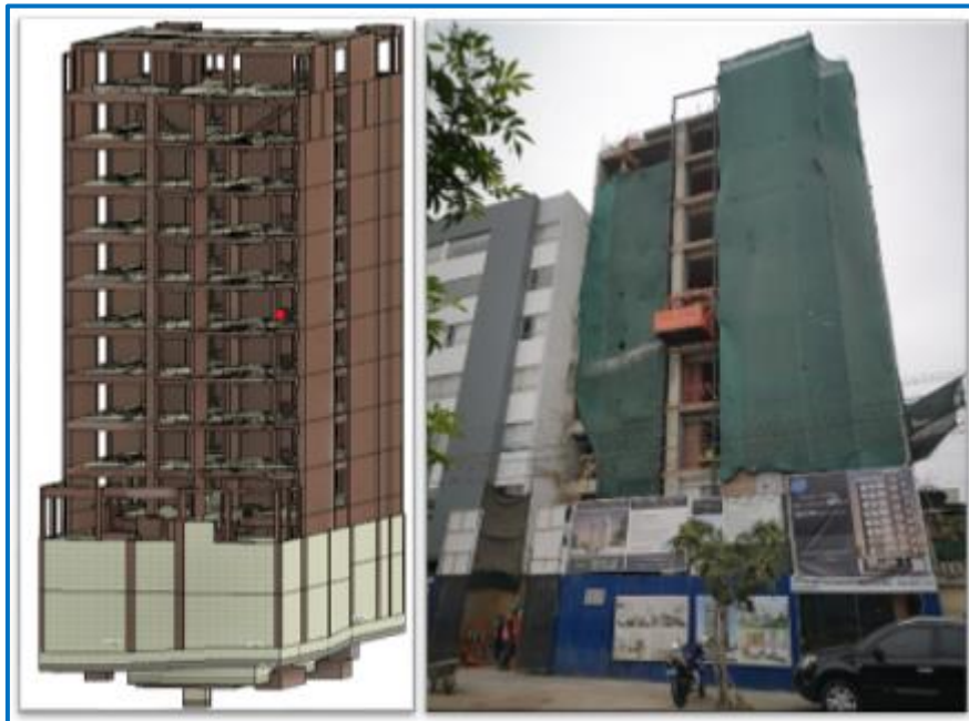
Figura 145. Modelo 3D y la culminación de la etapa estructural (casco terminado).
