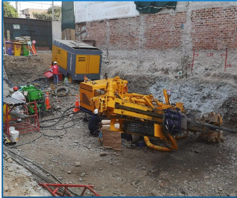
Figura 134. perforación e inyección de anclajes para la construcción de muros anclados.
