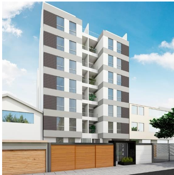
Figura 26. Proyecto multifamiliar Edna Razuri 344. Fuente: (MINCOPER, 2021)
