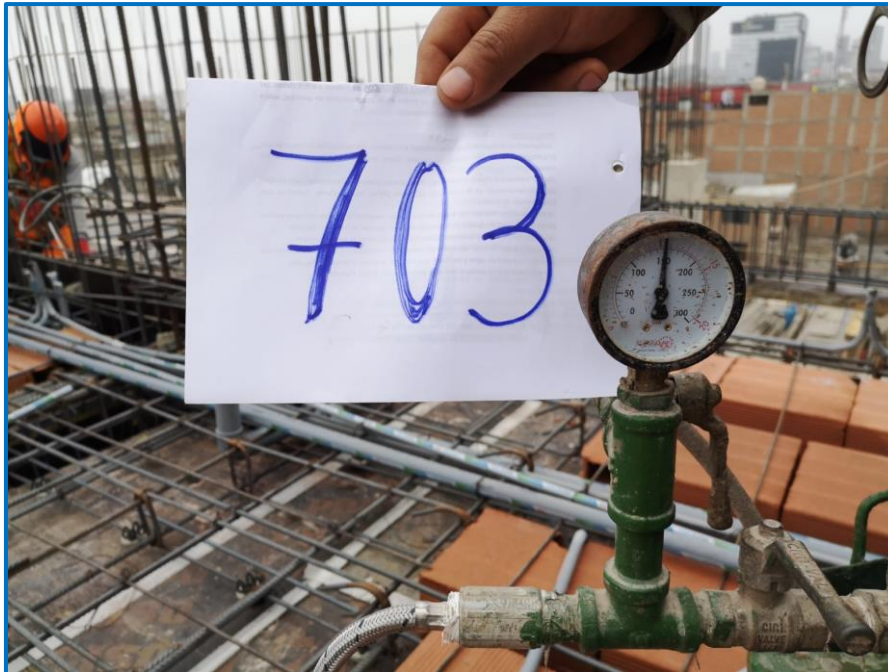
Figura 142. Verificación de prueba hidráulica en todos los departamentos antes del vaciado de la losa aligerada y/o maciza.
