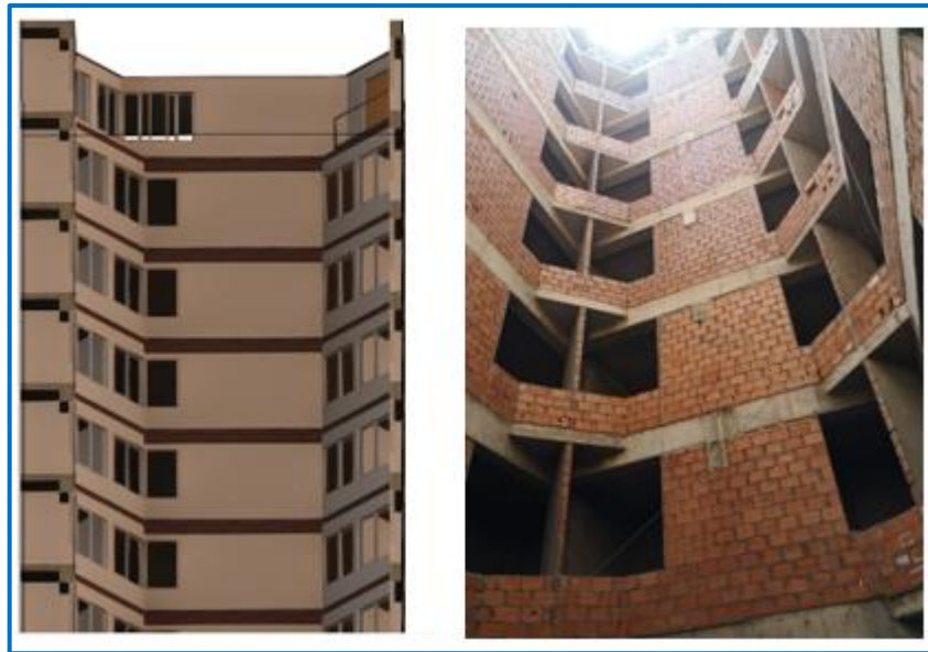
Figura 148. Modelo de arquitectura del ducto principal del edificio y foto real del ducto principal del edificio.
