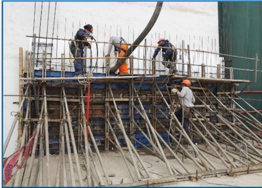
Figura 138. Colocación de acero, encofrado y vaciado de concreto con su respectivo vibrado en elementos verticales.
