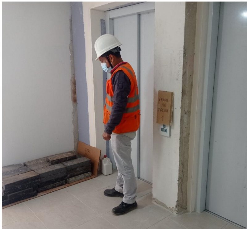
Figura 47. Área de trabajo limpio y ordenado, listo para iniciar los trabajos.
