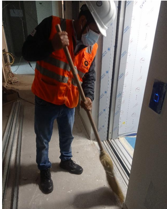
Figura 46. Limpieza del área de trabajo antes de comenzar las pruebas N°2.
