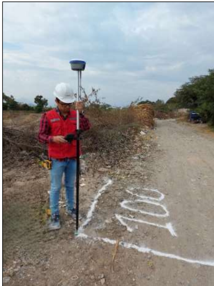
Figura 21. Toma de coordenadas con equipo GNSS.
