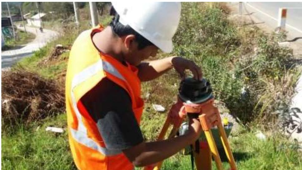
*Figura N° 47.* Fijación de base para GPS diferencial.
