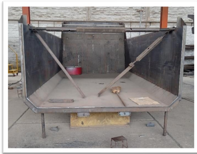
Figura 1.10: Proceso de armado de tolva
