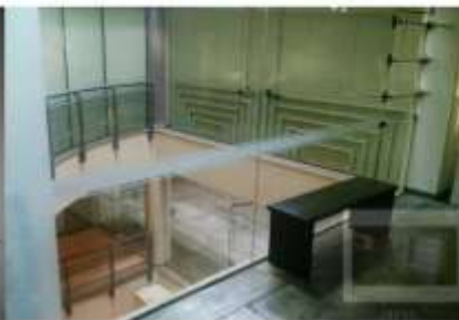
muro cortinas laminados para dividir espacios y atenuar el ruido
