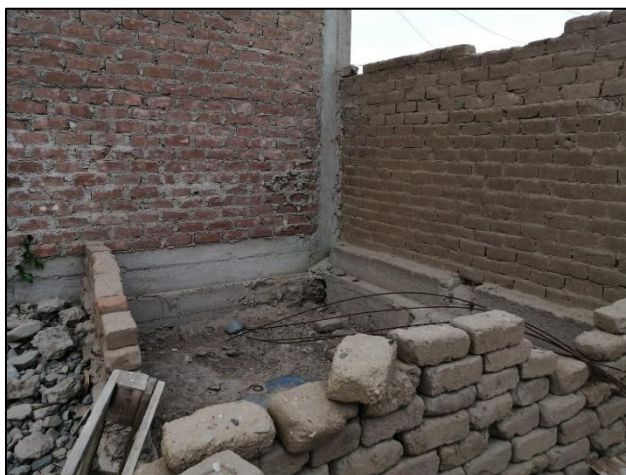
Figura 9: Vivienda con cimiento y sobrecimiento
