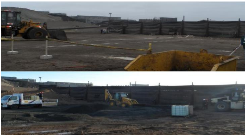
Figura N° 20: Proyecto 2 , preparación de terreno con uso de maquinarias
