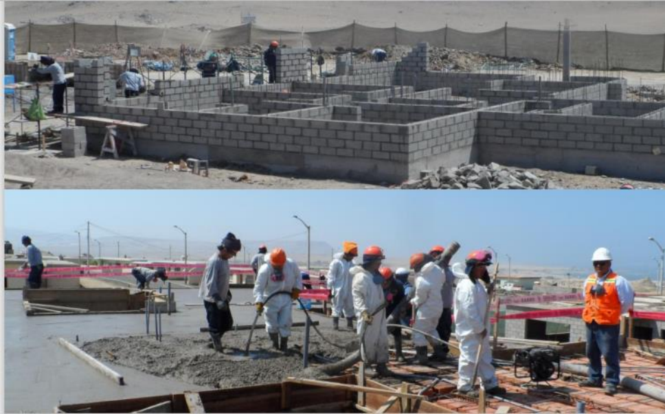
Figura N° 19: Proyecto 1 , construcción y vaciado de concreto
