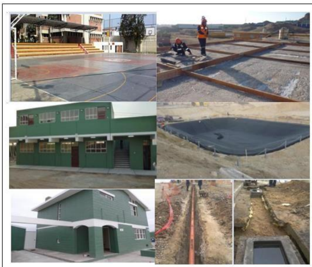
Figura N° 1: Obras de la empresa Constructora Gema E.I.R.L. Fuente: CONSTRUCTORA GEMA E.I.R.L.
