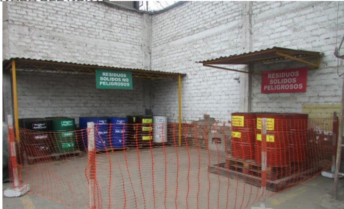
Figura 7. Ex zona de residuos sólidos.
