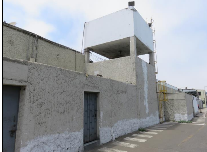
Figura 4. Pozo de agua subterránea.
