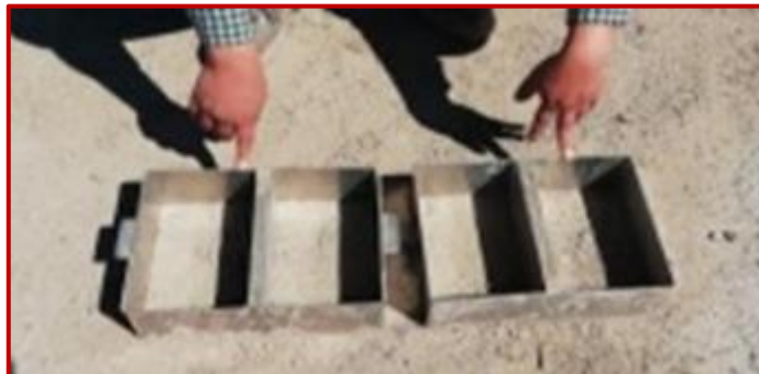
Figura 41. Moldeo de unidades de albañilería con mezcla de diatomita.
