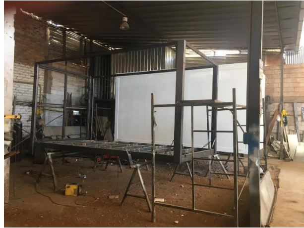
Figura 55 Estación de Soldado Fuente: Galería de Fotos Propias
