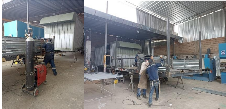
Figura 58 Area de producción Fuente: Galería de Fotos Propias
