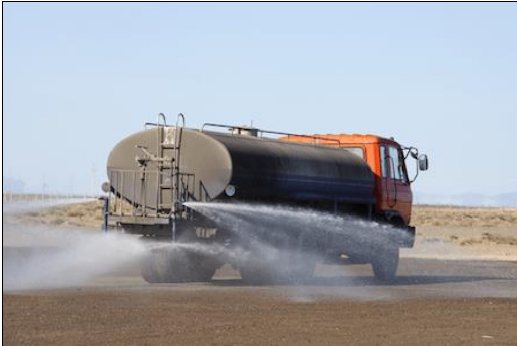
Figura 38: Realizar el regado de vías para evitar levantar el material particulado. Fuente: Elaboración propia, 2021.
