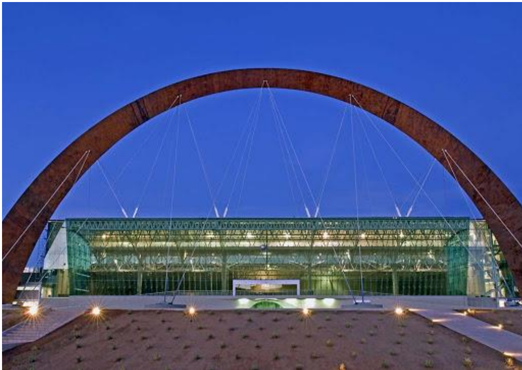
Figura 5. Vista frontal del caso 5
