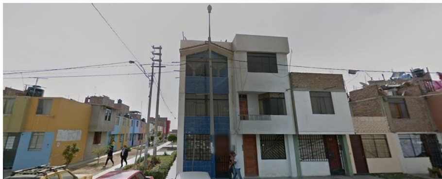
Figura 3: Exterior Este Vía Peatonal 4 Suyos
