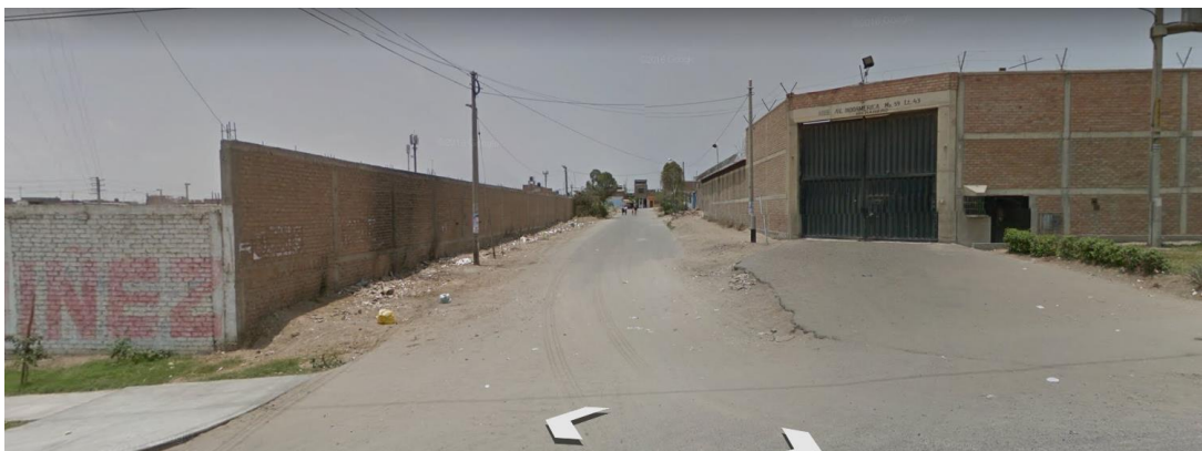
Figura 11: Avenida 9 Terreno N° 1
