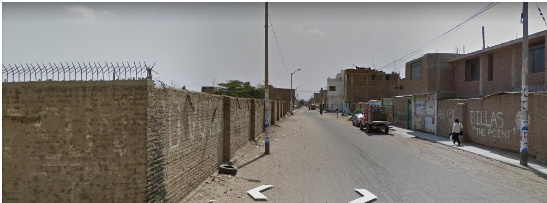
Figura 19: Vista Calle Chacabuco Terreno Nº 2
