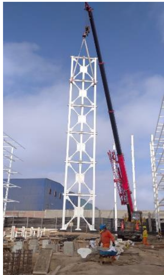
Figura N. °12: Proceso de Armado y montaje de Cubo antes de la mejora
