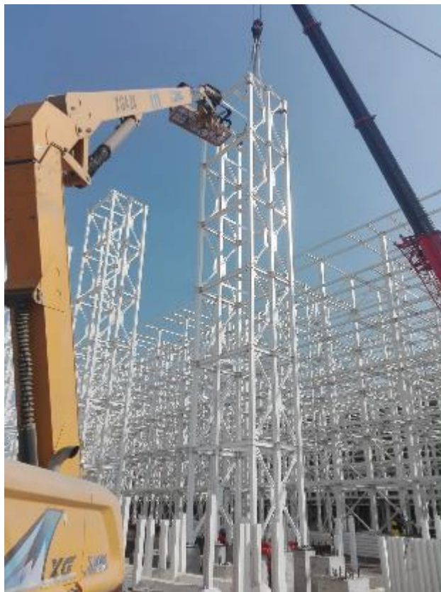
Figura N. °13: Proceso de Armado y montaje de Cubo mejorado
