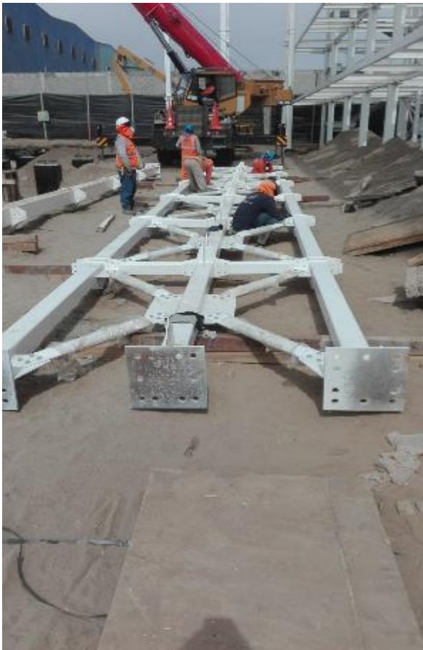
Figura N. °12: Proceso de Armado y montaje de Cubo antes de la mejora
