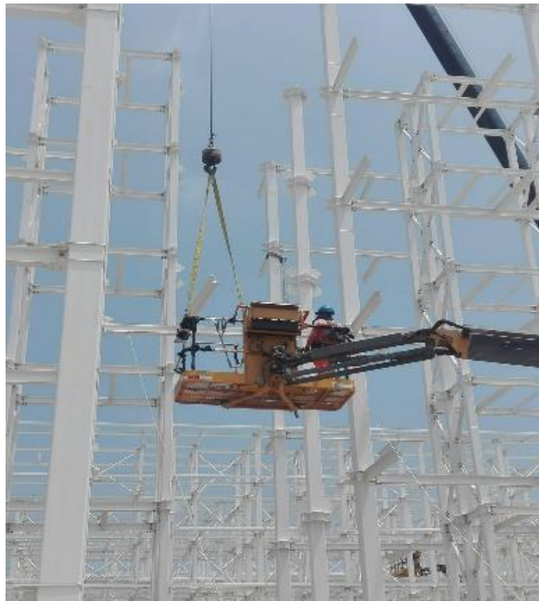
Figura N. °10: Proceso de Columnas con Misceláneos antes de la mejora
