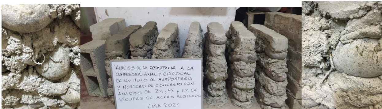
Figura 43: Se aprecia una viruta de acero sobresaliendo en los muretes terminados.
