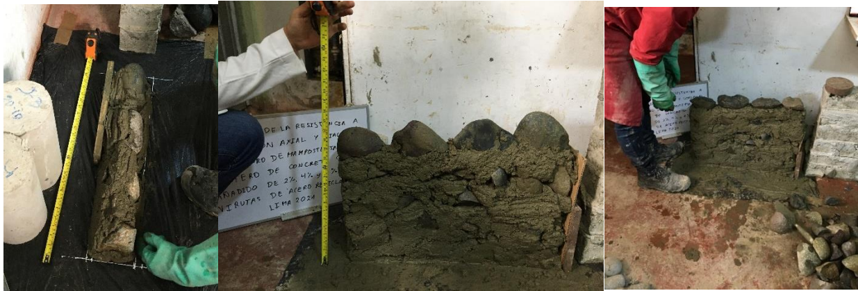
Figura 42: Levantamiento de los muretes verificando las medidas.
