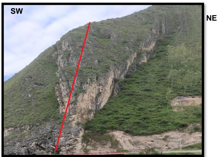
Figura 6. En el gráfico se muestra escarpes a margen derecho de la carretera Chilete – tembladera
