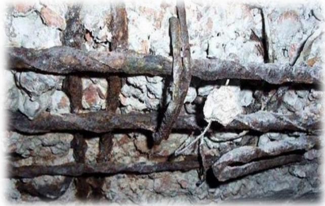
Figura 01: oxidación del acero de
