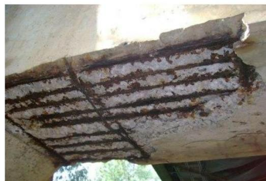
**CORROSIÓN DEL ACERO EN LOSA ALIGERADA DE CONCRETO**
