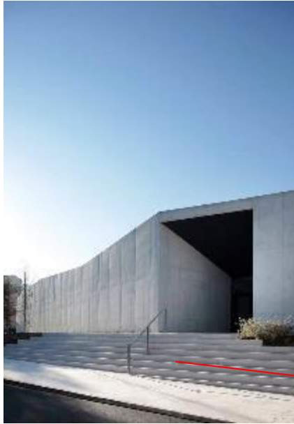
Figura 11: Plataforma de acceso principal Fuente: Lc Arquitectura,2015
