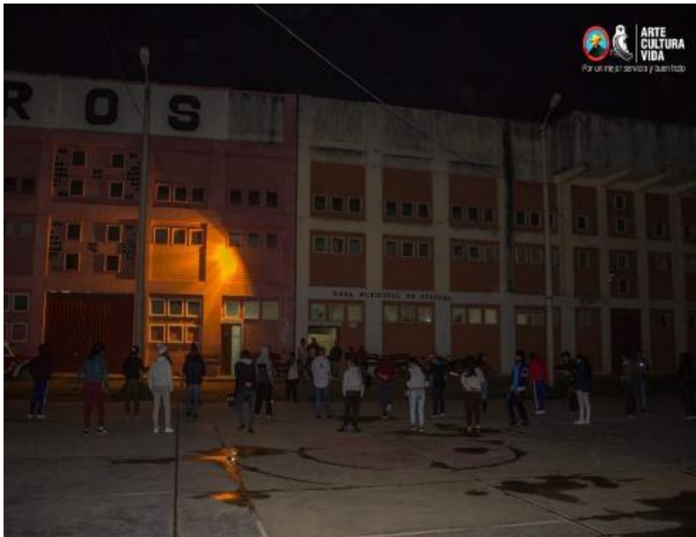
Figura 90: Casa de cultura Huamachuco nivel de servicio y estado actual Fuente: Casa de cultura Huamachuco,2019
