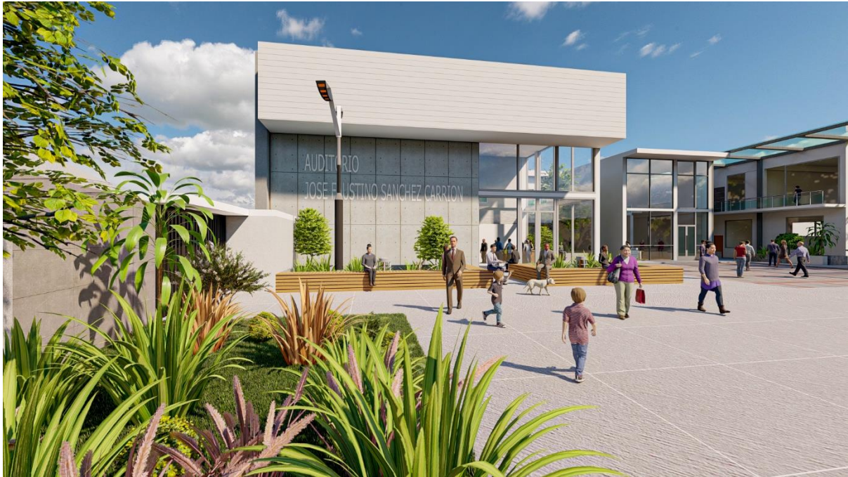
Figura 76. Vista Principal Auditorio
