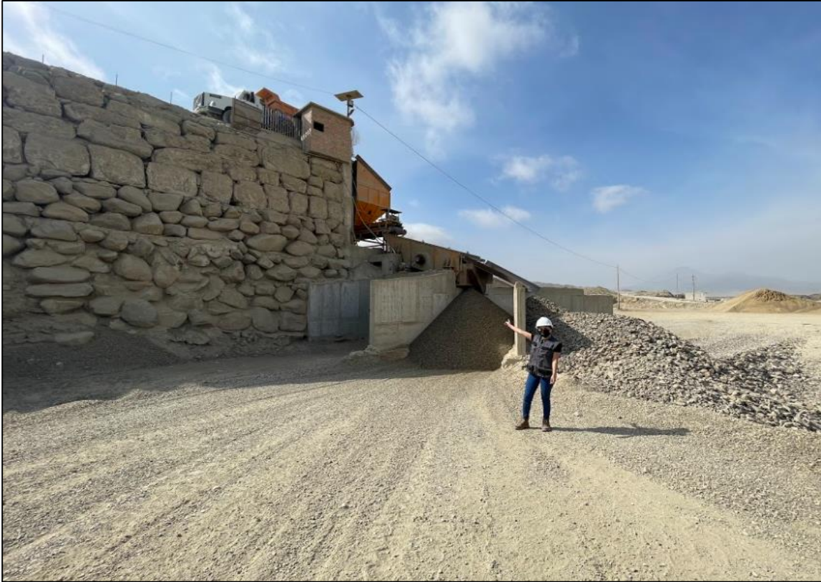
Figura 43. Extracción de agregados fino y grueso de la cantera Quebrada El León – El Milagro – Trujillo.
