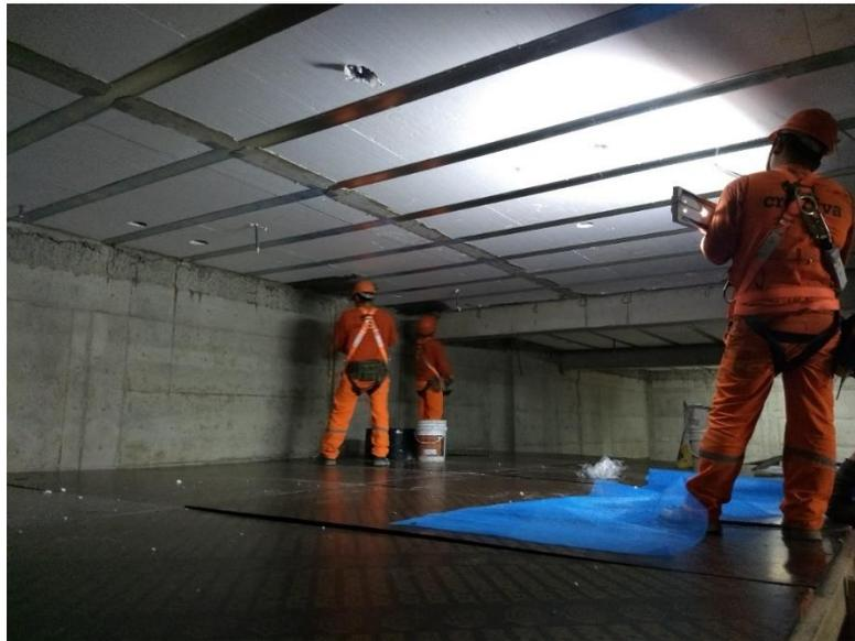
Figura 73: Acabado de losa cielo raso después del desencofrado de losa
