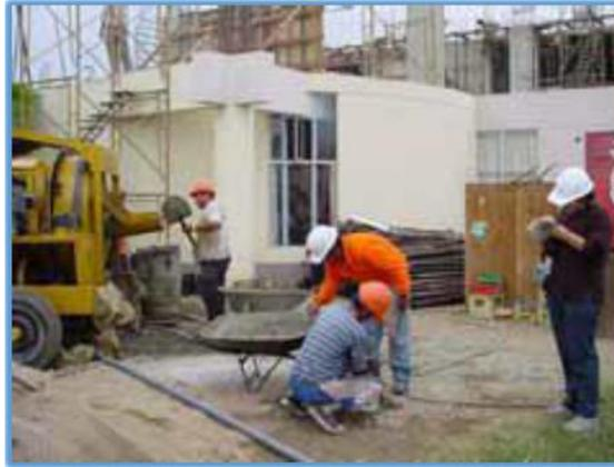
*Figura 37: Preparación concreto de losas*
