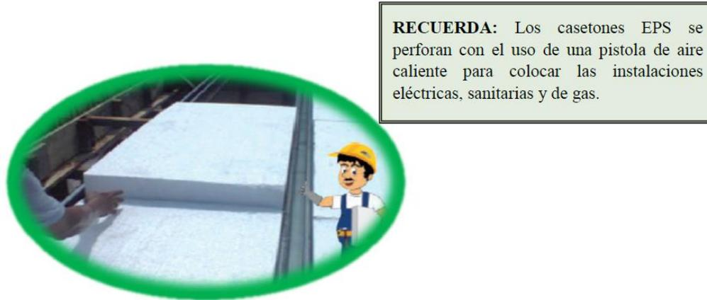
Figura 51: Instalación casetones de EPS
