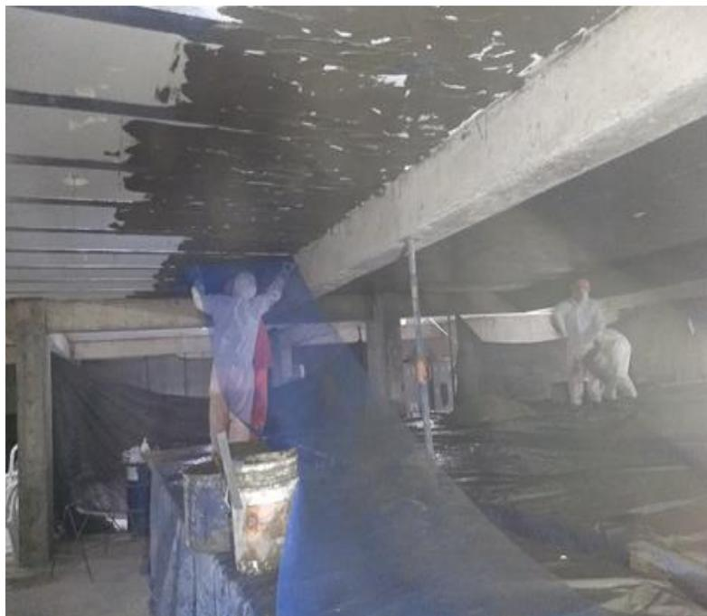
Figura 74: Aplicación de súper malla RF para tarrajeo de cielo raso
