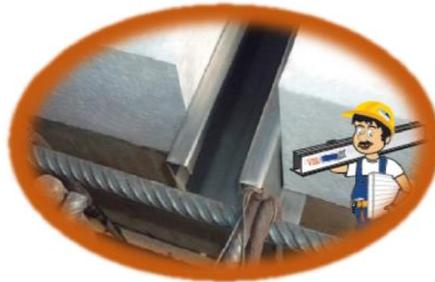
Figura 50: Apoyado vigueta vigacero
