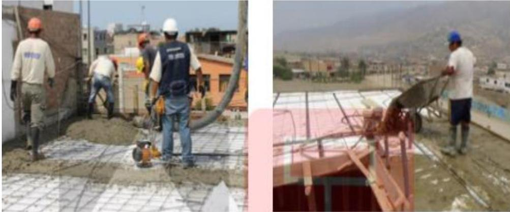
*Figura 14:* El vaciado de una losa aligerada con el sistema Vigacero
