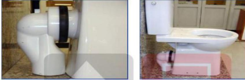
*Figura 10:* Una solución para el inodoro con evacuación horizontal
