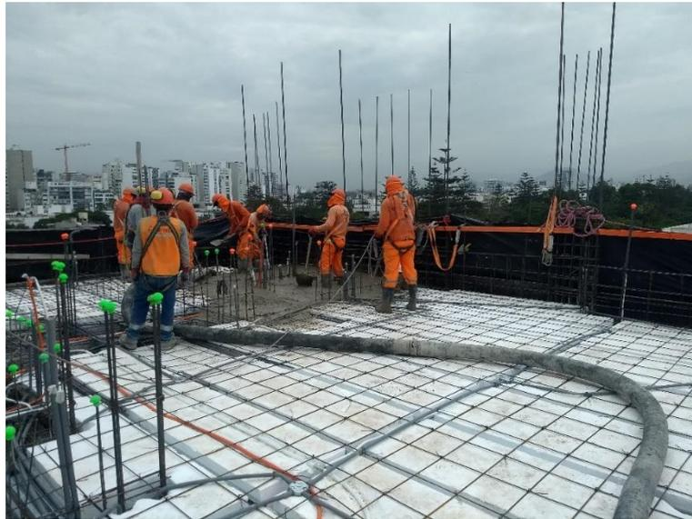
Figura 75: Vaciado de losa aligerada Vigacero piso 10
