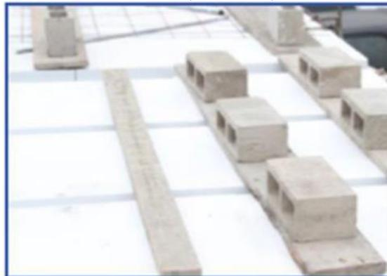
*Figura 5:* Tablones apoyados entre viguetas y vigas de borde, facilitando el paso de personas y materiales en el montaje de la losa.
