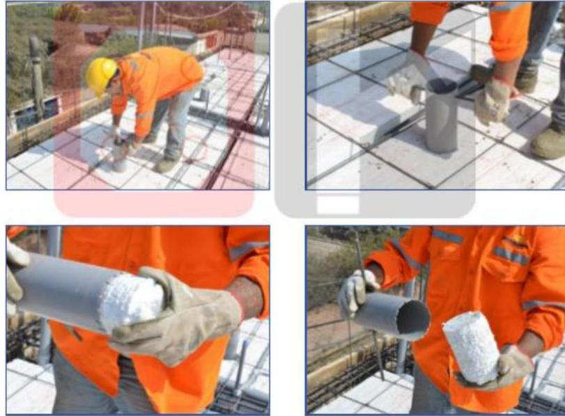
*Figura 6:* La incisión correcta en el poliestireno para el paso de luz
