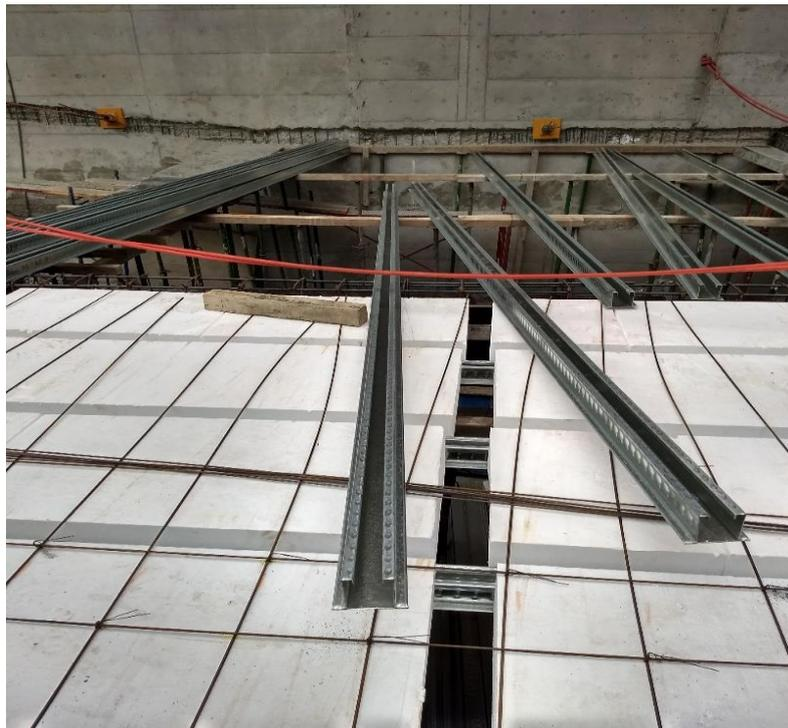
Figura 70: Viguetas de acero estructural galvanizado Vigacero
