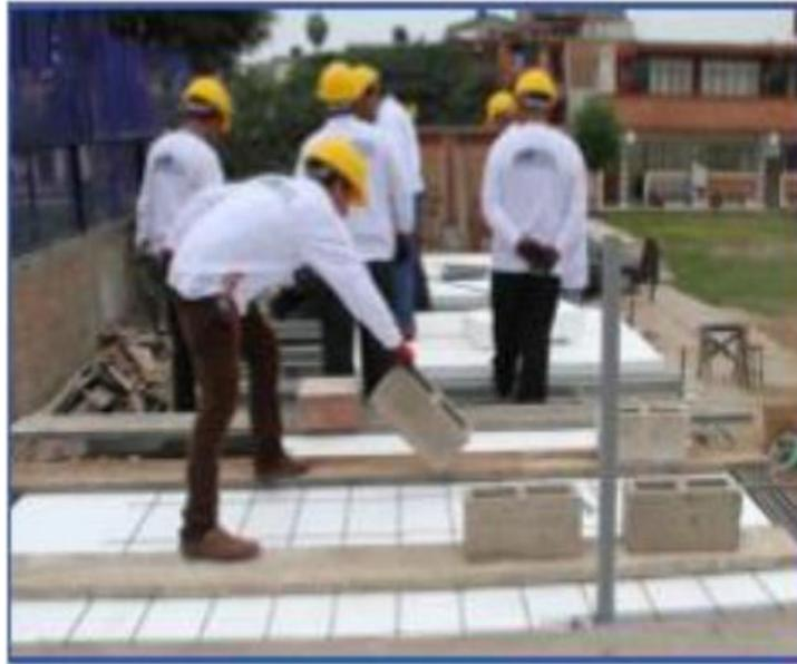
*Figura 4:* Colocación de casetones
