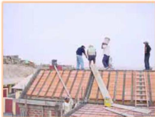
*Figura 36:* Transporte con rampas provisionales
