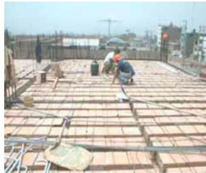
*Figura 34:* Planchas de encofrados en losas y vigas
