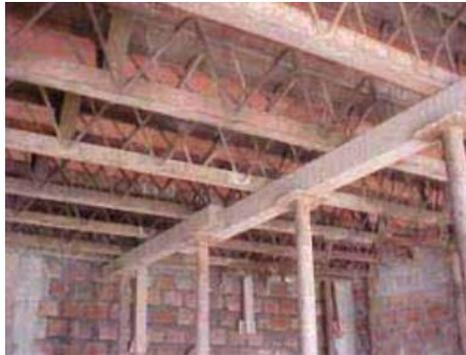
*Figura 33:* Encofrados de madera
