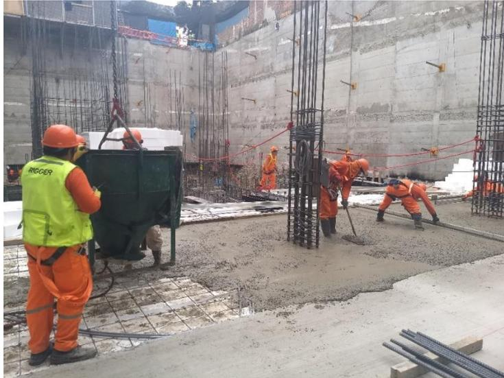
Figura 71: Vaciado de losa aligerada Vigacero sótano 02
