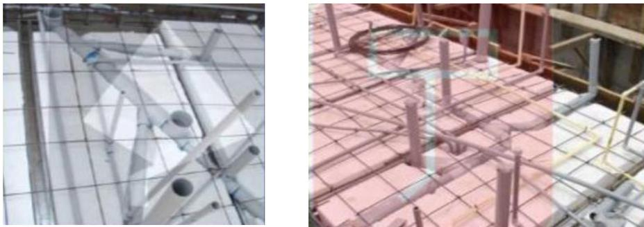
*Figura 9: Instalación de los ductos de agua y desagüe de manera correcta*
