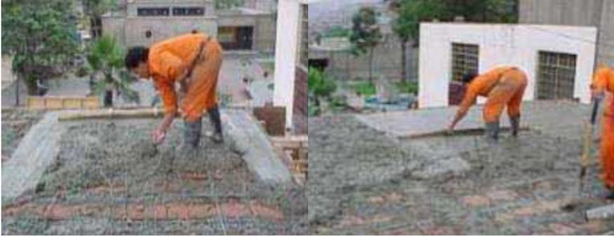
*Figura 39: Vaciado de la losa y llenado de las viguetas*
