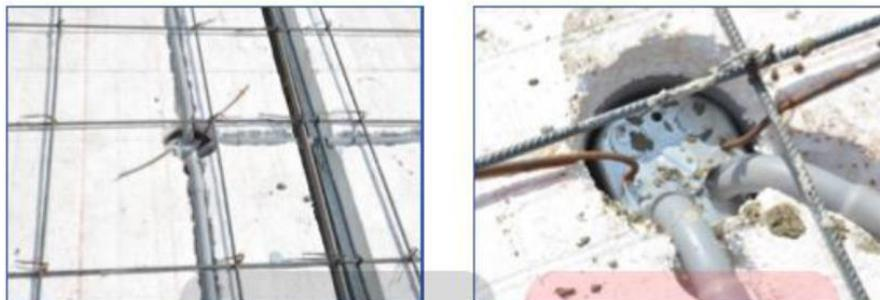
*Figura 7:* Canales de “media caña” para los pasos de las tuberías eléctricas
