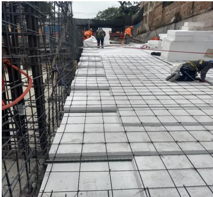
Figura 72: Ensanche de losa rampa ingresó vehicular
