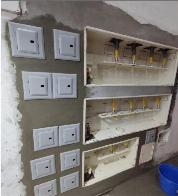
*Nota:* En esta fotografía se observa dos tipos de gabinetes dobles y cuádruples, para alojar al sistema de medición y regulación para la distribución del gas. Asimismo, las válvulas de corte con compuertas para acceso al usuario. Tomada de OM CONSTRUCTOR SAC. (2021, June 4). <https://omconstructor.com/>.
