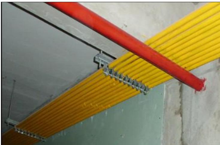
*Nota:* La fotografía muestra las tuberías de gas de cobre se pinta de amarillo, colgadas en techo con dirección hacia los bancos de medidores, para la distribución del gas natural a los departamentos. Asimismo, se observa el cruce de las tuberías a gas con otras instalaciones, las cuales deben presentar una separación mínima de 5 cm aproximadamente.
