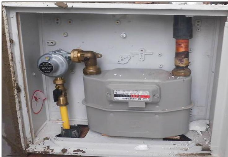
*Nota:* Esta figura muestra un sistema de regulación y medición instalado en gabinete simple.
